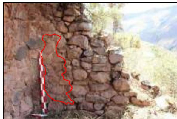
*Nota.* Cara interna NE del muro, donde se observa colapso de parte del muro, además de la presencia de revoque grueso.
