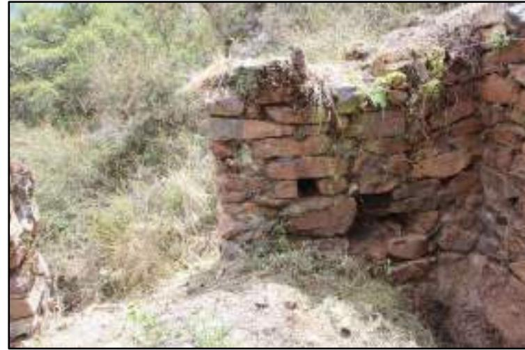
**Nota.** Cara interna del muro oeste del recinto N° 08 (lateral derecho), donde se aprecian desprendimiento de líticos a nivel superficial hacia la esquina noroeste.
