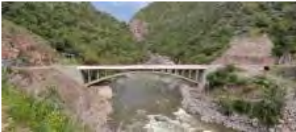
Vista Panorámica del Puente San Juan
