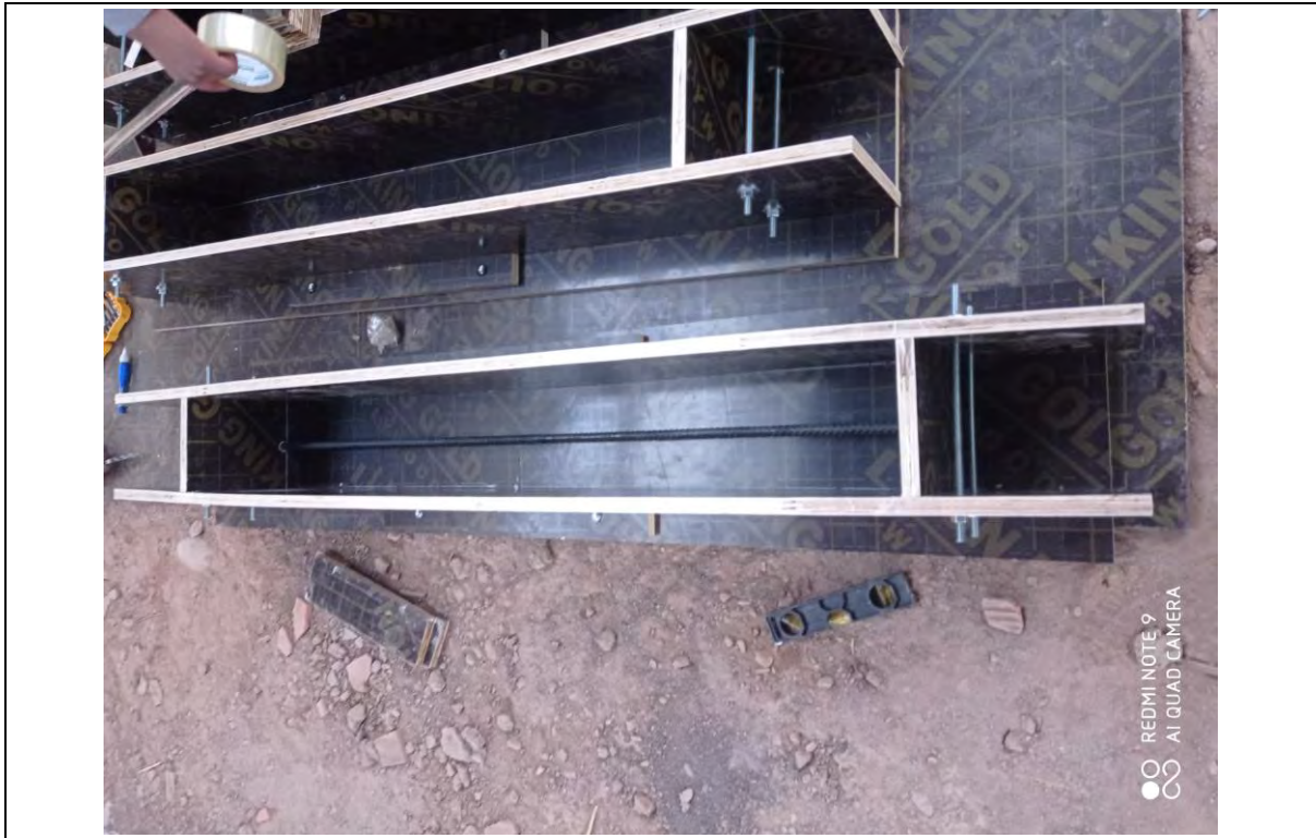
Moldes con fenólico para el vaciado de vigas
