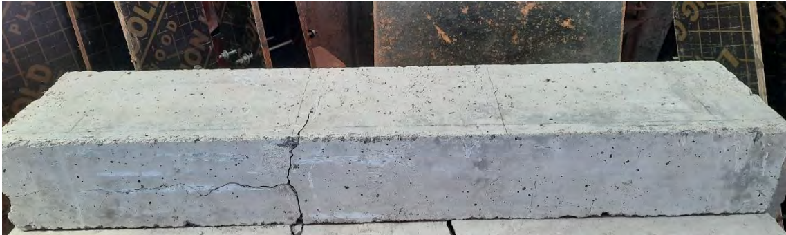
Viga N° 02 con 1% de fibra de acero – gráfica y carga máxima aplicada
