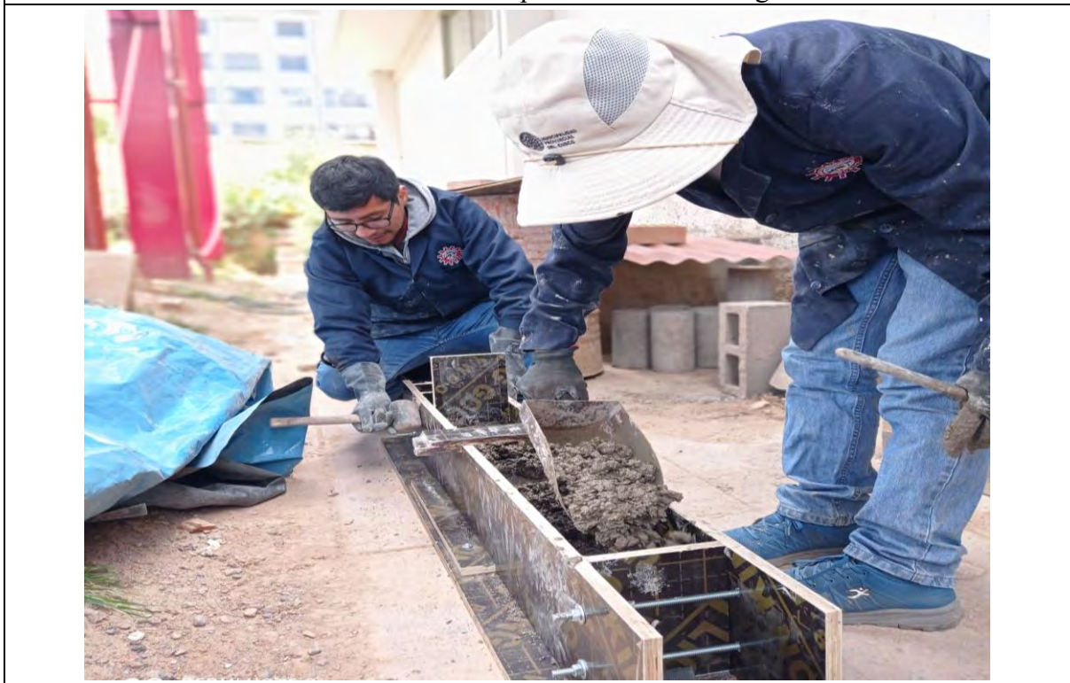
Vaciado de concreto en vigas
