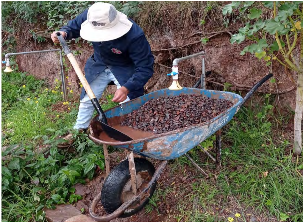
Lavado de agregado fino y grueso
