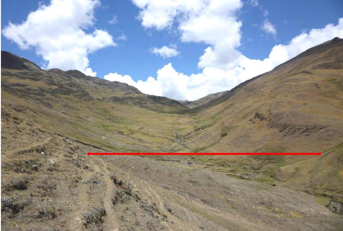
*Ubicación del eje de la presa y los estribos sobre afloramientos rocosos.*
