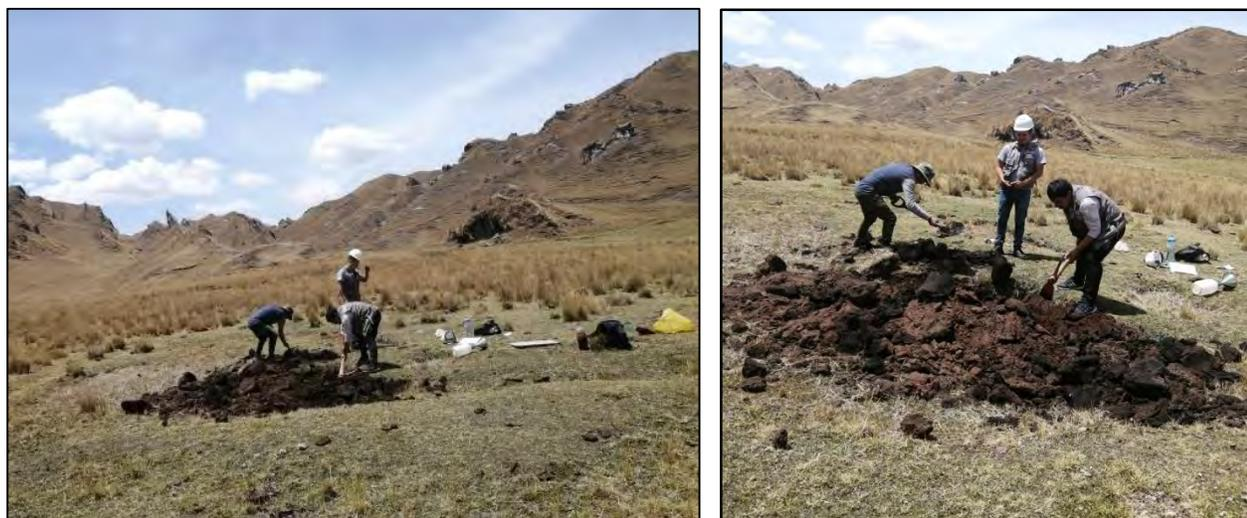
Fotografía 22, 23: Vista de la excavación de calicatas para la posterior caracterización del suelo.
