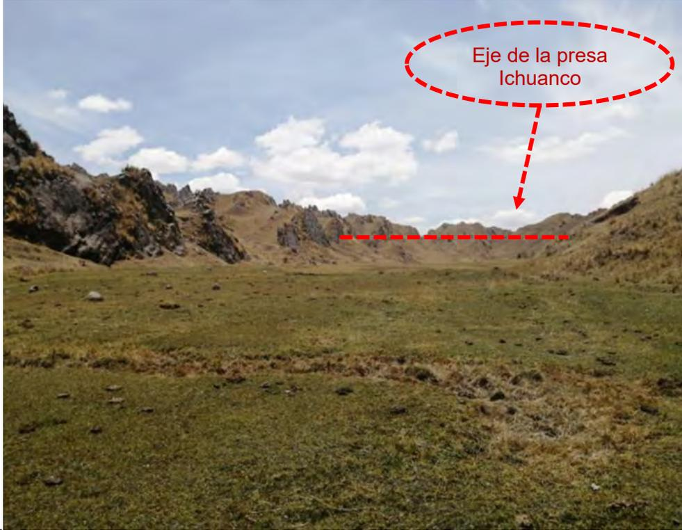
*Ubicación del eje de la presa proyectado, determinado sobre afloramientos rocosos en ambos estribos*
