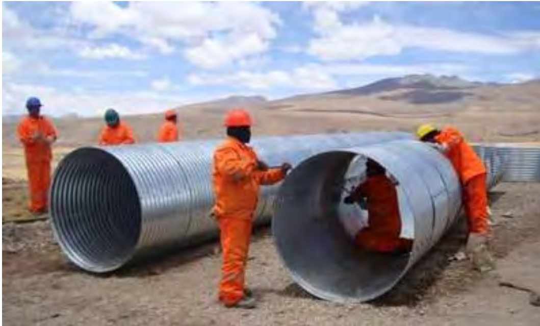
Figura N° 76 Alcantarilla tipo TMC
