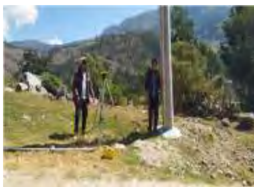
Ubicación de la Mira Topográfico en el BM-01, en el tramo I.
