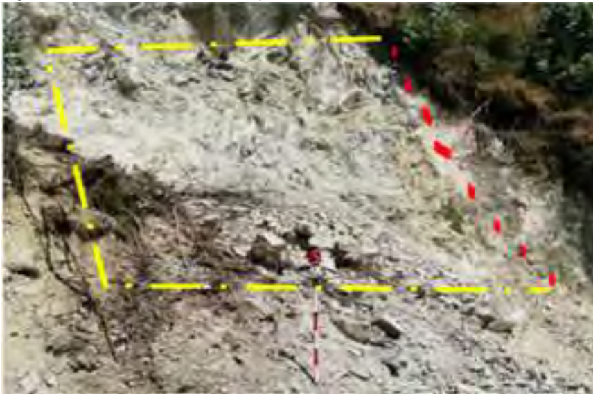
Figura 6.15. Zona más crítica del trayecto Km 02+000
