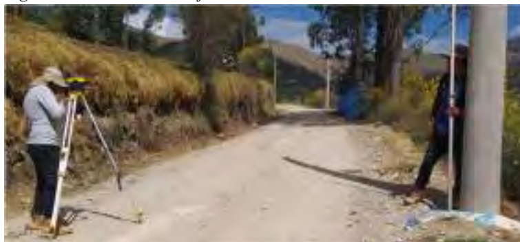
Figura 3.6. Nivelación del eje de la vía
