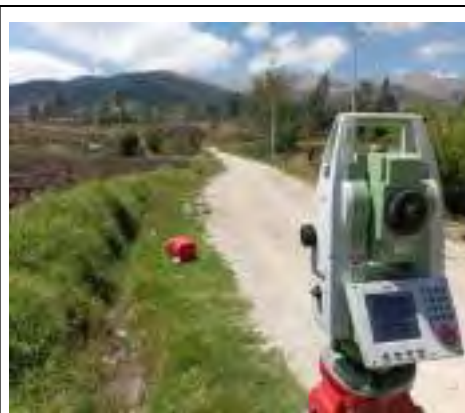
Levantamiento topográfico con la ESTACIÓN TOTAL LEICA, tramo I.
