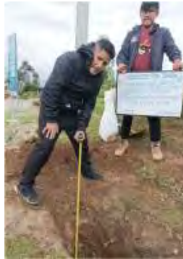
Calicata N°05 KM: 00+362 – entre el centro poblado Trancapata baja - vacas. Material fino de limo y arcilla plastidad baja color marrón oscuro con textura limosa arcillosa.
