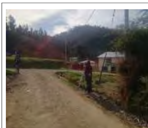
Levantamiento topográfico con la ESTACIÓN TOTAL LEICA, tramo II.
