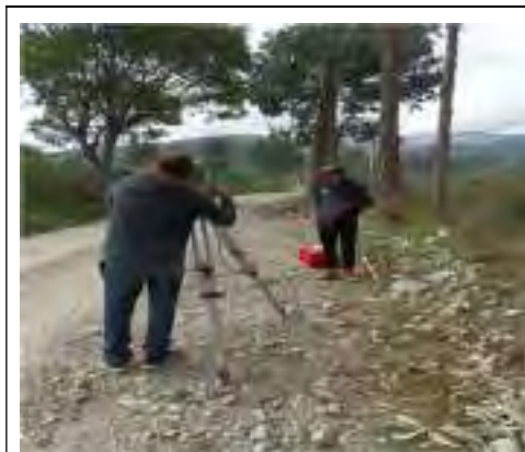
Instalación de la ESTACIÓN TOTAL LEICA al inicio del tramo I de la vía, Trancapata baja.
