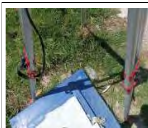
Instalación de la ESTACIÓN TOTAL LEICA, sobre un punto de cambio.
