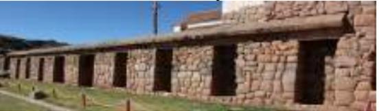
Decorado con doce hornacinas de 2 m de alto y 1.50 m de ancho con un moderno alero lítico que las cubre y protege por encima. Este muro de contención esta realizado con poliedros ensamblados a la dando forma al anden.
