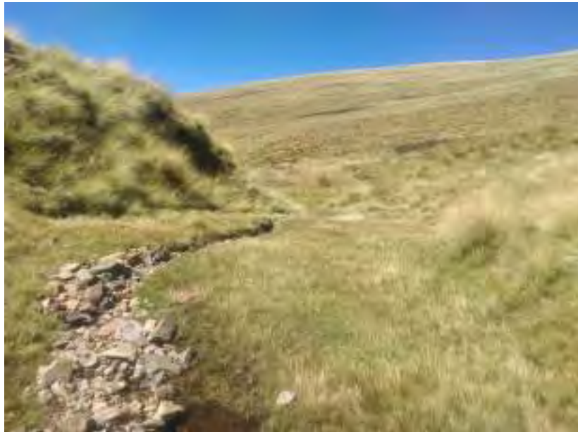
Figura 27: Vista panorámica de una parte de la cuenca Chocayhua.
