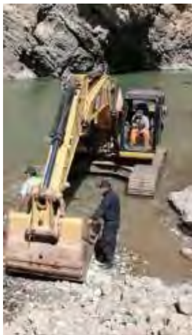
Figura 111: Sacado de material del rio para la producción de los agregados.
