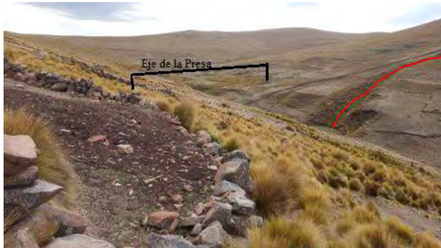
Figura 40: Falla 2 inferido en zona de estudio con presencia de escarpa y la ubicación del eje de la presa.
