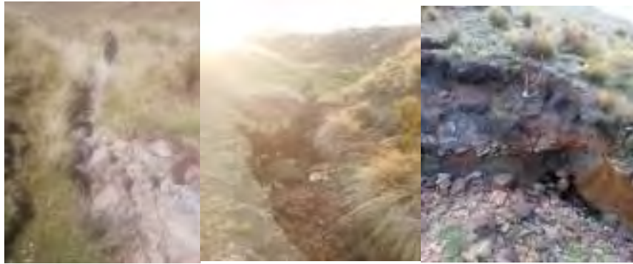
Figura 82: Cauce erosivo del rio Chocayhua véase los derrumbes que se producen por socavación en la rivera.
