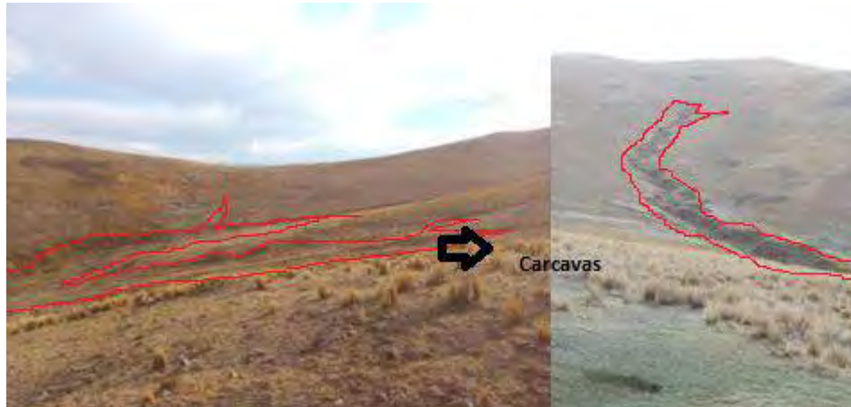
Figura 81: Se aprecian los sistemas de cárcavas en la ladera Nor-oeste del vaso de la presa
