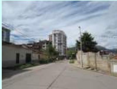
Figura 74 VISTA C: JR. ANCASH
