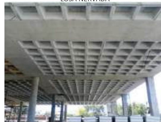
Figura 258 LOSA NERVADA
