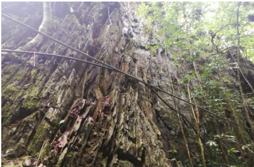
Foto 3: Vista frontal del afloramiento de pizarras, con presencia de una fuerte oxidación (E 777941 - N 8602764).
