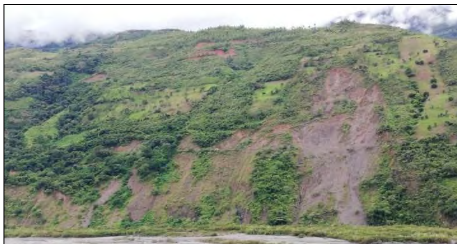
Foto 10: Deslizamiento activo en vertiente fuertemente empinada, Sector de Santiago.
