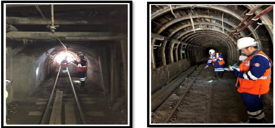
Imagen 17: Toma de datos en las estaciones secundarias
