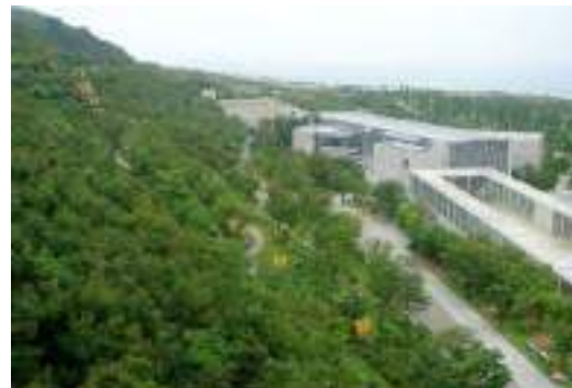
Fotografía 2.6-5: Vista exterior de accesibilidad en el Awaji Yumebutai. Fuente: http://www.geocities.ws/html , 2008
