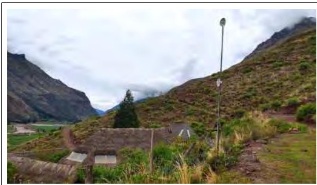
Es necesario precisar que se realizó una pequeña variante respecto a la ubicación del mástil, en la cual se instaló las antenas, que inicialmente estaba a 13°26'24.52"S y a 71°50'21.84"O, colocándolo a 8 metros más arriba de lo estipulado en la simulación, con el fin de ganar altura y colocar únicamente un mástil de 9 metros de alto en vez de una torre tipo atirantada de 16 metros de alto que es más costoso y complejo de instalar.
