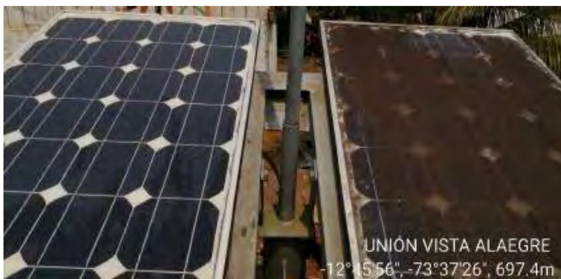
Figura 69: Limpieza de los paneles fotovoltaicos (Elaboración propia).
