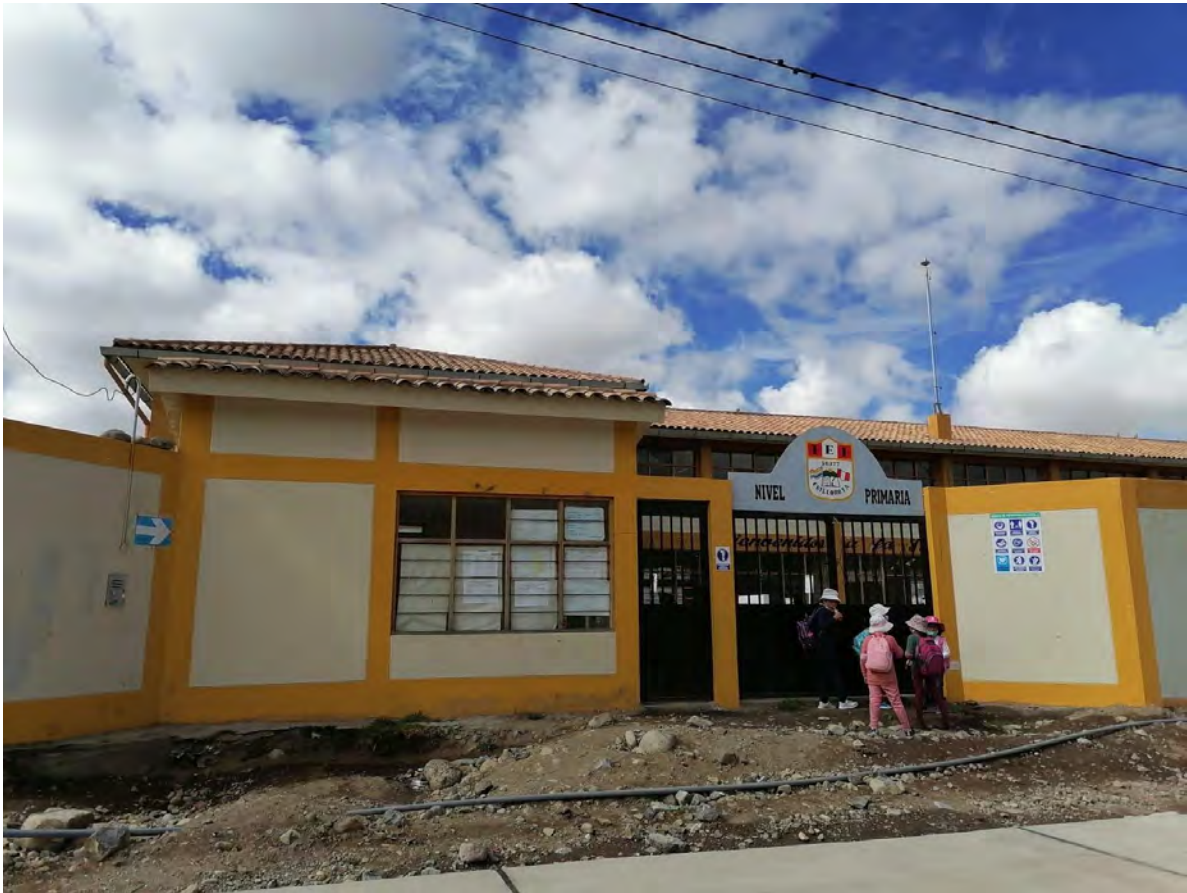
PORTADA DE LA I.E. No 56377 CHILLOROYA, CHUMVIBILCAS
