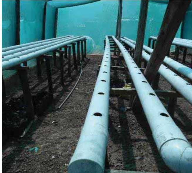
Fotografía 03: Nivelado de tubos hidropónicos
