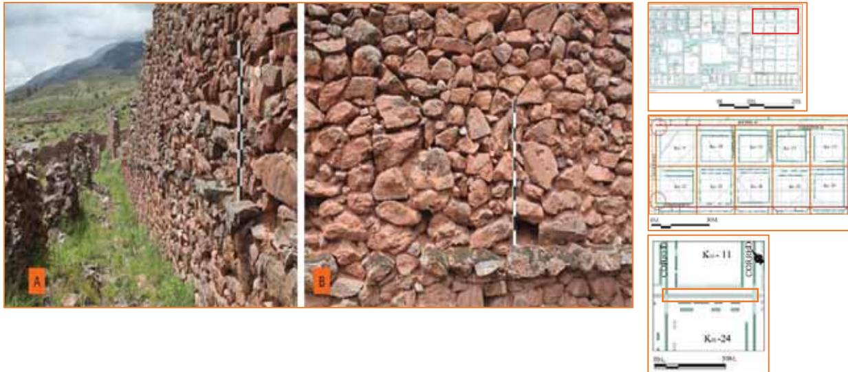
Nota. Nótese las ménsulas y orificios de soporte estructural en el muro divisorio. **A**, Vista lateral de los elementos. **B**, Vista frontal de los mismos. Fuente: Fuente: Plano modificado de DDC-Cusco 2014 y Archivo personal.
