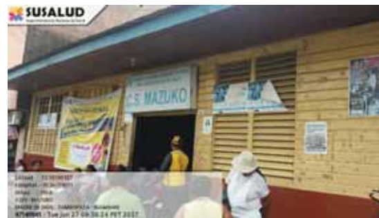
Foto 1: actual estado de conservación del C.S. Mazuko.
