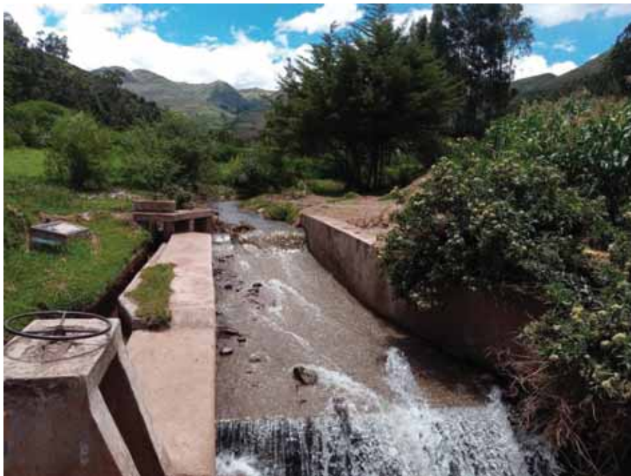
Foto 11. Foto bocatoma sector “Chanchería”
