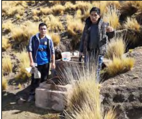
Figura 31, Vista de la captación Huayllapuquio
