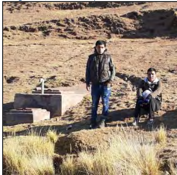
Figura 33. Vista de la captación Quello Orcco 1
