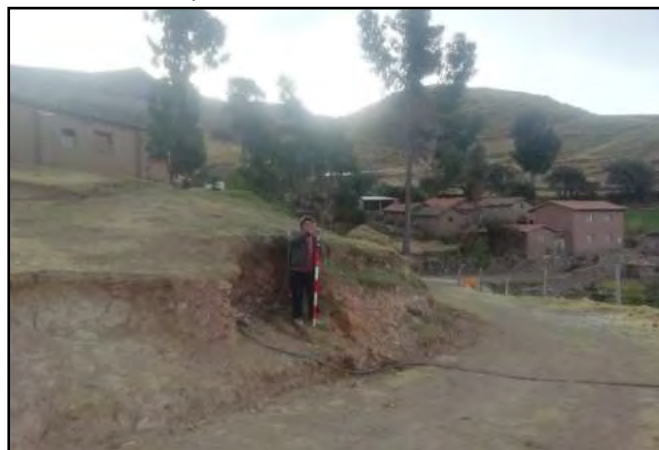
Figura 44, carretera en el poblado de Canchanura se observa material rocoso fracturado en los taludes, lo cual garantiza un buen comportamiento del terreno frente a factores climáticos externos.
