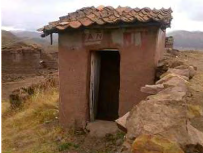
Figura 17, Unidad Básica de Saneamiento, en estado de colapso.
