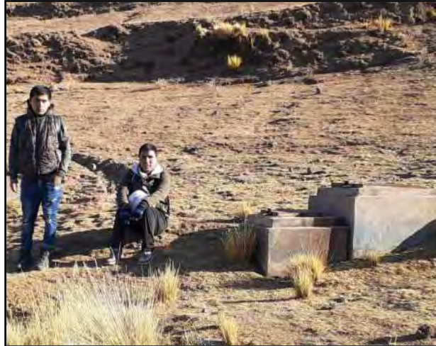
Figura 34, Vista de la captación Quello Orcco 2
