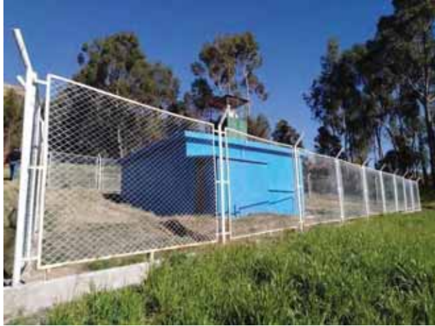
Reservorio de agua potable de la comunidad.
