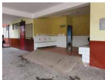
Se observa en la fotografía que la pendiente de la rampa es pronunciada.
