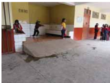
Se puede observar que se levantó el nivel de piso.
