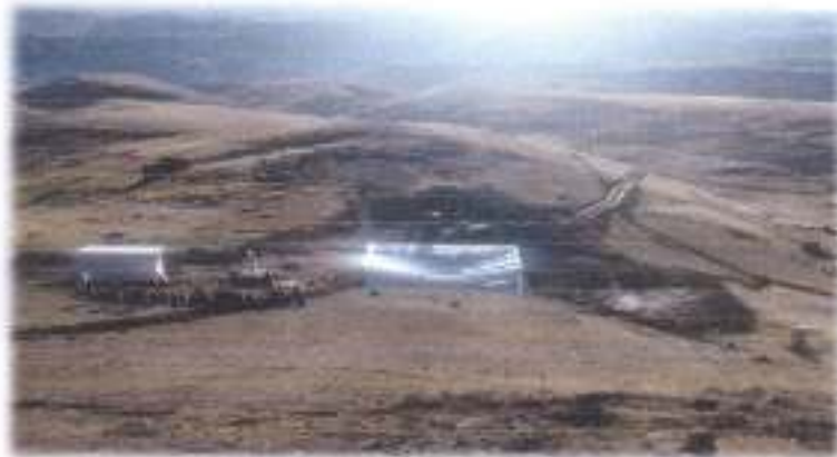
PROTECCION DEL VACIADO DEL PISO DEL RESERVOIRIO CON LA FINALIDAD DE CONTRARESTAR LA HELADA EN LA ZONA
