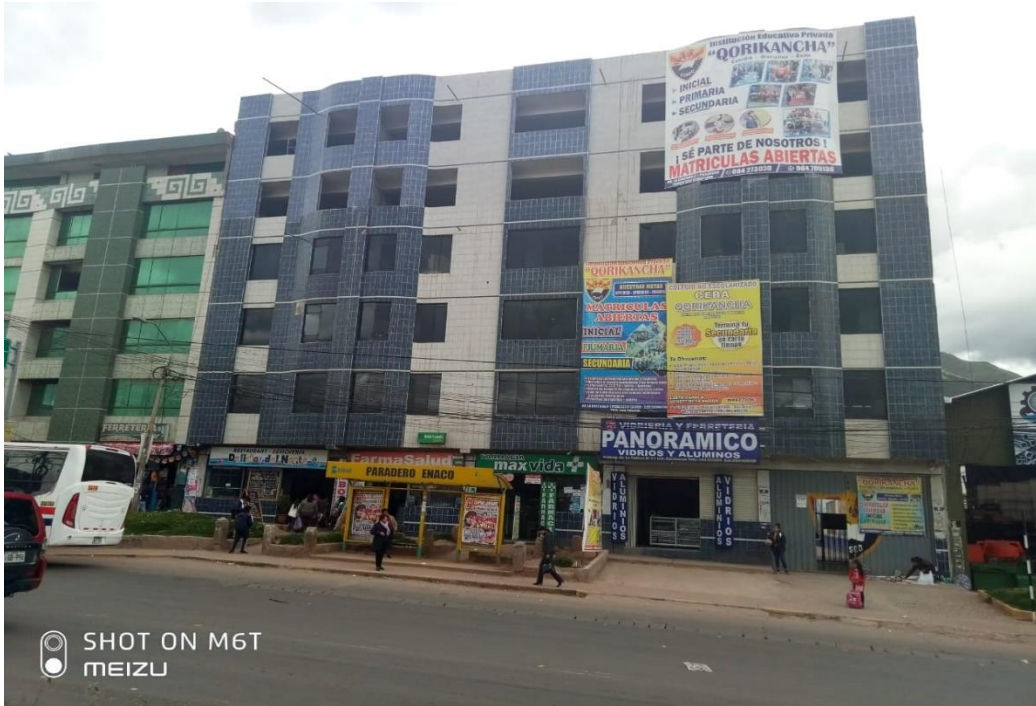
Foto 10: La Institución Educativa Privada Qorikancha está ubicado en el Distrito de San Sebastián, provincia y departamento Cusco.
