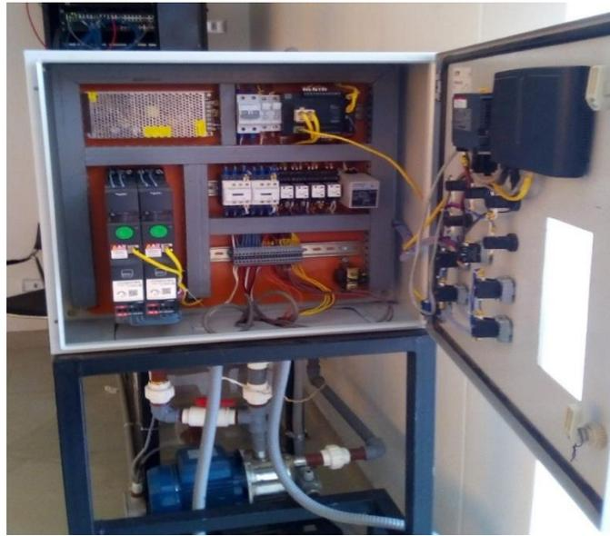
Figura nro. 2 - Tablero de control del sistema de bombeo de agua a escala - Fuente: propia.
