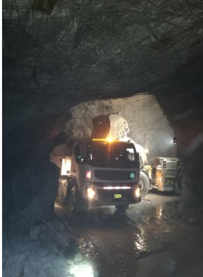
Ilustración 46. Carguío de material a volquetes de 30 toneladas
