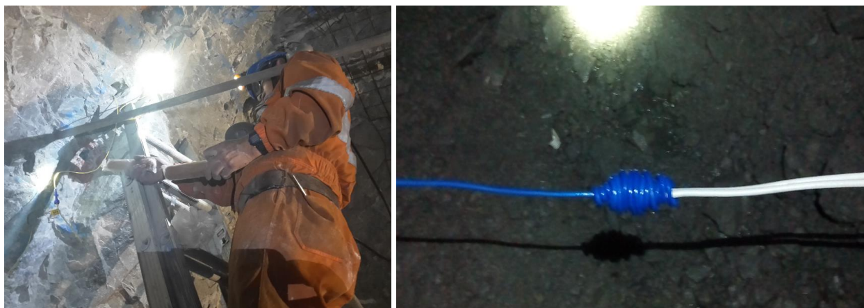
Ilustración 10. Carguío manual de frente con dinamita
