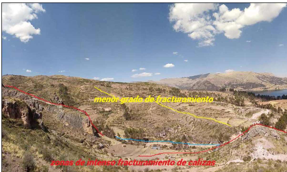
Fotografía 5.6 Afloramientos de calizas con mayor grado de fracturamiento
