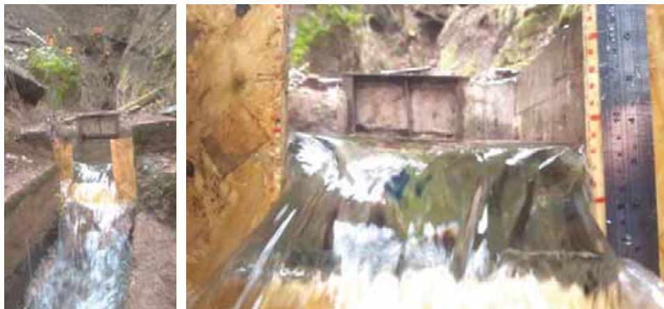
Fotografía 12: Aforo de agua mediante un vertedero rectangular
