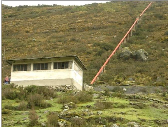
*Foto N° 4.7:* Tubería de presión sobre apoyos y casa de máquinas.
