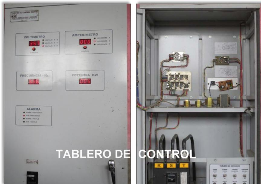
Foto N° 4.17: Exterior del tablero (izquierda), interior del tablero (derecha).
