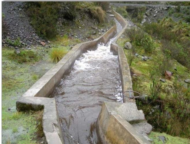
*Foto N° 4.4:* Desarenador, compuerta y canal de limpia.
