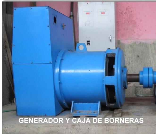
*Foto N° 4.16:* Generador junto a la caja de borneras y conexiones.
