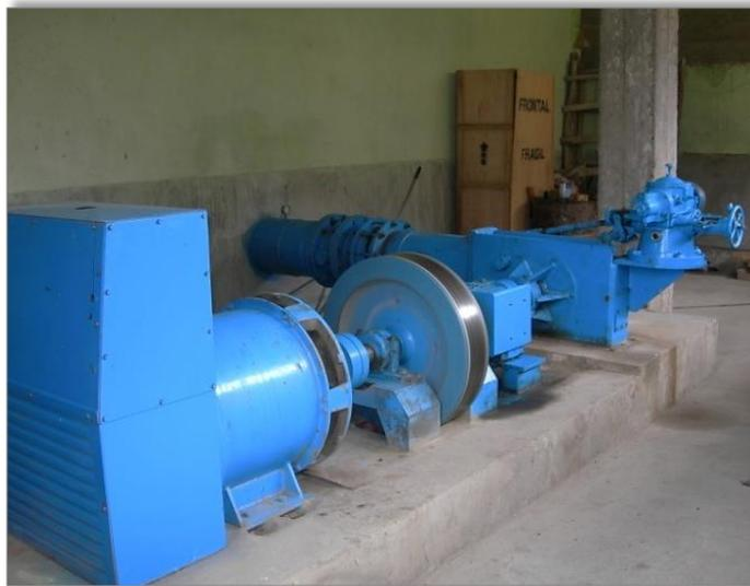
*Foto N° 5.1:* Casa de máquinas con los equipos hidroeléctricos.
