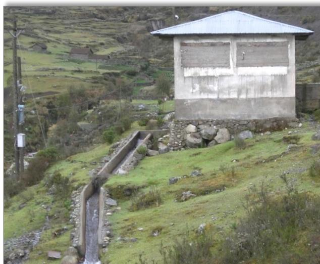
Foto N° 4.9: Canal de descarga junto a la casa de máquinas.
