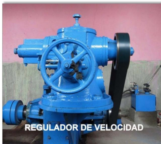
Foto N° 4.12: Regulador de velocidad oleomecánico y bomba hidráulica.
