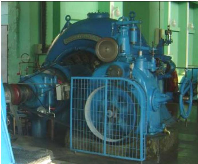
*Turbina con regulador de velocidad mecánico.*
