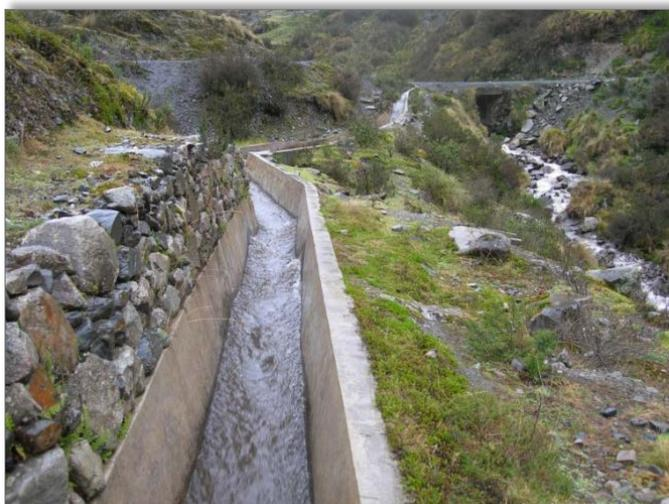
*Foto N° 4.5:* Canal de conducción trapezoidal y abierto.
