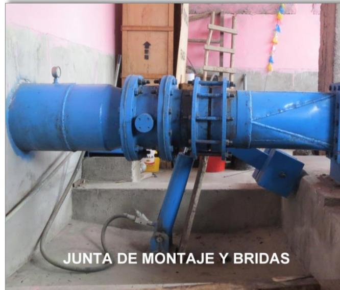
Foto N° 4.11: Bridas entre la válvula mariposa y junta de montaje.
