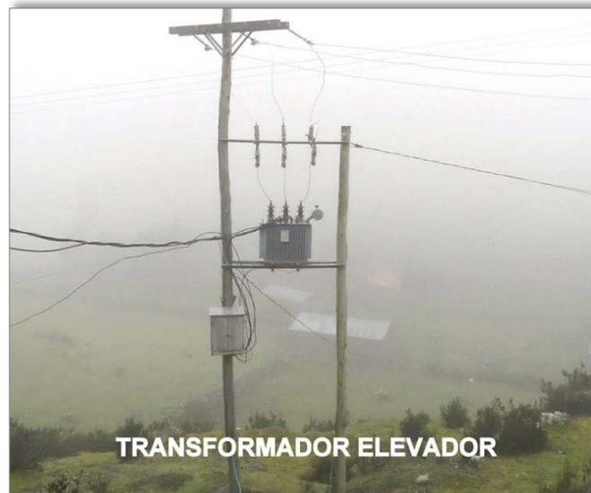
*Foto N° 4.18:* Transformador de la sub estación sostenido en postes.
