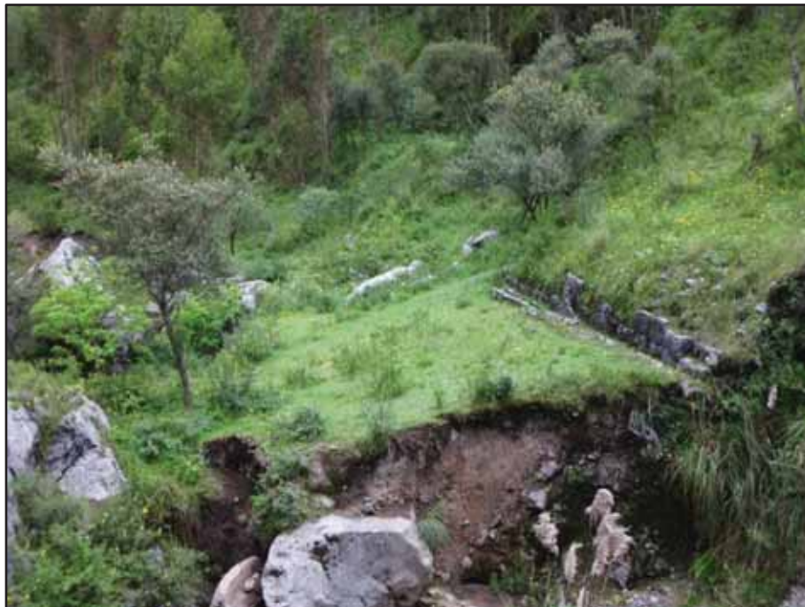
Figura N° 15.- Vista general del espacio abierto 2, nótase el muro de contención y al pie de ella casi adosado al muro un canal de piedra.
