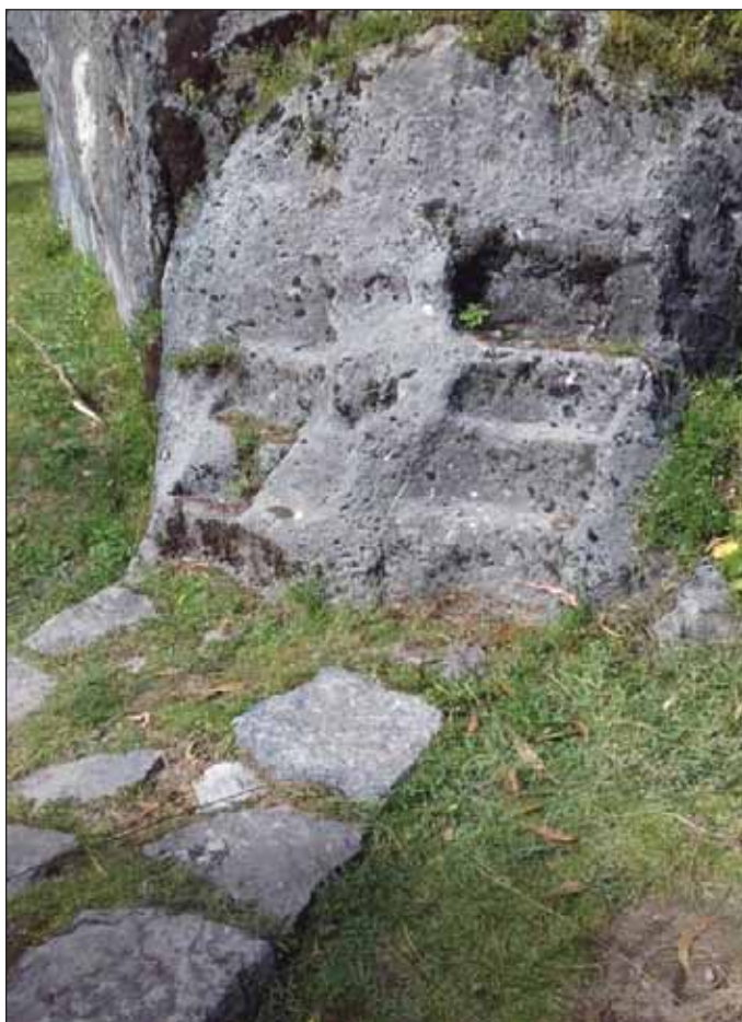
Figura N° 6.- Detalle de la cimentación del muro y de las huellas donde se apoyaba el muro sobre la roca.
