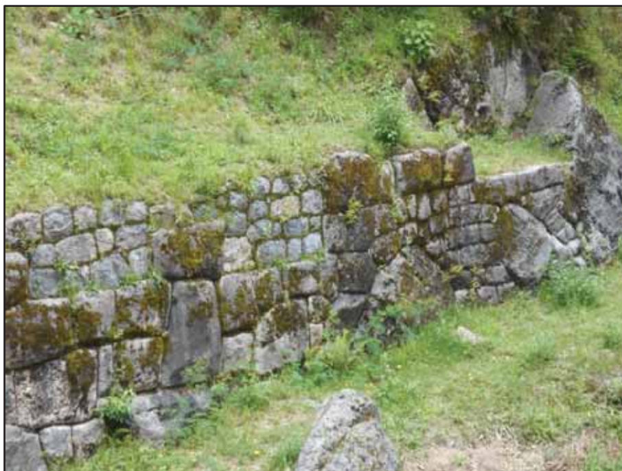
Figura N° 29.- Muro fino sobre el afloramiento rocoso a la margen izquierda del río Chakán
