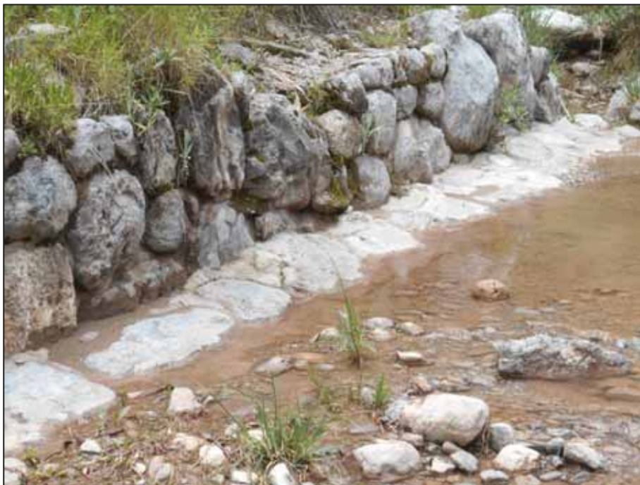
Figura N° 28.- Vista del encausamiento y de la solera del río Chakan.
