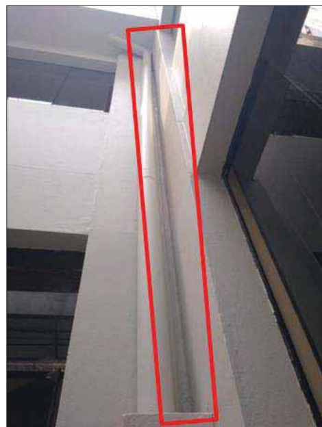
Figura 58. Separación entre el Bloque C y el Bloque B
