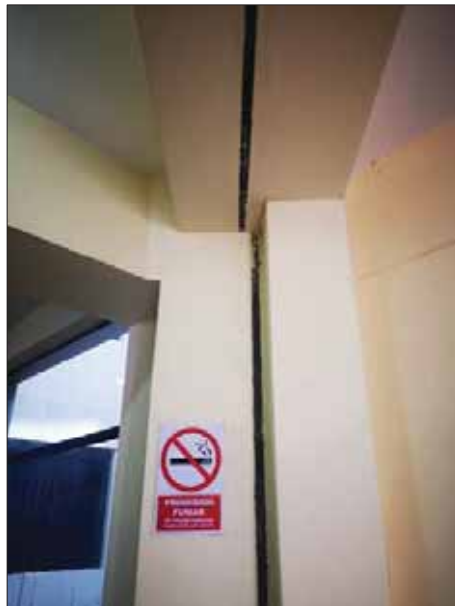
Figura 51. Separación entre edificaciones
