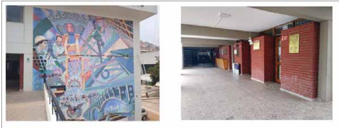
Figura 62. Muros de Albañilería aislados de la estructura principal
