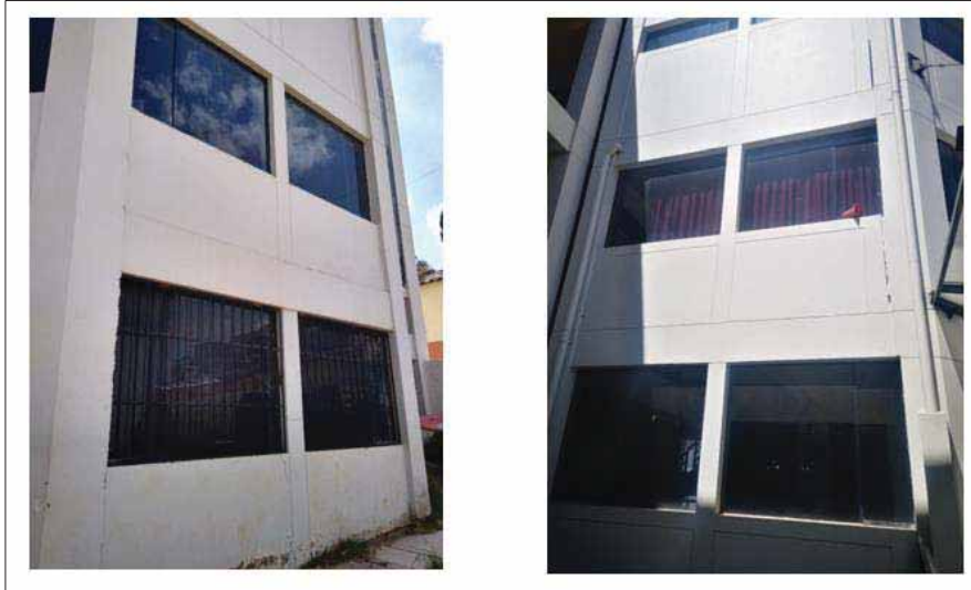
Figura 55. Parapetos de las ventanas
