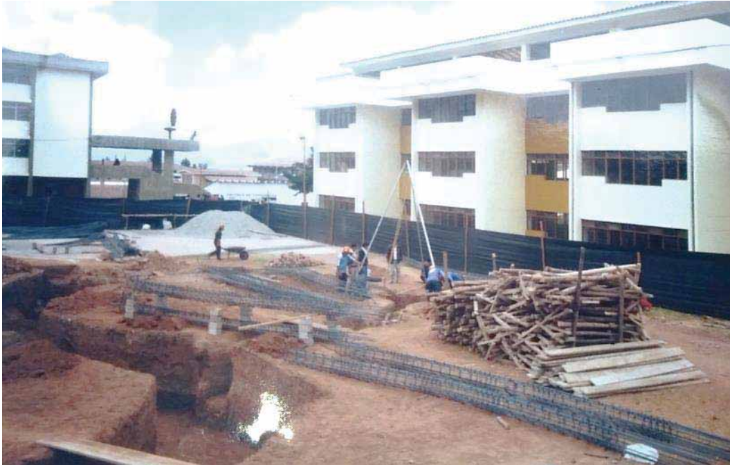
Figura 43. Estudio de suelos antes de la construcción de la Edificación Nueva
