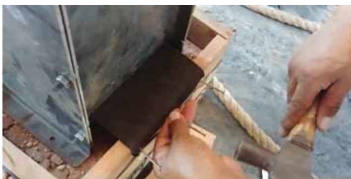
Fotografía N°35: tensado longitudinal ligero del geotextil
