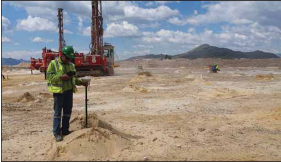
Levantamiento de Taladros de Perforación – Tajo Calaorco
