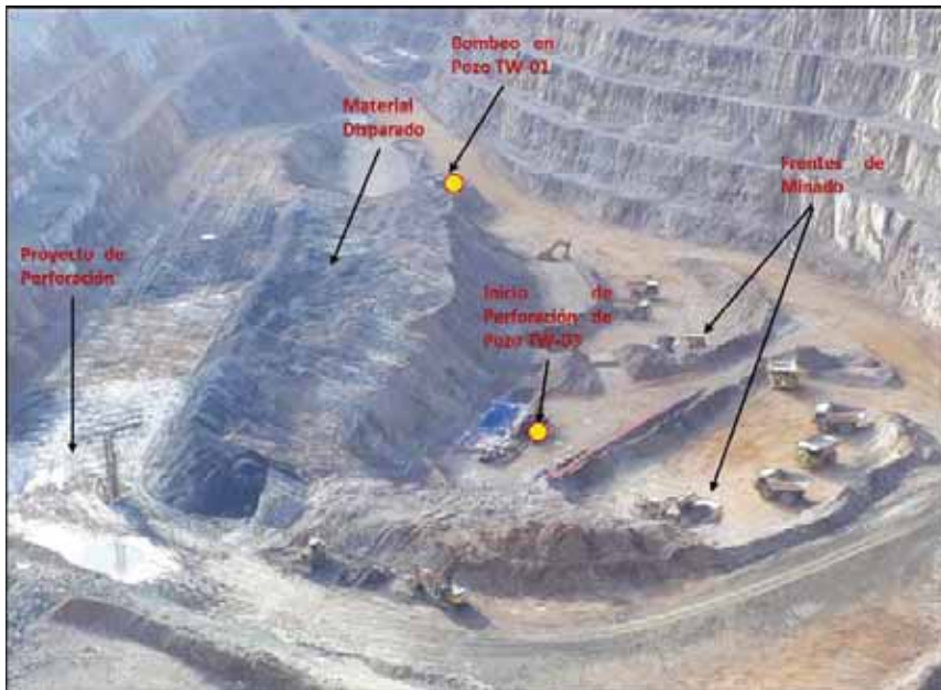
Inspección en Campo – Tajo Calaorco
