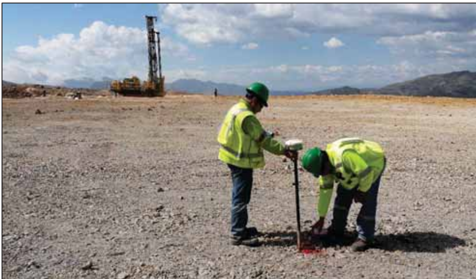
Replanteo de Mallas de Perforación – Tajo Calaorco
