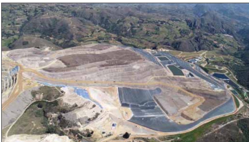
Figura 45 Foto Pad de Lixiviación U.M. La Arena
