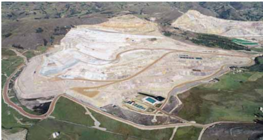
Figura 40 Foto Botadero 02 U.M. La Arena
