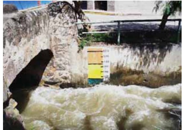
Fotografía N°16: A la altura de la plaza mayor de Calca se observa la canalización del río Qochoq con una altura de 2.20 m. y ancho de 15 m.
