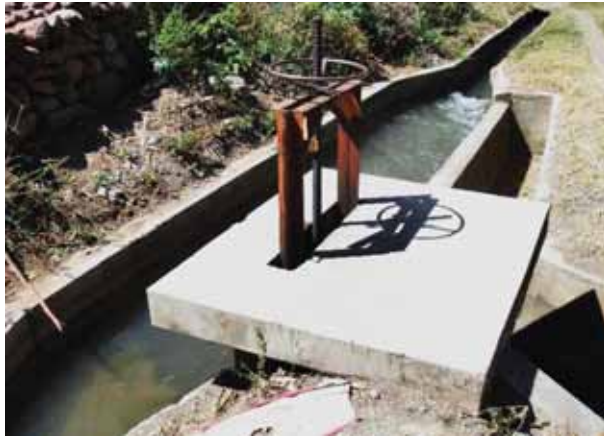
Fotografía N°13: Se observa la presencia de una obra de captación del caudal del río Qochoq
