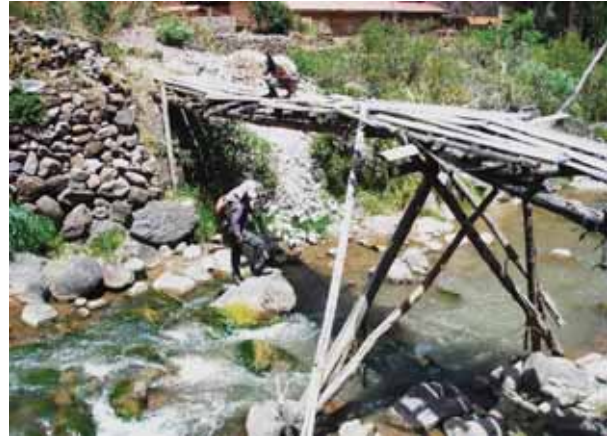
Fotografía N°8: Se aprecia la medición de la altura del puente de madera con presencia de rocas de gran tamaño
