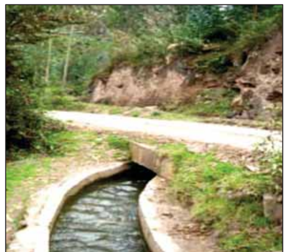
Imagen 2: Laderas antrópicas o artificiales por construcción de infraestructura vial e hidráulica. Adaptado de PREDES
