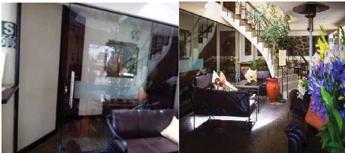
Ilustración 13: Se colocaron vidrios laminados en la entrada de las habitaciones del primer piso para la climatización eficiente.
