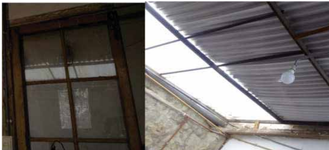
Ilustración 22: se hizo el respectivo revestimiento con vidrio laminado para la puerta y el techo también fue revestido para evitar el exceso de calor.
