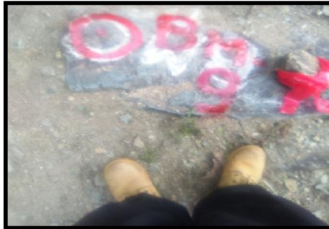
IMAGEN N° 6. PINTADO DE PUNTOS TOPOGRAFICOS, BASICAMENTE SOBRE ROCAS EXISTENTES.
