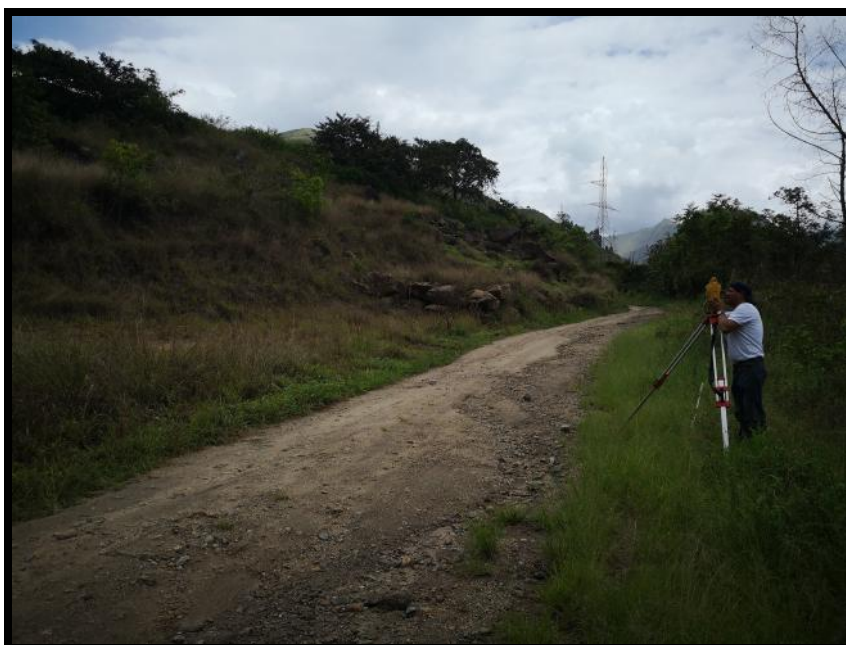
IMAGEN N° 18. REALIZACION DEL ESTUDIO TOPOGRAFICO EN LA ZONA DE ESTUDIO DE LA FUTURA CARRETERA MESADA - HUILLCAR
