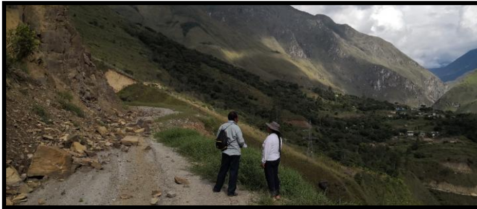
IMAGEN N° 11. ANTIGUO TRAZO DE LA VIA, DONDE SE APRECIA INESTABILIDAD DEL TERRENO
