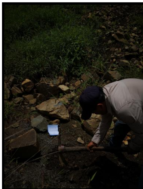
IMAGEN N° 19. REALIZACION DEL POZO DE INSPECCION (CALICATA) EN EL SUELO PARA SU POSTERIOR ESTUDIO DE GEOTECNICO DEL SUELO EN LA ZONA MESADA – HUILLCAR.
