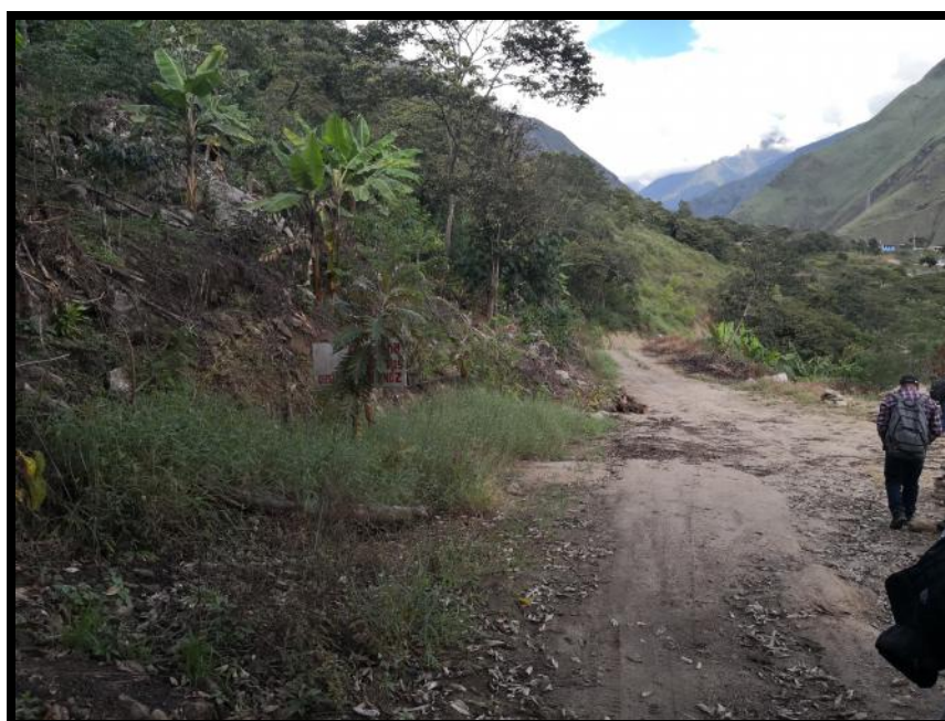
IMAGEN N° 15. RECONOCIMIENTO E INSPECCION DE ANTIGUO TRAZO DE LA VIA PARA SU POSTERIOR ANALISIS DE ACUERDO A LA NORMATIVIDAD VIGENTE.
