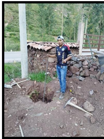
Ilustración 48; vaciado de zapatas
