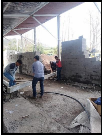
Ilustración 49(a) (b): traslado e izado de columnas prefabricadas.
