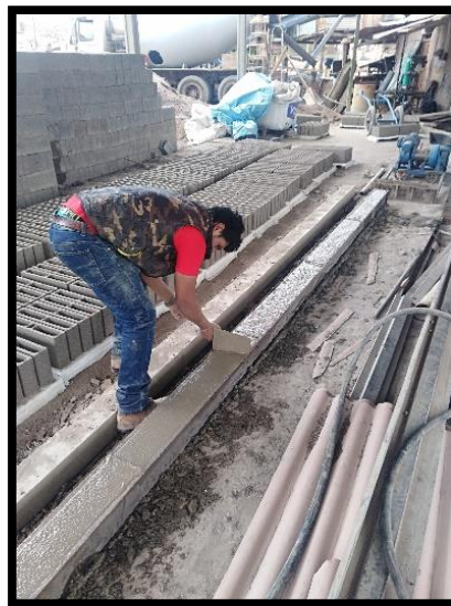
Acabados de viga.
