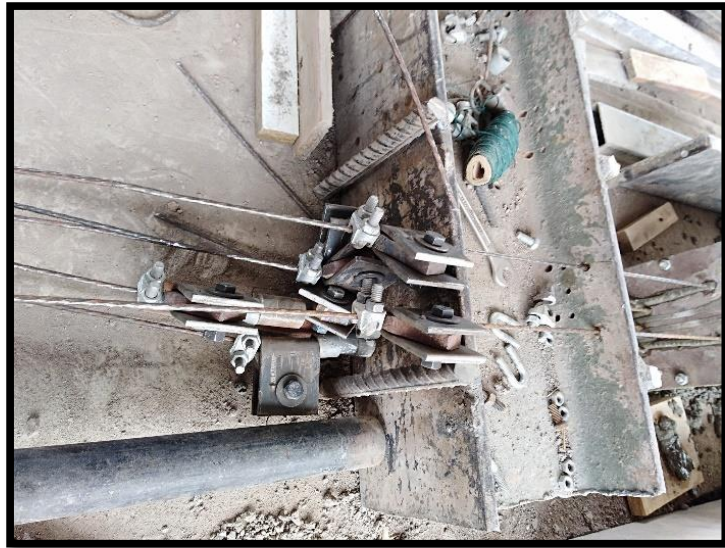
Fijación de alambre con grapas.
