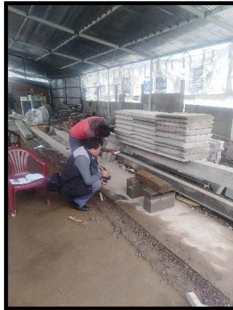
Resultado de fisuras producidas por la aplicación de la carga.
