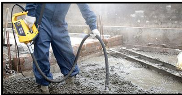
Ilustración 28: vibrado de concreto
