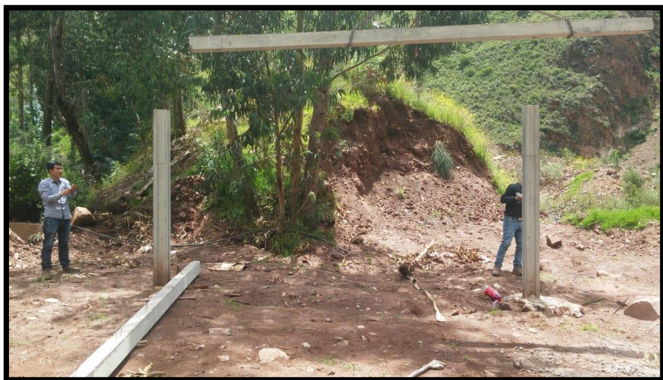
Inicio de montaje de vigas pretensadas.
