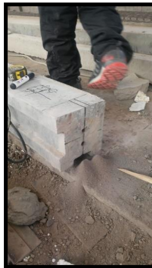
Proceso de perforación de columna para empotramiento de varillas enroscadas.
