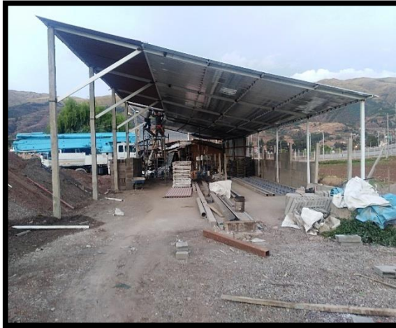
Techado de área de pretensado
