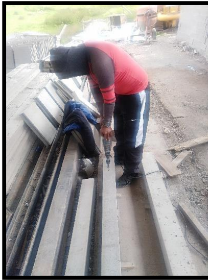
Perforación de viga con roto martillo para empernar el sistema aporticado
