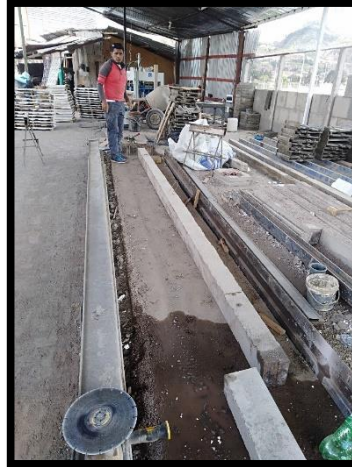
Ilustración 45; cote de viga pretensada
