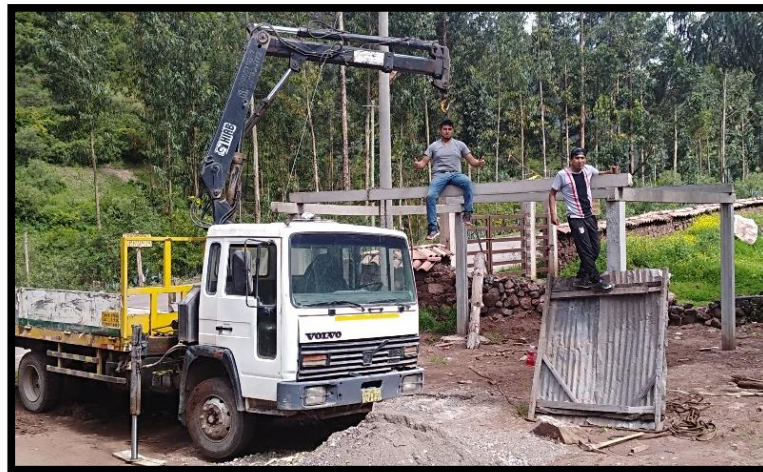
Ilustración 51: instalación completa de vigas pretensadas
