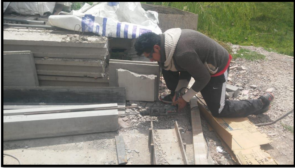
Perforación de columna con roto martillo.
