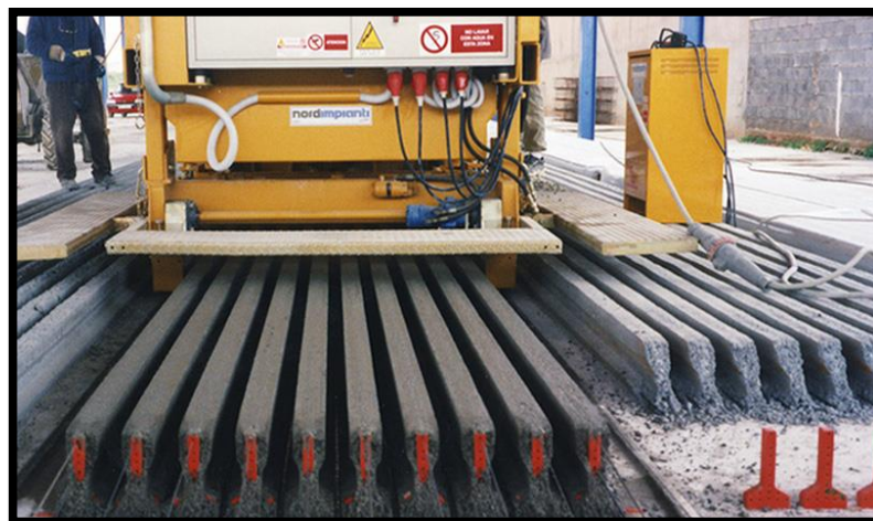
Ilustración 26: vaciado de los elementos estructurales
