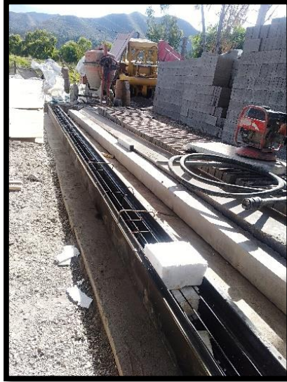
Preparación para vaciado.
