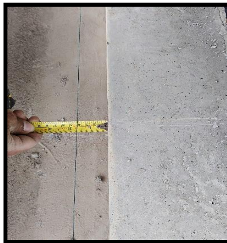
Medición de contra flecha en piso.
