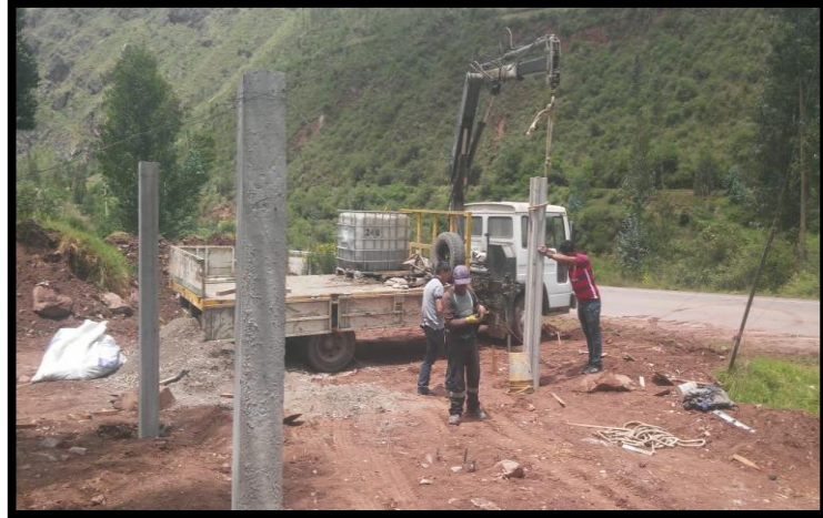
Ilustración 49(a) (b): traslado e izado de columnas prefabricadas.
