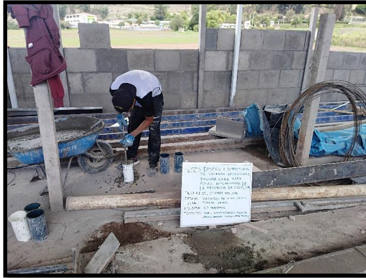
Extracción de testigos
