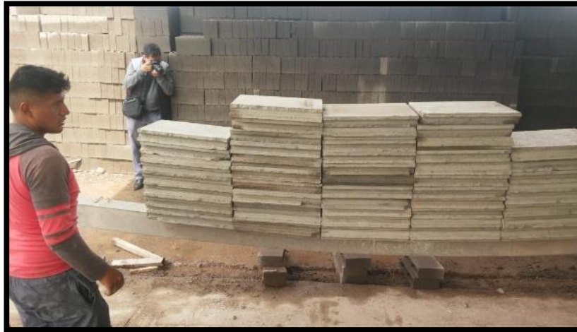
Ilustración 59: proceso de carga a viga en campo
