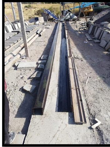
Ilustración 38: instalación del encofrado
