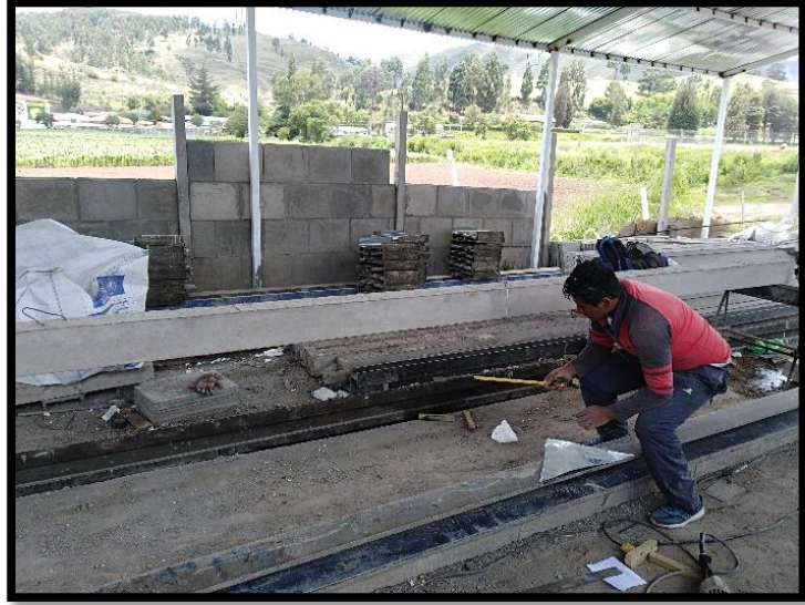
Preparación de vigas para ensayo de flexión en campo.
