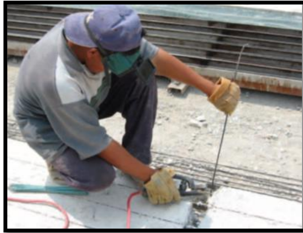
Ilustración 29: corte del alambre de alta resistencia.
