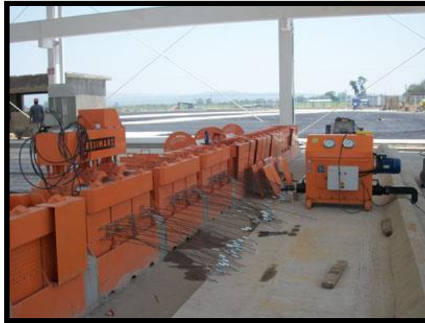
Ilustración 21: corte del alambre para pretensar
