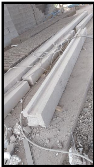
Proceso de perforación de columna para empotramiento de varillas enroscadas.
