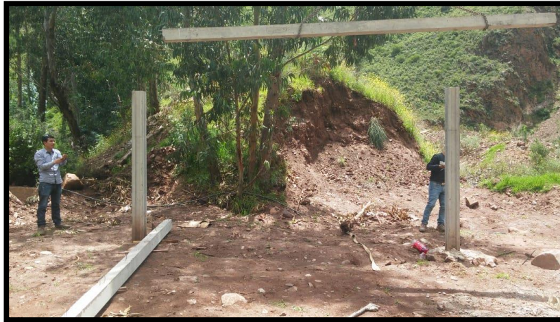
Ilustración 50: montaje de viga pretensadas
