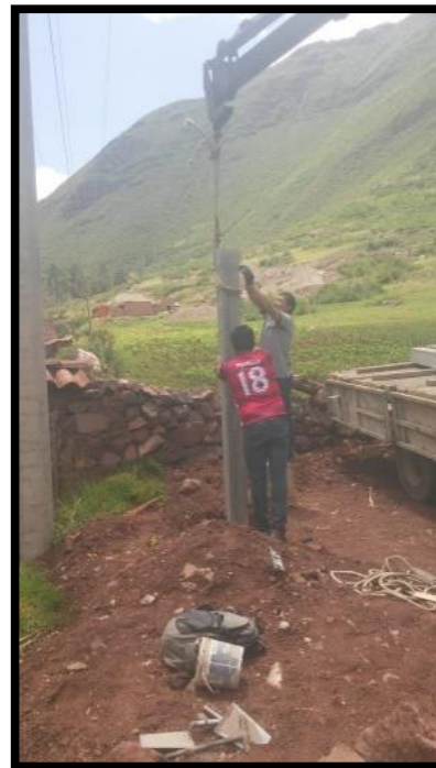
Izado y plomado de columnas.
