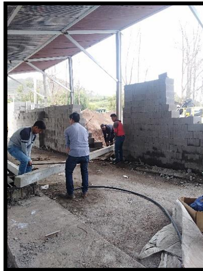
Traslado de vigas a la grúa para su traslado y posterior montaje.
