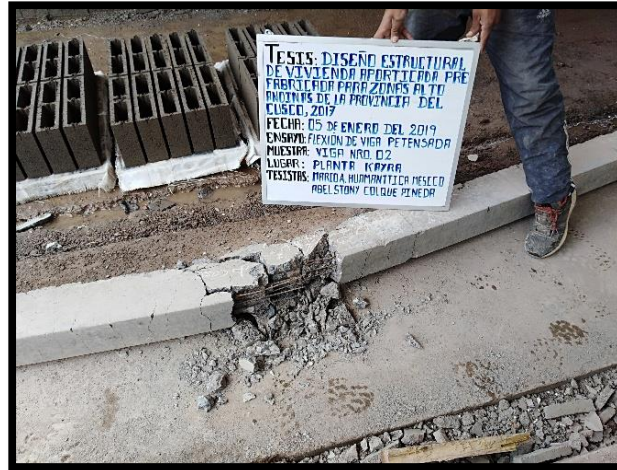
Ilustración 61: zona de falla de viga pretensada
