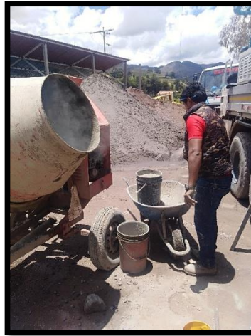
Ilustración 25: elaboración del concreto de alta resistencia.
