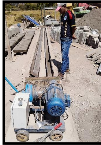
Ilustración 39: instalación del motor de pretensado.
