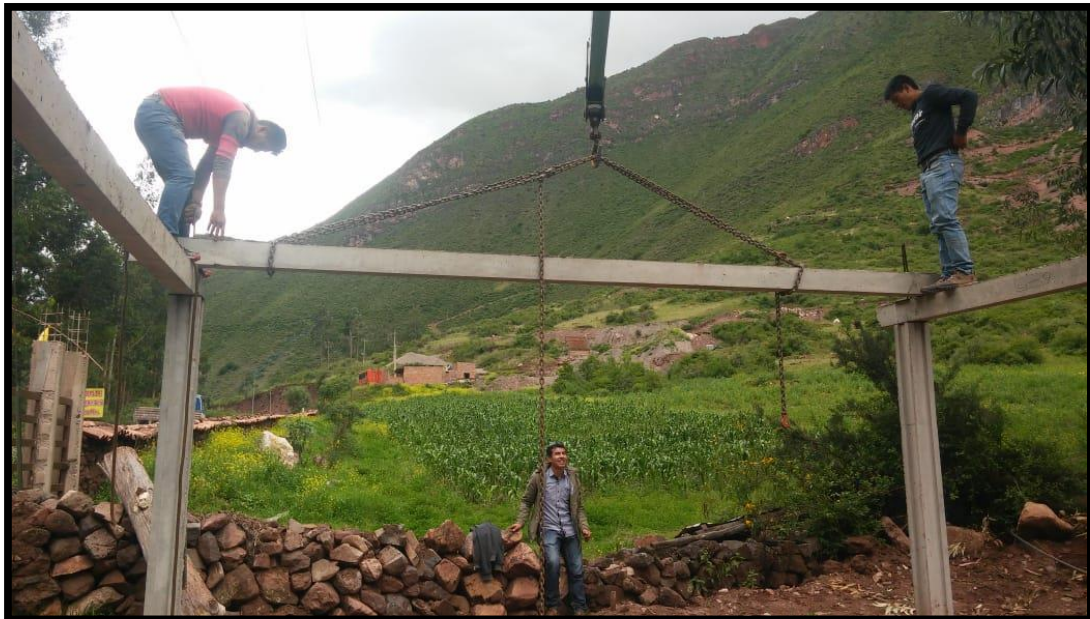
Sujeción de vigas pretensadas con las varillas y el empernado.
