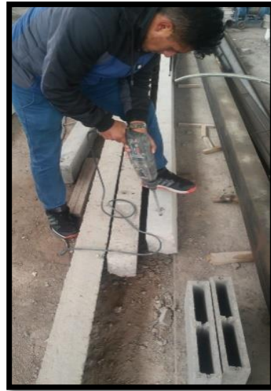
Perforación de viga con roto martillo para empernar el sistema aporticado
