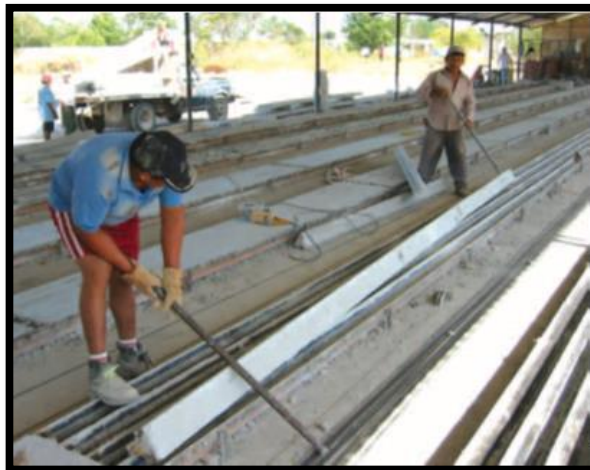
Ilustración 30: desencofrado de vigas.
