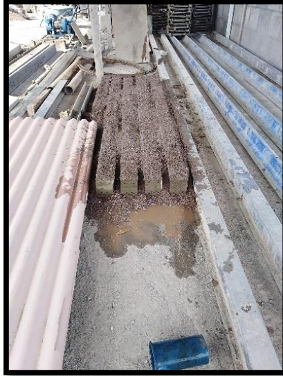
Curado de vigas.
