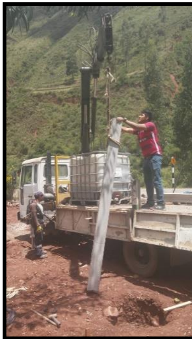
Izado y plomado de columnas.
