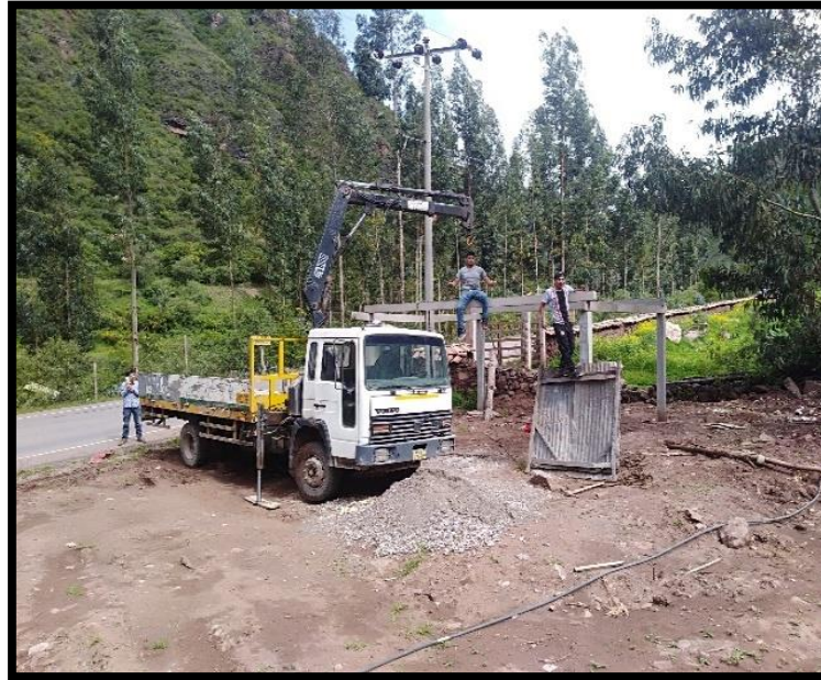
Finalizado del montaje de vigas pretensadas.
