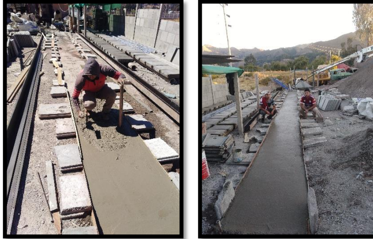
Ilustración 36 (a) (b): vaciado de pista producción
