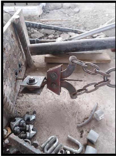
Sujeción de cable para pretensado.
