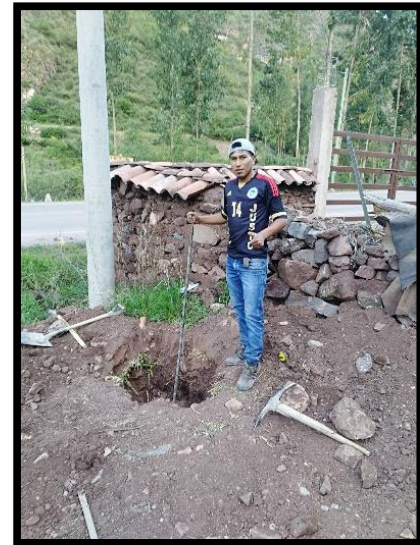
Replanteo de ubicación de zapatas para su excavación.
