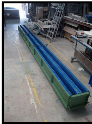
Ilustración 20: la preparación del molde o encofrado.
