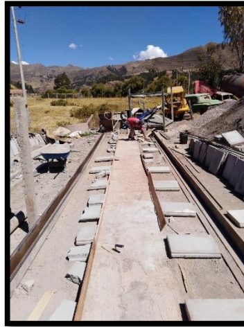
Ilustración 35: Nivelacion de terreno
