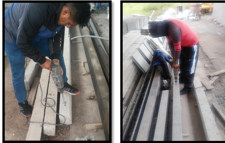
Ilustración 46(a) (b): perforacion de viga pretensada
