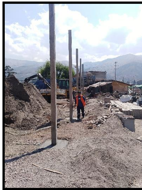
Vaciado de columnas de prueba de 5m
