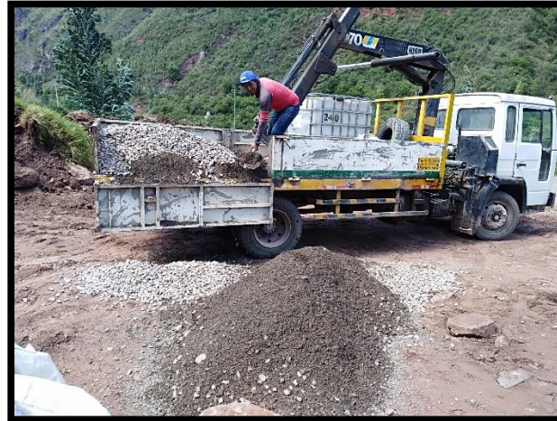
Descarga de material para vaciado de zapatas.
