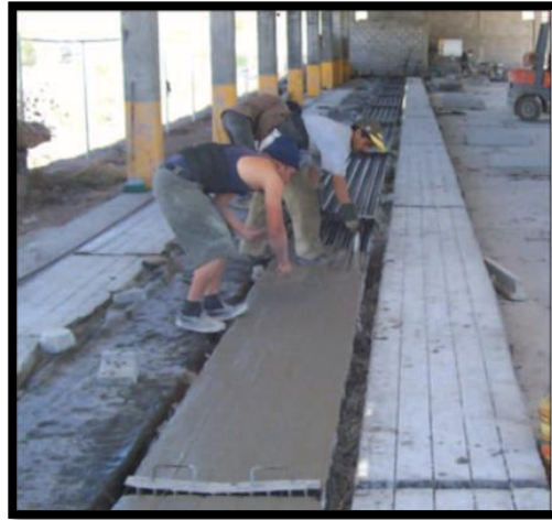
Ilustración 27: vibrado de vigas pretensadas
