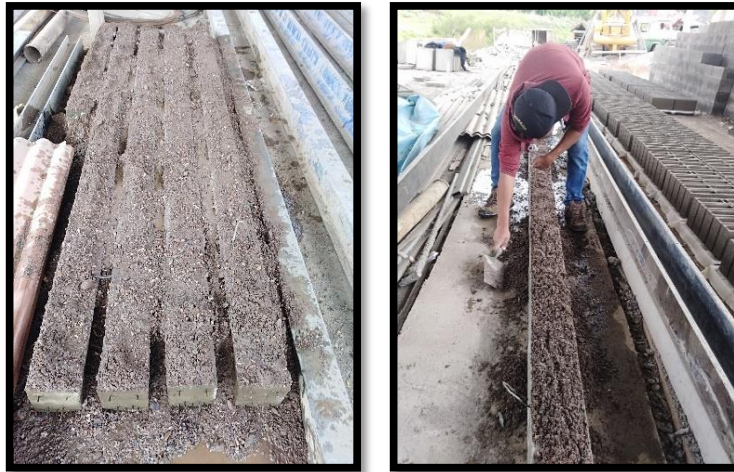
Ilustración 44 (a) (b): curado de la viga pretensada
