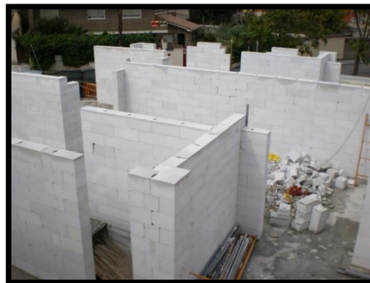
Ilustración 2: muros portantes en viviendas prefabricadas.
