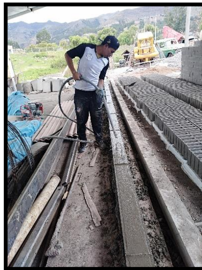
vibrado de concreto
