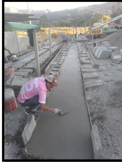
Vaciado de cama de apoyo. Acabado de cama de apoyo.
