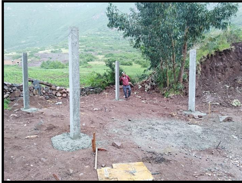
Vaciado de columnas.
