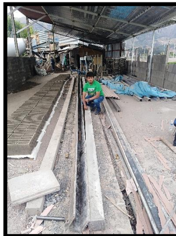
Ilustración 43: desencofrado de viga pretensada
