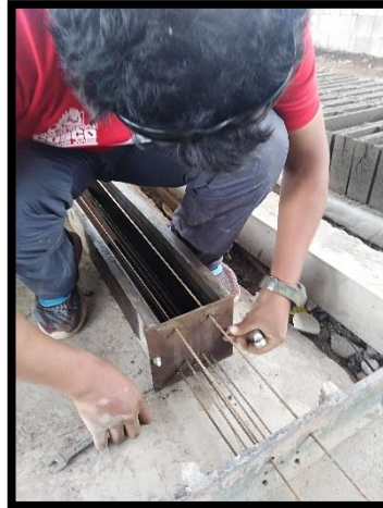
Ilustración 40: tensado de alambres
