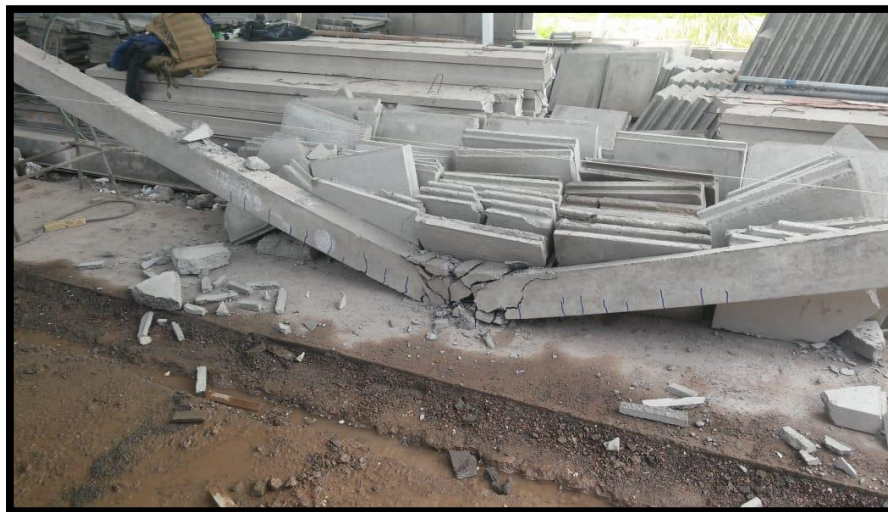
Punto de falla de la viga con máxima carga aplicada que le desestabilizo al llegar a la falla.
