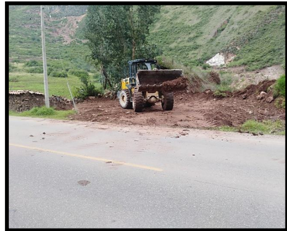
Limpeza del área de construcción y nivelación y compactación de terreno para la construcción de vivienda prefabricada.
