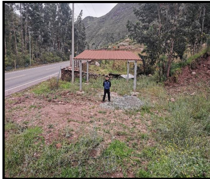
Techado de la vivienda prefabricada aporticada.
