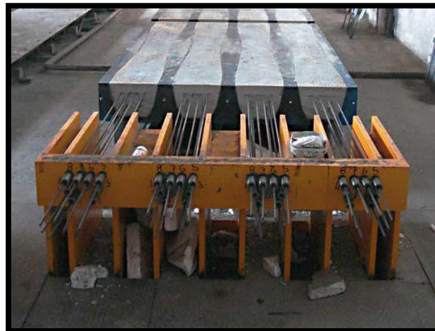
Ilustración 23: anclaje de alambres con las grapas o sujetadores
