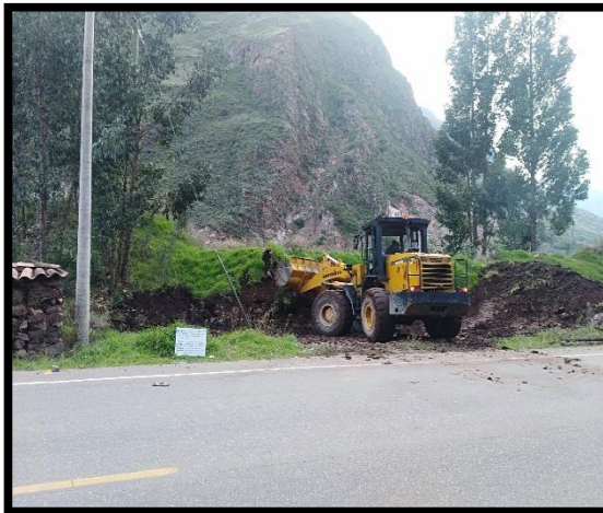
Limpeza del área de construcción y nivelación y compactación de terreno para la construcción de vivienda prefabricada.
