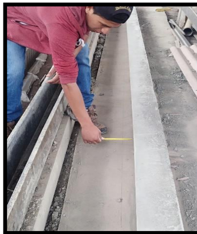
Desenfofrado de viga.
