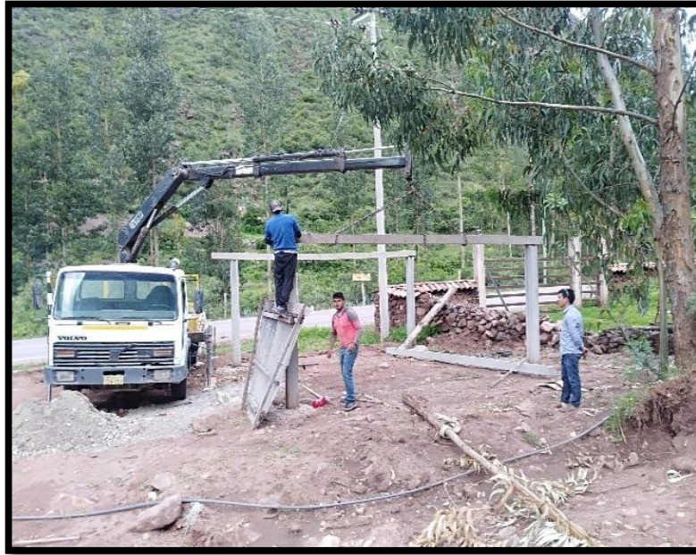
Colocación de vigas con las vigas en el eje de las varillas roscadas.
