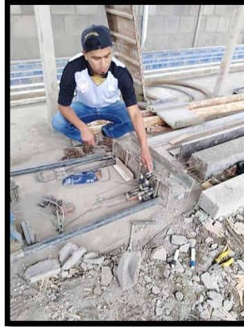
Ilustración 42: corte de alambre para pretensar
