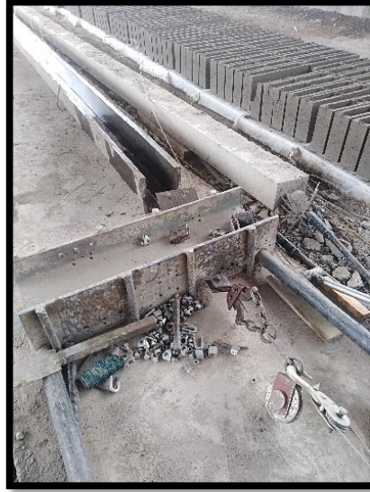
Tensado de alambre.
