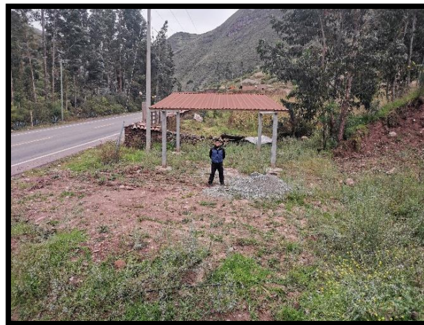
Ilustración 52: montaje del techado
