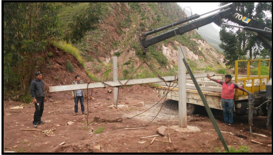
Ubicación de vigas pretensadas a su lugar y sentido
