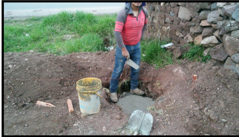
Vaciado de zapatas.
