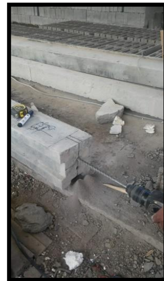
Proceso de perforación de columna para empotramiento de varillas enroscadas.
