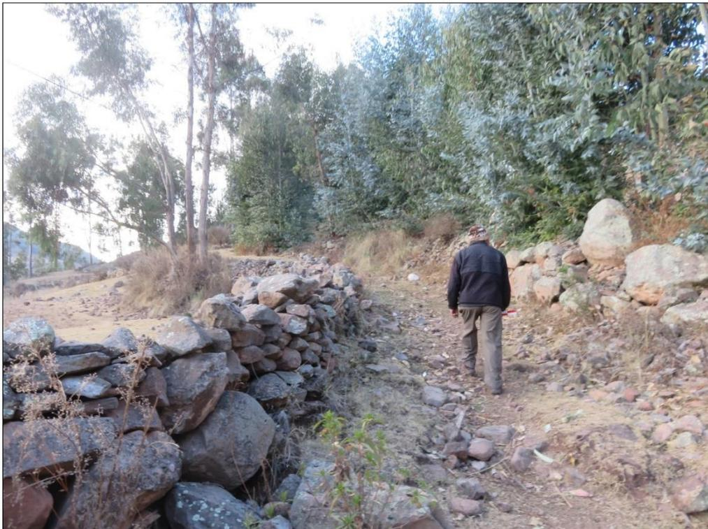
*Foto N° 143 y 144.- Véase el ancho del camino hacia la cantera de Saqsaywamanpata, con muros laterales armado en seco y la grava menuda en el piso. Fuente: A. Huaman.*
