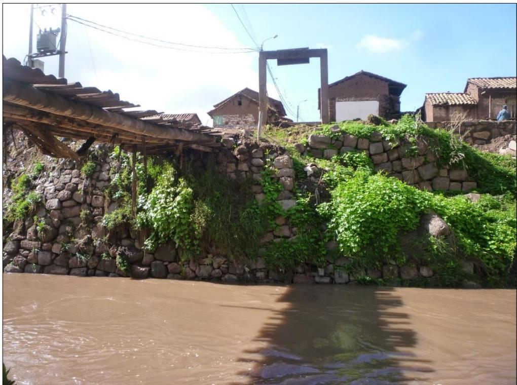
Foto N° 145 y 146.- Estribos lado Norte y Sur del Puente Machuchaka, donde se observa elementos líticos de factura Inka. Fuente: A. Huaman.
