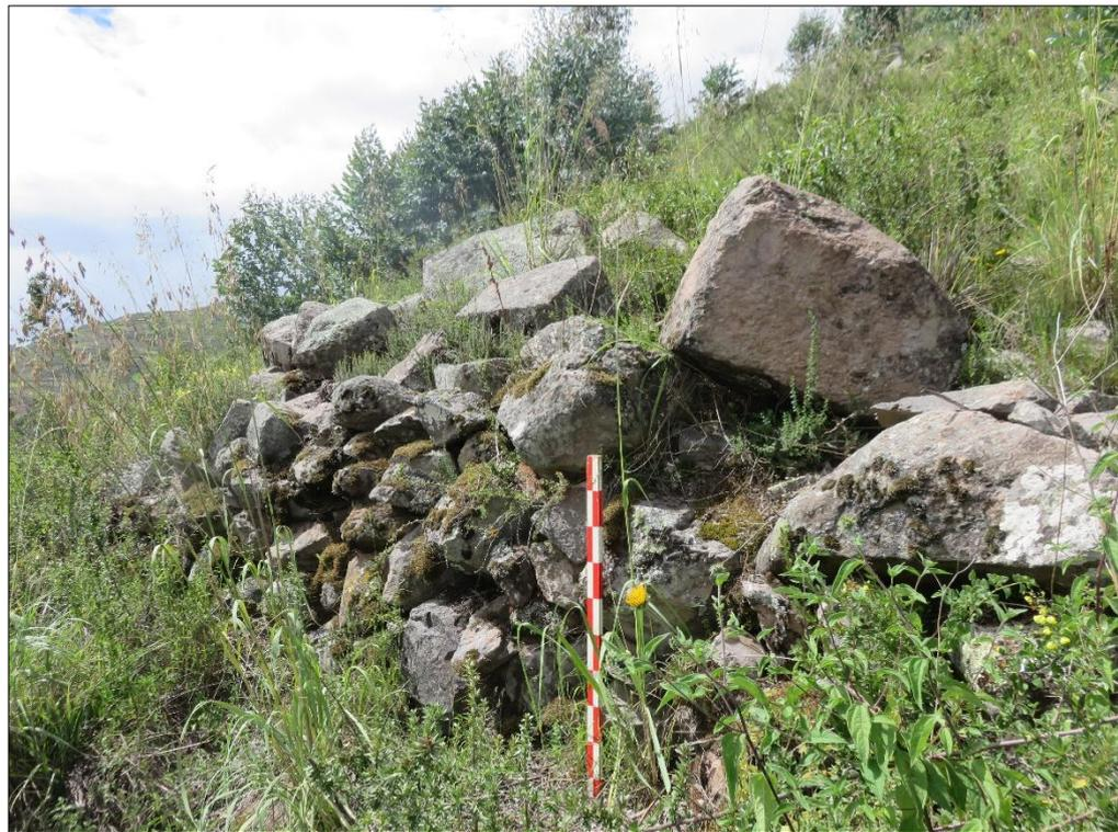
*Foto N° 137.- Construcción de muros en seco para evitar deslizamientos durante la explotación de la cantera de Saqsaywamanpata. Fuente: A. Huaman.*
