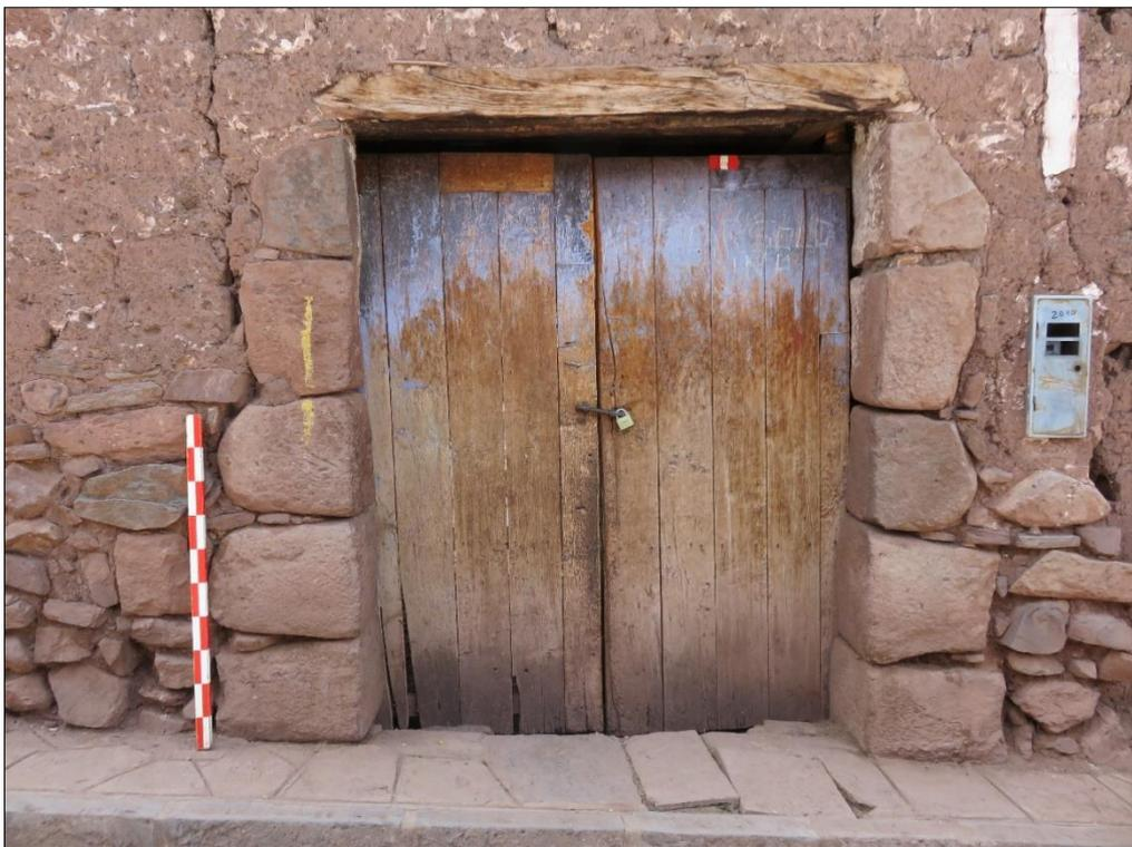
Foto N° 132.- Reutilización de bloques de factura Inka, para la construcción de portadas; ubicado en calle Arica, Huarcocondo. Fuente: A. Huaman.
