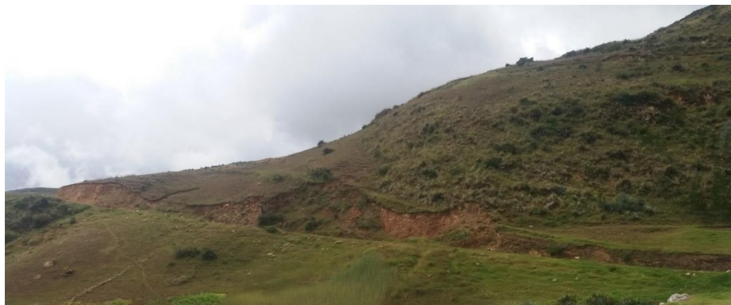
Foto 11.- Derrumbes (Fuente propia)
