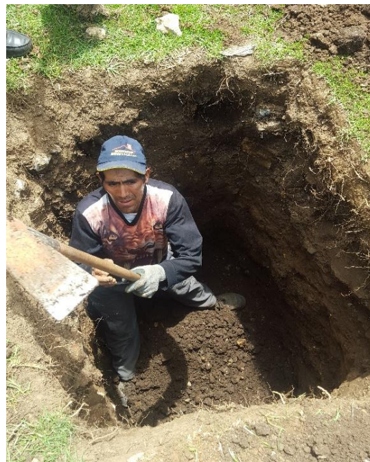
Fotografía. Ubicación de la calicata 02
