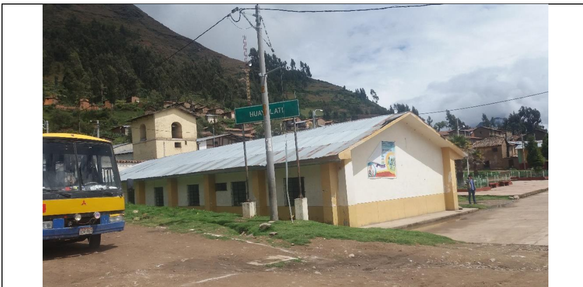
Foto 16.- Muestra el tipo de material (Adobe) de la edificación de la posta de salud Huayllati en estado actual. (Fuente propia)
