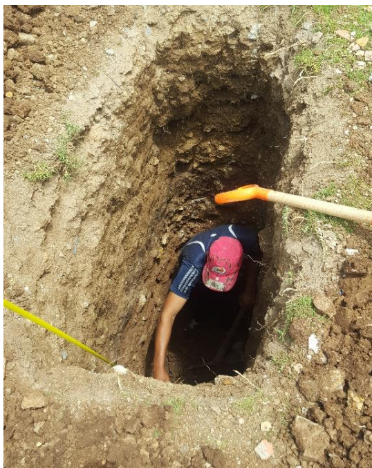
Fotografía. Ubicación de la calicata 01
