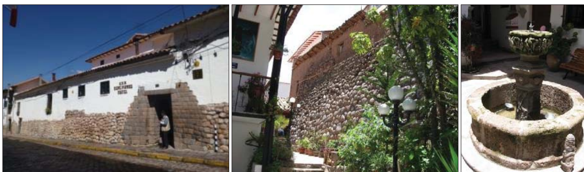
Fig. 115. Vista externa del predio con presencia de muro de contención Inka, con adosamiento de vano de doble jamba, así mismo en el interior se muestra muro de contención con material lítico prehispánico reutilizado y una fuente Colonial.
