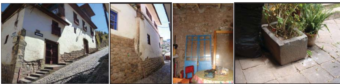
Fig. 184. Vista externa del predio con presencia de material lítico reutilizado. En el interior se evidencia un muro de contención con material lítico reutilizado.
