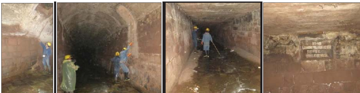
Fig. 392. Vista de la canalización del Río Saphi desde la intersección con la calle Conquista hasta la calle Amargura, con material arquitectónica prehispánica reutilizada en los bordos. Así mismo se evidencia en cambio morfológico de la bóveda.
