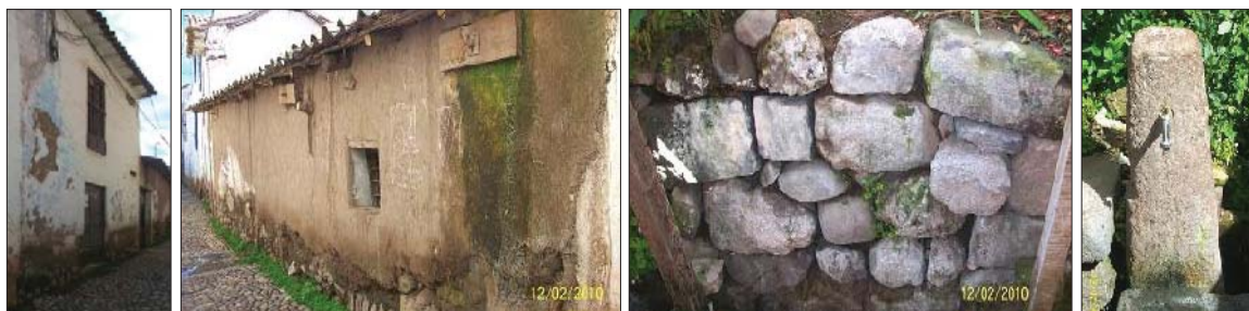
Fig. 259. Vista externa del predio con presencia de sobrecimiento con material lítico reutilizado. En el interior del inmueble se evidencia parte de un muro con material reutilizado.
