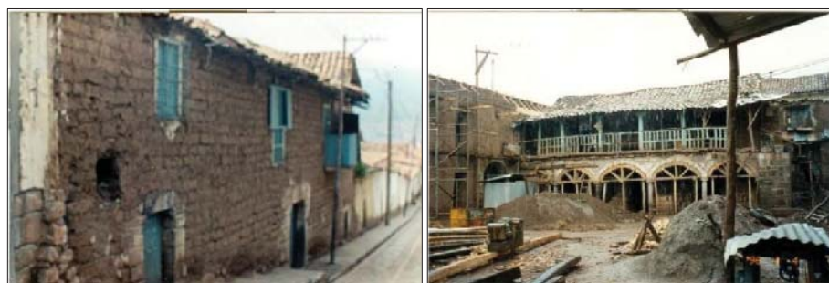
Fig. 16. Muestra la fachada y la parte interna del inmueble, antes de su restauración. Fuente: Olazábal (1993)
