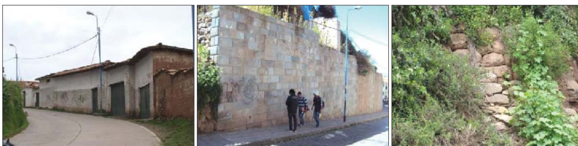
Fig. 288. Vista externa del predio de ambas fachadas. En la parte interna del predio se evidencia un muro de contención de probable filiación Inka.
