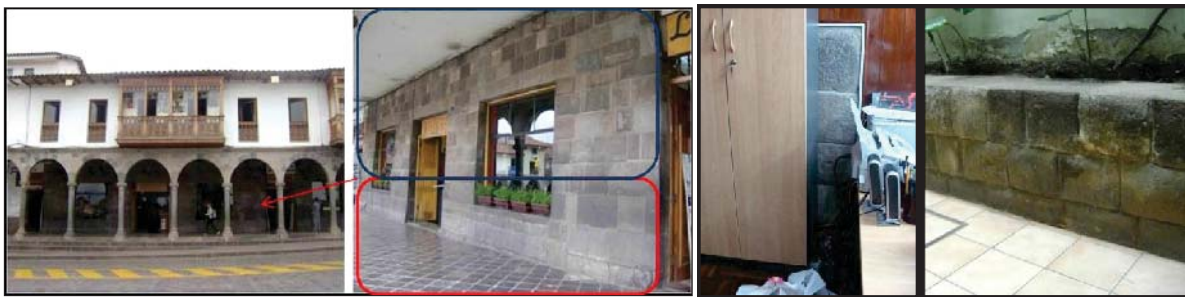
Fig. 312. Vista externa del inmueble con evidencia de muro estructural de factura Inka. En el interior observa otro muro Inka de aparejo sedimentaria a base de material andesita.
