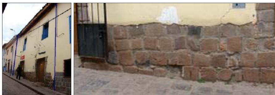
Fig. 343. Vista externa del inmueble con presencia de material lítico reutilizado.
