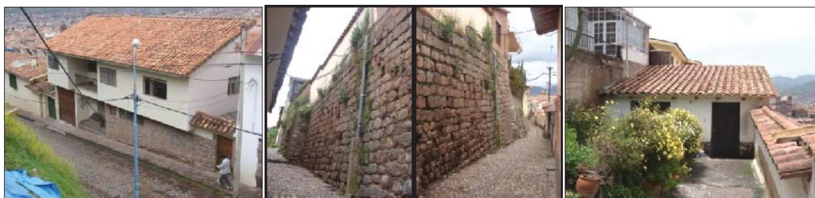
Fig. 277. Vista externa del predio, con evidencia de material lítico reutilizado en las fachadas del inmueble a manera de muro de contención.
