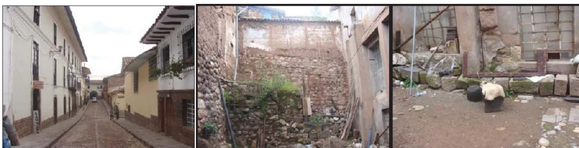
Fig. 265. Vista externa del predio. En el interior se evidencia un muro de contención con material reutilizado y elementos líticos sueltos.
