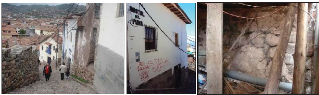
Fig. 211. Vista externa del inmueble, donde se evidencia material lítico reutilizado. En el interior del inmueble se evidencia un muro de contención con material lítico reutilizado se presume que tiene una traza original.
