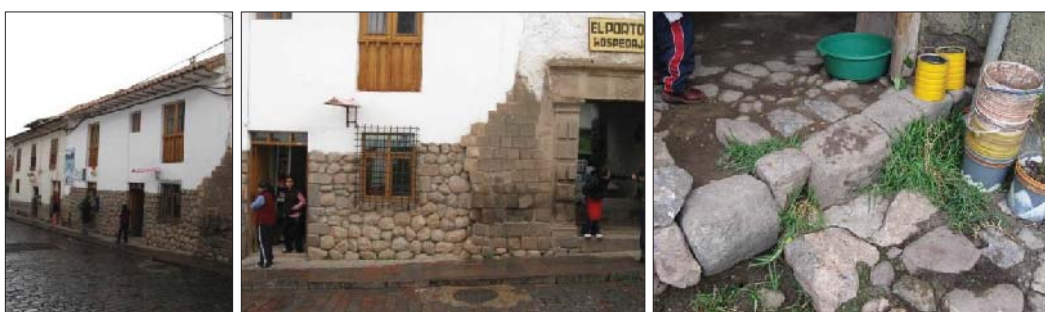
Fig. 118. Vista externa del predio con presencia de muro de contención Inka, y restos de una jamba de un vano de acceso, así mismo en el interior se muestra algunas estructuras con material lítico prehispánico reutilizado.
