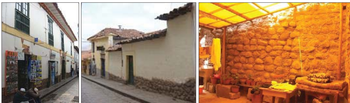
Fig. 332. Vista externa del inmueble con presencia de material lítico reutilizado. En el interior se evidencia un muro con material lítico reutilizado.
