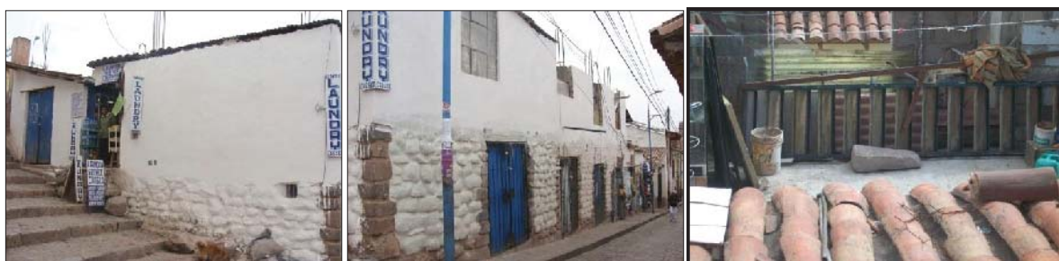
Fig. 338. Vista externa del inmueble con presencia de material lítico reutilizado. En el interior se evidencia litos sueltos a manera clavos líticos.
