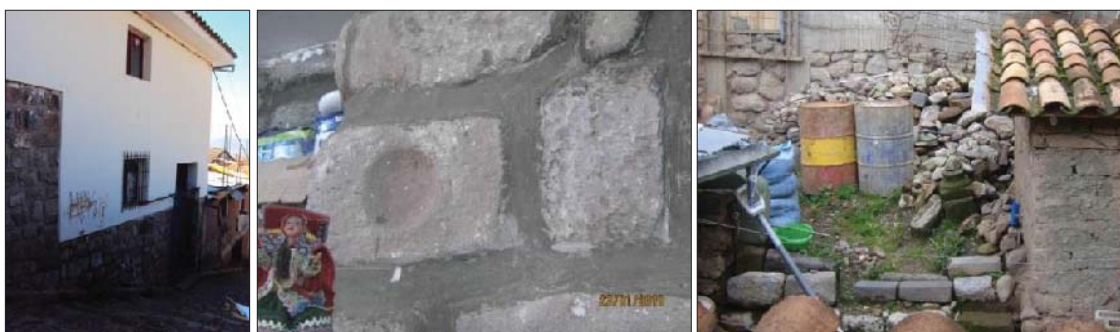
Fig. 212. Vista externa del inmueble, donde se evidencia material lítico reutilizado. En el interior del inmueble se evidencia tramos cortos de muro con material lítico reutilizado, así mismo se tiene un montículo de elementos líticos sueltos.
