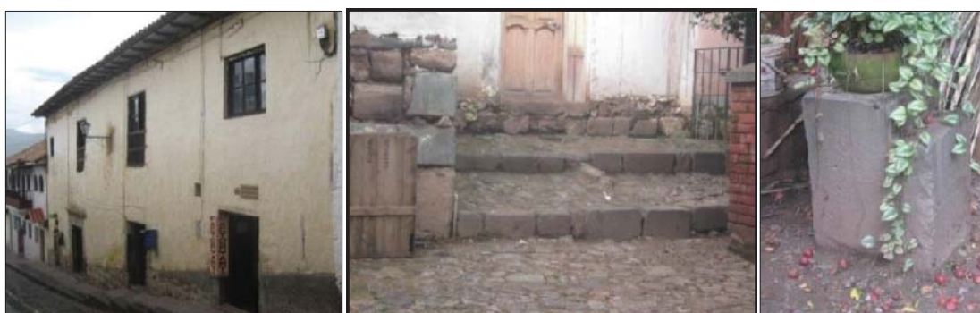
Fig. 191. Vista externa del predio con presencia de material lítico reutilizado. En el interior se evidencia una escalinata con material reutilizado, así mismo se tiene litos sueltos en el patio del inmueble.
