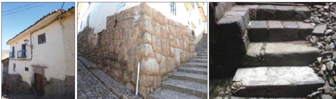
Fig. 282. Vista externa del predio, con evidencia de muro de contención Inka edificada con material caliza. En el interior se evidencia reutilización de material lítico en escalinatas.
