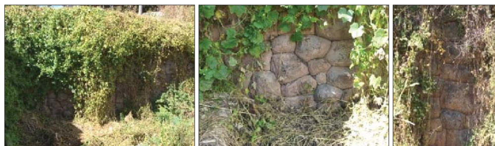
Fig. 356. Evidencias de muro de contención Inka, ubicada dentro del predio, esta se encuentra edificada a base de material caliza con aparejo del tipo celular.
