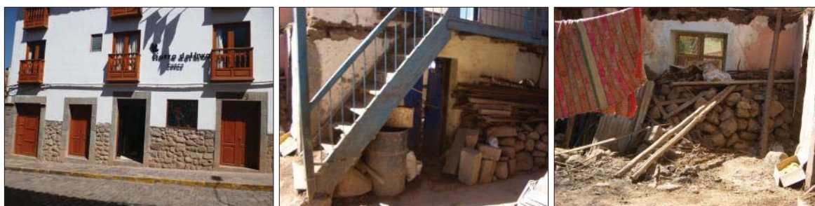
Fig. 99. Vista externa del predio donde se evidencia material lítico prehispánico reutilizado, así mismo en el interior del predio se evidencia material lítico suelto y asinado.
