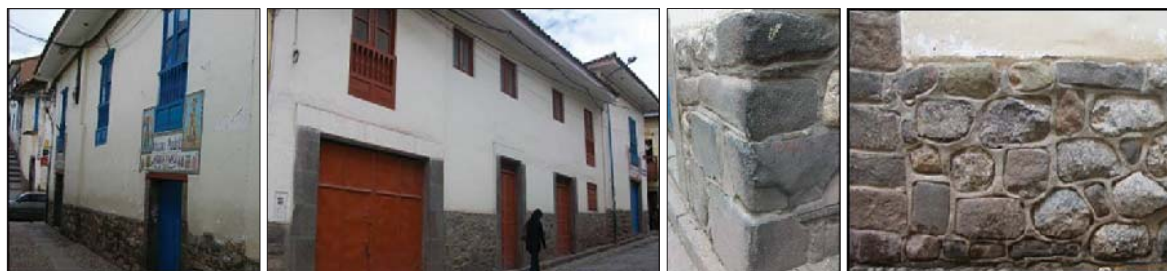
Fig. 141. Vista externa del predio con presencia de material lítico reutilizado en algunos tramos cortos.
