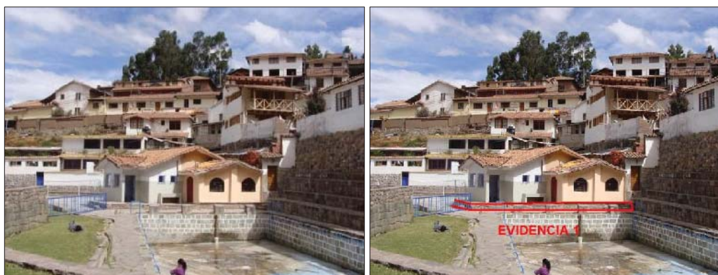
Fig. 83. Vista externa del predio donde se tiene la presencia de un sobrecimiento con material lítico prehispánico.
