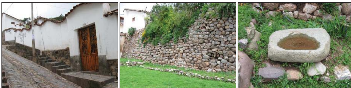
Fig. 106. Vista externa del predio donde se evidencia material lítico prehispánico reutilizado, así mismo al interior de esta se evidencia un muro de contención Inka de aparejo celular, también se tiene material lítico suelto, y un lito trabajado en diorita a manera de fuente.
