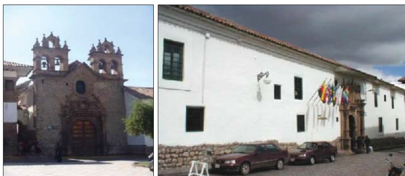
Fig. 15. Muestra el estado actual de la fachada del inmueble.
