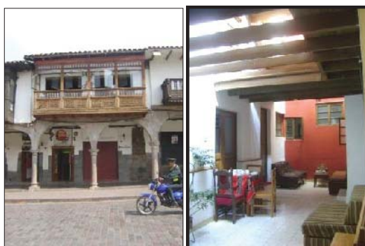
Fig. 308. Vista externa e interna del inmueble sin presencia de material prehispánico reutilizado.
