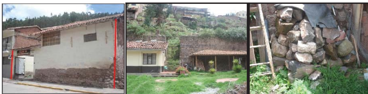
Fig. 381. Vista externa del inmueble con presencia de material lítico prehispánico reutilizado. En el interior del inmueble se tiene un muro de contención y un montículo de material lítico reutilizado.
