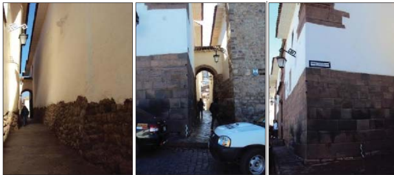
Fig. 25. Muestra el estado actual de la calle Siete Culebras Fuente: propia
