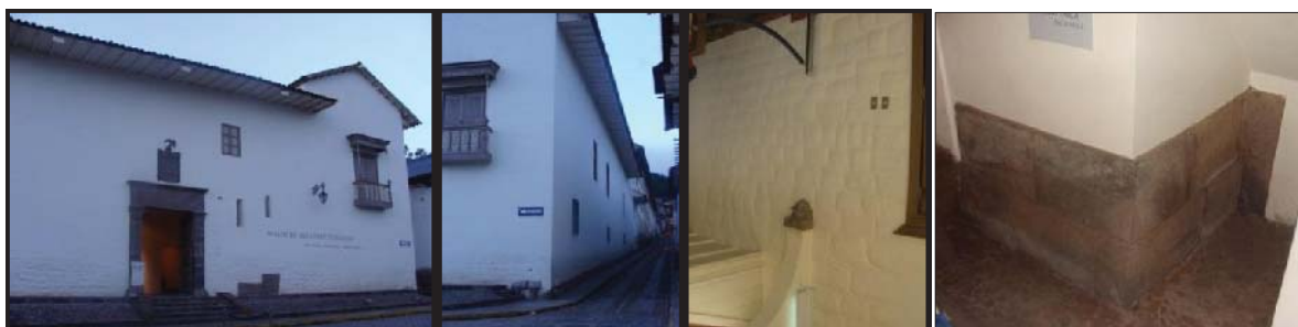
Fig. 220. Vista externa del predio con presencia de material lítico prehispánico reutilizado ubicado en el sobrecimiento de la fachada. En el interior del inmueble se muestra un muro de contención con material reutilizado cubierto por un enlucido blanco, asimismo se tiene el sobrecimiento con material andesita reutilizado
