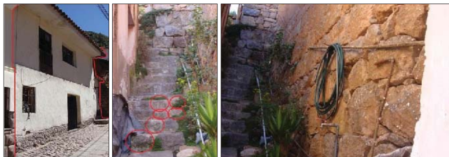
Fig. 158. Vista externa del predio sin presencia de evidencia arquitectónica prehispánica. Dentro del predio se tiene algunas estructuras con material lítico reutilizado.
