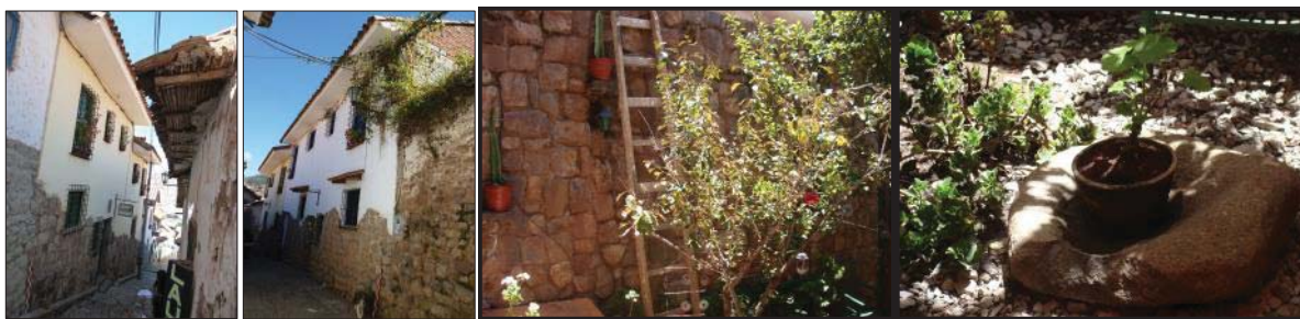
Fig. 186. Vista externa del predio con presencia de material lítico reutilizado. En el interior se evidencia un muro de contención con material reutilizado, así como litos sueltos en el patio del inmueble.
