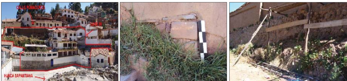
Fig. 87. Vista externa e interna del predio, donde se evidencia elementos líticos reutilizados en un cerco perimétrico, así mismo dentro del predio se observa un muro de contención material lítico prehispánico reutilizado.
