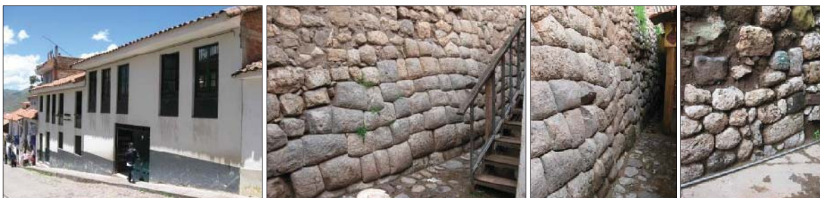
Fig. 94. Vista externa del predio, donde en la parte interna se evidencia dos muros de contención de época Inka, así mismo se evidencia un muro con material lítico reutilizado.
