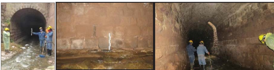
Fig. 391. Vista de la canalización del Río Saphi desde el inicio de la calle Saphi hasta la intersección con la calle Conquista, con material arquitectónica prehispánica reutilizada en los bordos y bóveda del canal.
