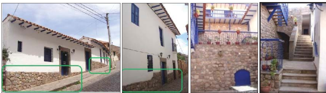
Fig. 279. Vista externa del predio, con evidencia de material lítico reutilizado. En el interior se observa muros de contención con material lítico reutilizado.
