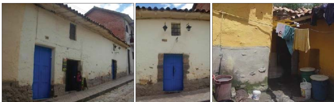
Fig. 193. Vista externa del predio, donde se observa el enlucido de cemento que cubre el material lítico. En el interior no se evidencia material arquitectónico prehispánico.
