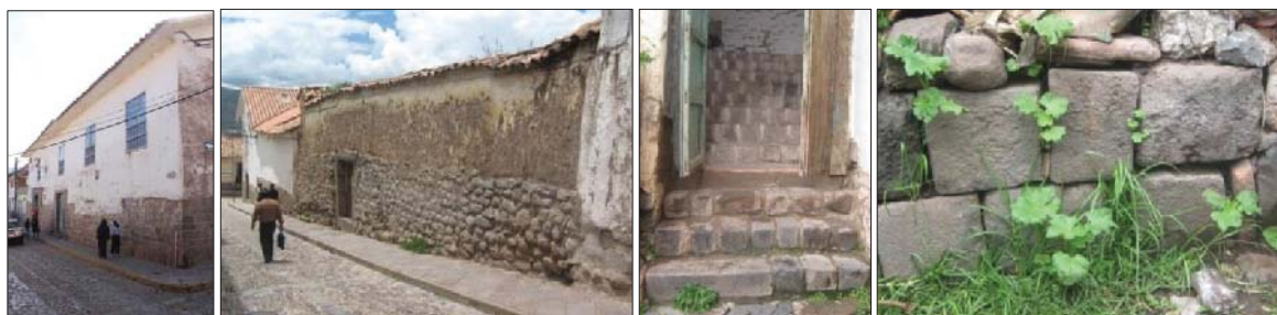
Fig. 207. Vista externa del predio, donde se evidencia reutilización de material lítico prehispánico en la fachada del inmueble. Asimismo en el interior del inmueble se evidencia una escalinata con litos reutilizados, de igual forma se evidencia litos sueltos en el patio del inmueble.
