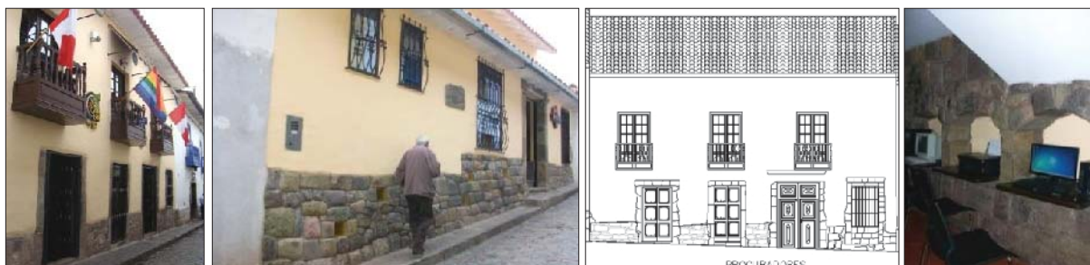
Fig. 330. Vista externa del predio donde se evidencia material lítico reutilizado. En el interior se registra un muro con elementos líticos reutilizados.
