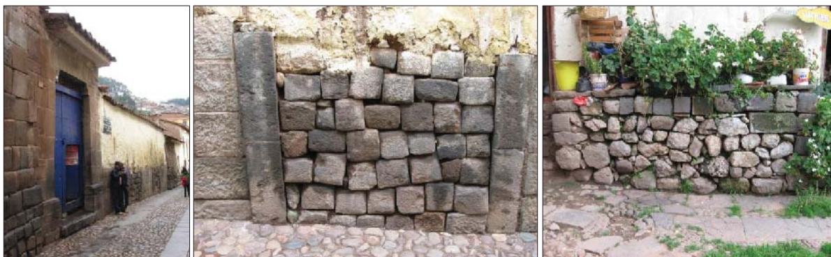
Fig. 133. Vista externa del predio con presencia de material lítico reutilizado. En el interior del inmueble se evidencia formas estructurales con material lítico reutilizado.
