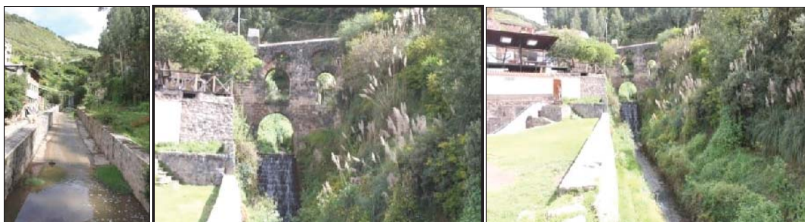
Fig. 397. Vista de la canalización del Río Tullumayo desde la ribera del predio 01 hasta la intersección con la calle Siete Borreguitos, sin evidencia arquitectónica prehispánica.
