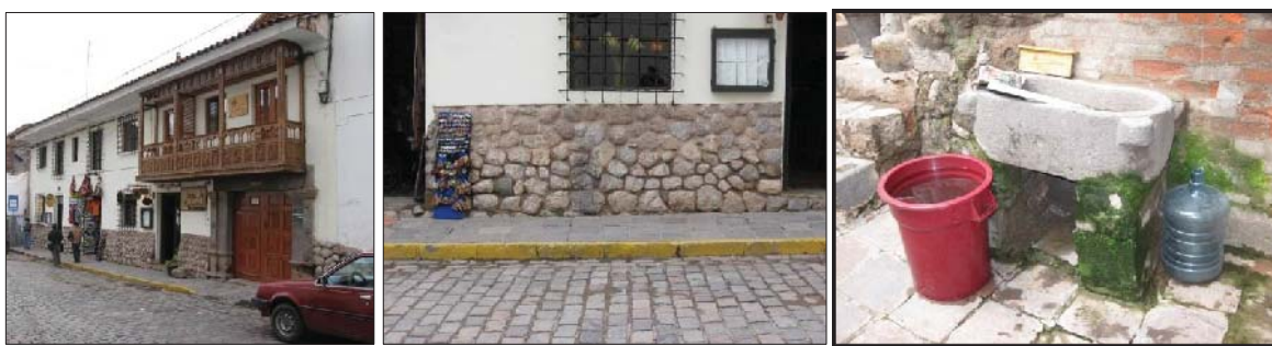
Fig. 129. Vista externa del predio con presencia de muro Inka, restos de vano de acceso. En el interior del inmueble se evidencia estructuras con material lítico reutilizado.
