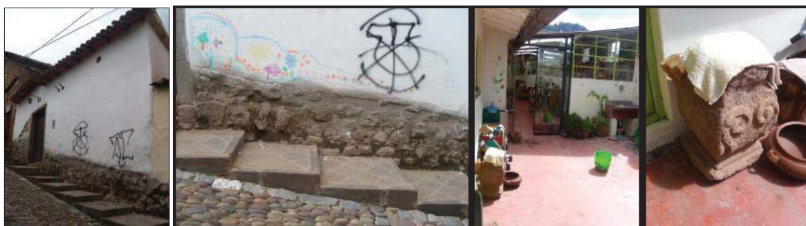
Fig. 177. Vista externa del predio, con presencia de material lítico reutilizado. En el interior no se evidencia material arquitectónico.
