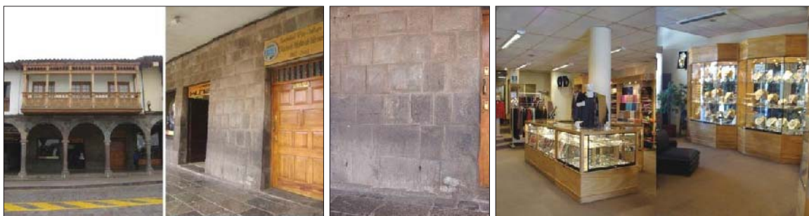
Fig. 311. Vista externa del inmueble con evidencia de muro estructural de factura Inka. En el interior no se presencia material arquitectónico prehispánico.
