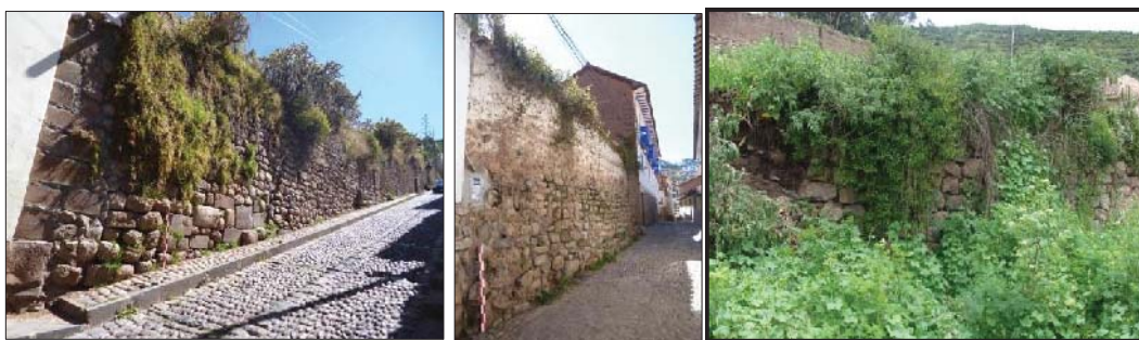
Fig. 183. Vista externa del predio con presencia de muro con material lítico reutilizado. En el interior se evidencia muros de contención en forma paralela orientados de Norte a Sur edificadas con material lítico reutilizado.
