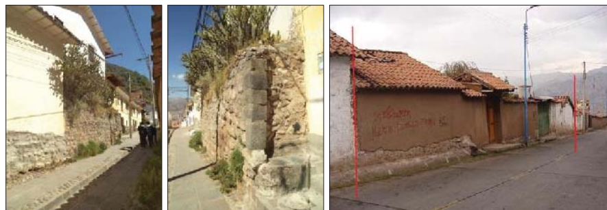
Fig. 157. Vista externa del predio, donde se evidencia un muro de contención con material lítico prehispánico reutilizado
