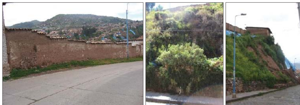
Fig. 287. Vista externa del predio, donde se evidencia un muro de contención contemporáneo con material lítico reutilizado.
