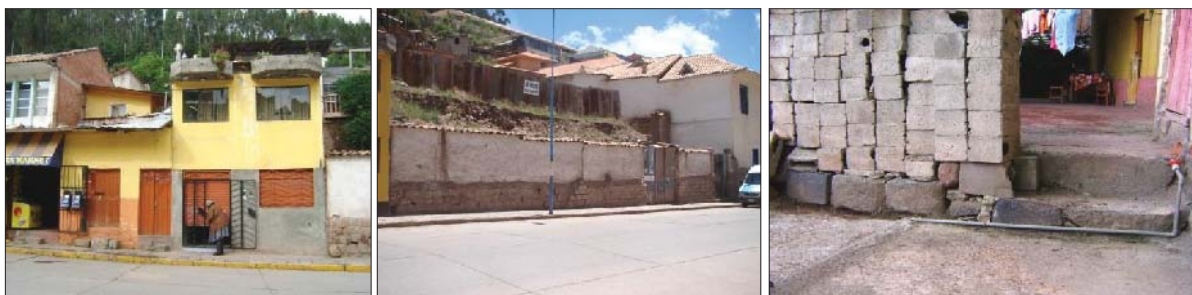
Fig. 369. Vista externa del inmueble. En el interior se observa algunos litos reutilizados en parte de una estructura contemporánea.
