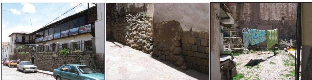
Fig. 120. Vista externa del predio con presencia de muro de contención contemporáneo hacia a calle Choquechaka, y restos de un muro de contención Inka hacia la calle Siete Culebras, así mismo en el interior se muestra algunos elementos líticos sueltos dispersos en el patio.
