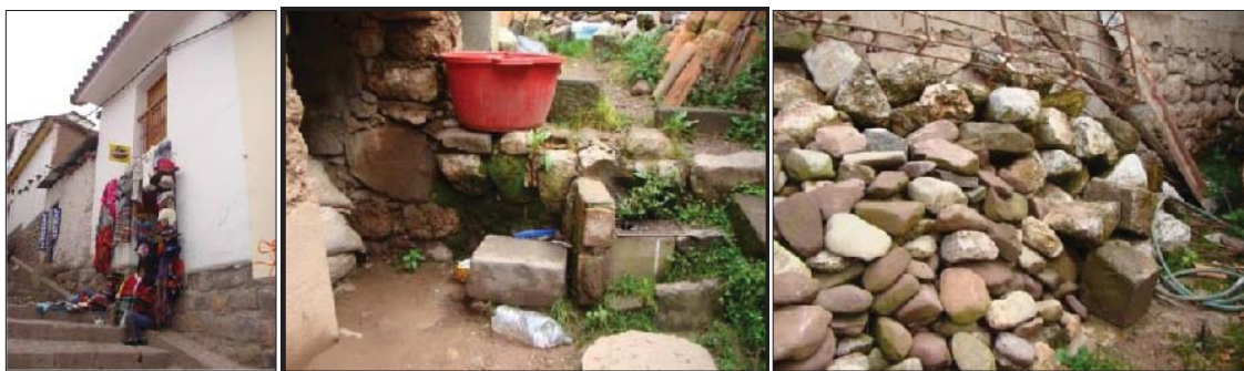
Fig. 213. Vista externa del inmueble, donde se evidencia material lítico reutilizado. En el interior del inmueble se evidencia una escalinata con litos reutilizado, así mismo se tiene un montículo de elementos líticos sueltos.
