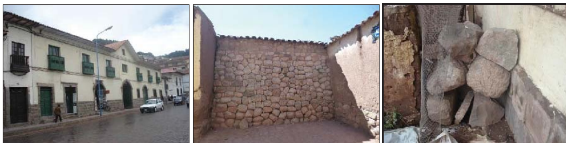
Fig. 145. Vista externa del predio, donde se evidencia un muro de contención de factura Inka. En el interior del inmueble se tiene algunos litos sueltos.
