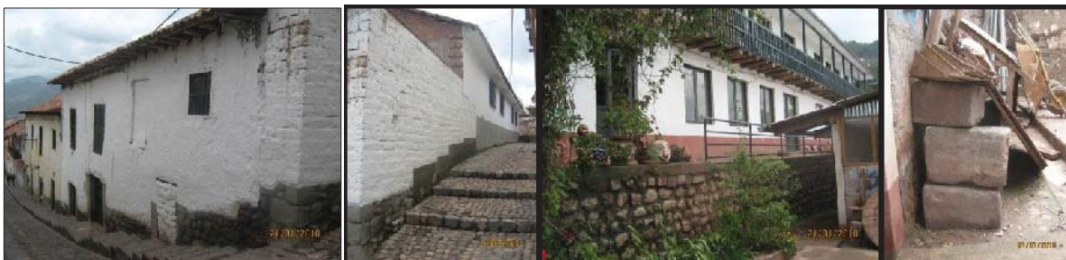
Fig. 190. Vista externa del predio con presencia de material lítico reutilizado. En el interior se evidencia un muro con material reutilizado, así mismo se tiene litos suelto en el patio del inmueble.
