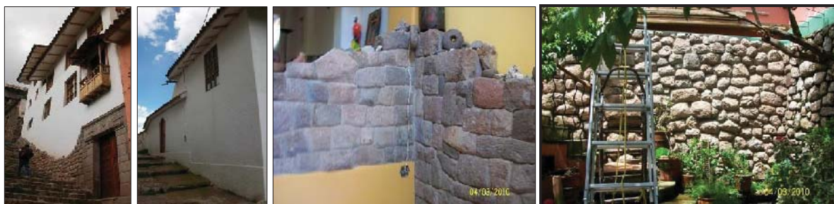
Fig. 254. Vista externa del predio, donde se evidencia un tramo con material lítico reutilizado. El interior del inmueble se presencia elementos líticos reutilizados en pare de un muro con andesita y un muro de contención con caliza.
