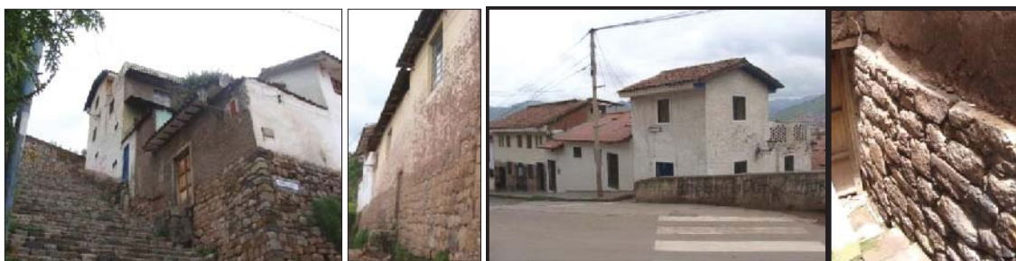
Fig. 275. Vista externa del predio, con evidencia de material lítico reutilizado en las fachadas del inmueble. En el interior del inmueble se evidencia algunos litos que forman parte del muro del corredor interior.
