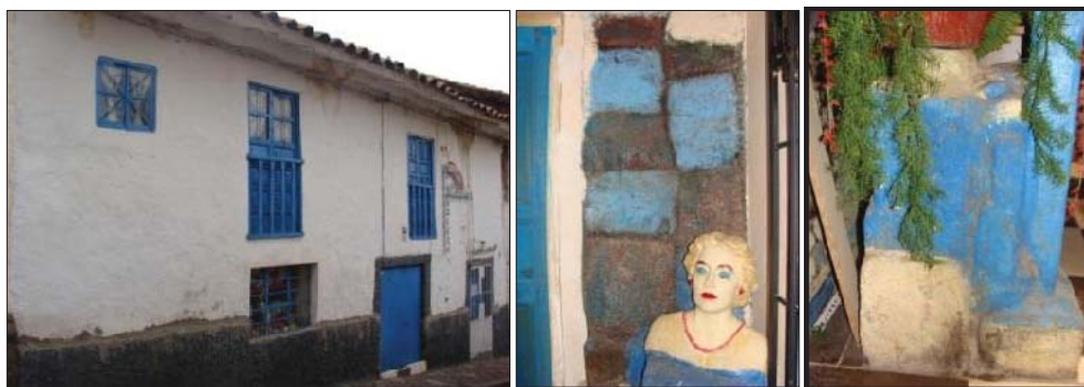
Fig. 200. Vista externa del predio. En el interior se evidencia parte de una estructura con material lítico prehispánico reutilizado.
