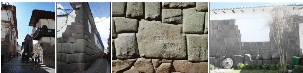
Fig. 138. Vista externa del predio con presencia de muro Inka a base de litos del tipo diorita verde. En el interior del inmueble se evidencia un muro Inka a base de litos del tipo andesita que se asienta sobre el muro de diorita verde.
