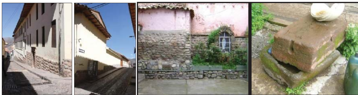
Fig. 219. Vista externa del predio con presencia de material lítico prehispánico reutilizado ubicado en el sobrecimiento de la fachada. En el interior del inmueble se muestra un muro de contención con material reutilizado y algunos litos sueltos.
