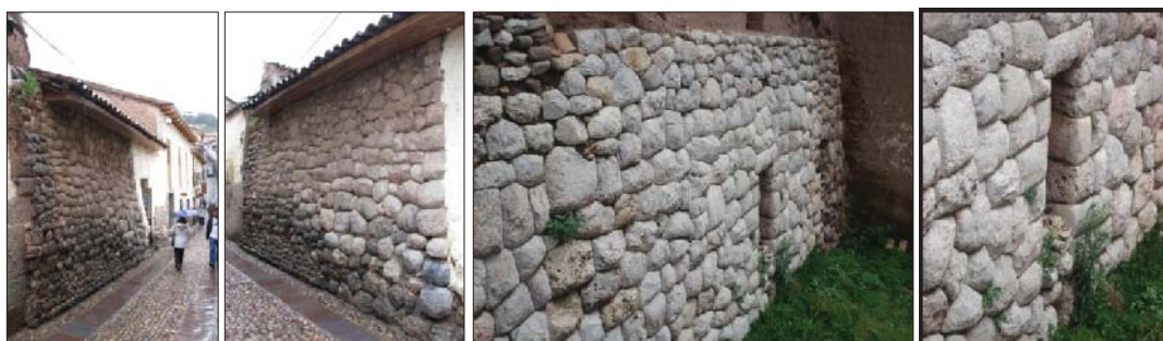
Fig. 132. Vista externa del predio con presencia de muro de contención Inka. En el interior del inmueble se evidencia un muro de contención con la presencia de un nicho trapezoidal.
