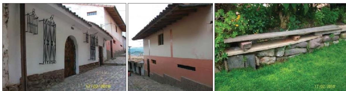
Fig. 256. Vista externa del predio. En el interior del inmueble se presencia elementos líticos reutilizados en parte de una estructura o muro seco.
