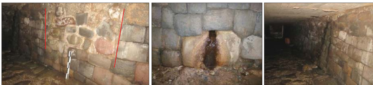
Fig. 401. Vista de la canalización del Río Tullumayo desde la altura con la calle Siete Culebras hasta la intersección con la calle Hatun Rumiyoq, donde se observa un muro encausador Inka, donde se observa un vano tapiado, así como un ducto de agua.
