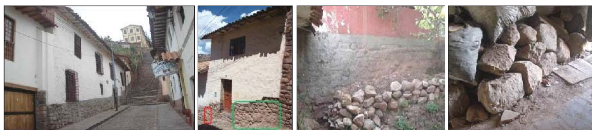
Fig. 378. Vista externa del inmueble con presencia de material lítico reutilizado. En el interior se evidencia un montículo de litos prehispánicos sueltos.
