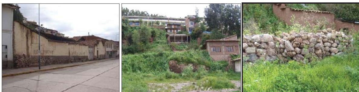
Fig. 374. Vista externa del inmueble con presencia de material lítico reutilizado. En el interior se evidencia muros de contención con material lítico, aunque no se distingue su originalidad, se evidencian gran cantidad de elementos líticos prehispánicos de material caliza sueltos
