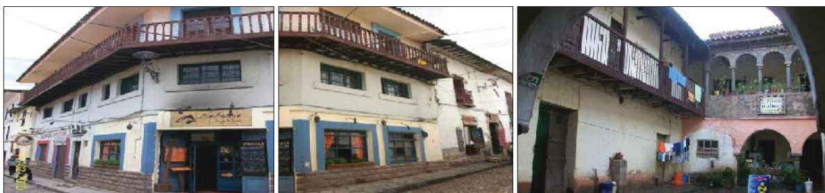
Fig. 264. Vista externa del predio con presencia de material lítico reutilizado en el acceso principal. En el interior se evidencia material lítico reutilizado en algunas secciones del inmueble Colonial.
