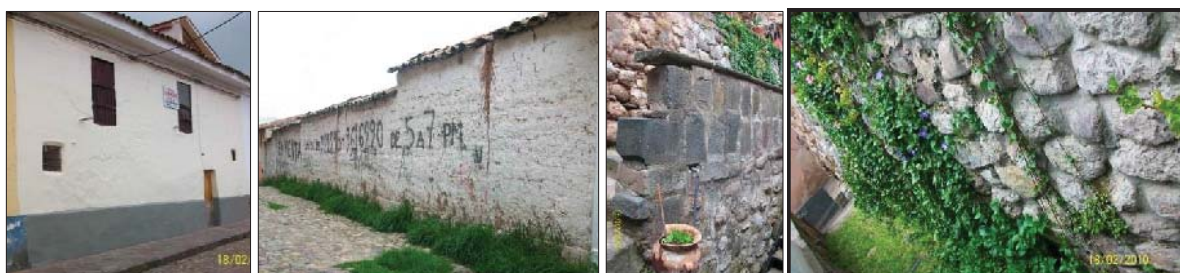
Fig. 255. Vista externa del predio. En el interior del inmueble se presencia elementos líticos reutilizados en parte de estructuras del inmueble a base de andesita y caliza.
