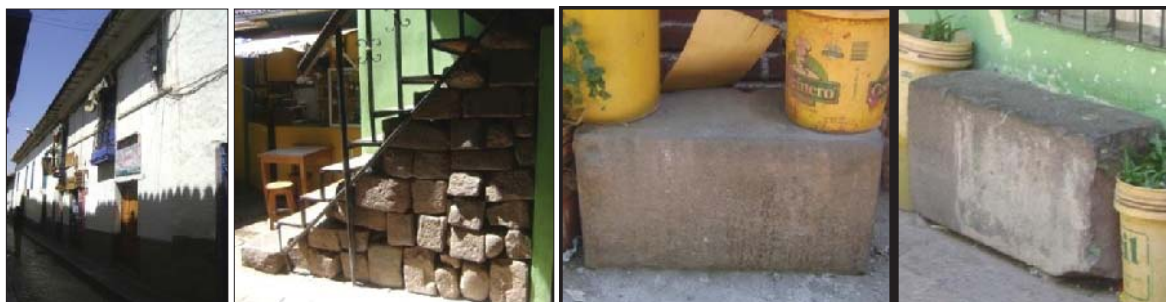
Fig. 305. Vista externa del predio. En el interior se evidencia reutilización de material lítico detrás de la escalera metálica, así mismo se observa algunos litos sueltos del tipo andesita.
