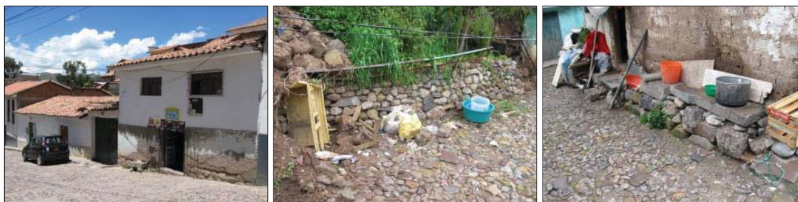
Fig. 93. Vista externa del predio, donde en la parte interna se evidencia un muro de contención con material lítico reutilizado, y algunos elementos líticos sueltos usados como banquetas.
