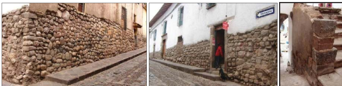
Fig. 194. Vista externa del predio, donde se observa un muro de contención Inka edificado con material caliza, así como un muro con material reutilizado, en las fachadas hacia Pumakurko y Waynapata respectivamente. En el interior se evidencia material lítico prehispánico suelto.
