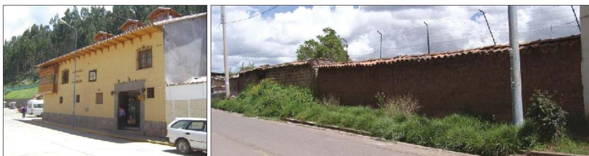
Fig. 367. Vista externa e interna del inmueble si presencia de material arquitectónico prehispánico.
