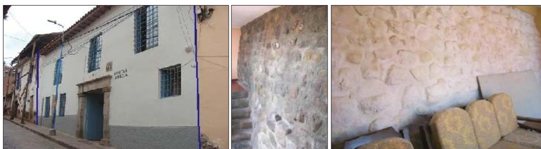
Fig. 341. Vista externa del inmueble. En el interior se evidencia un muro de contención con material lítico reutilizado.
