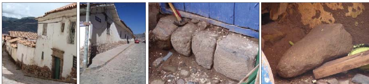
Fig. 226. Vista externa del predio con presencia de material lítico prehispánico reutilizado. En el interior se evidencia un muro de contención con material lítico prehispánica ubicado hacia el lado Norte en el interior del inmueble.
