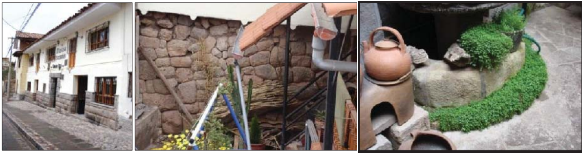
Fig. 159. Vista externa del predio sin presencia de evidencia arquitectónica prehispánica. Dentro del inmueble se tiene la presencia de un muro de contención de factura Inka, así como algunas formas estructurales con material reutilizado.
