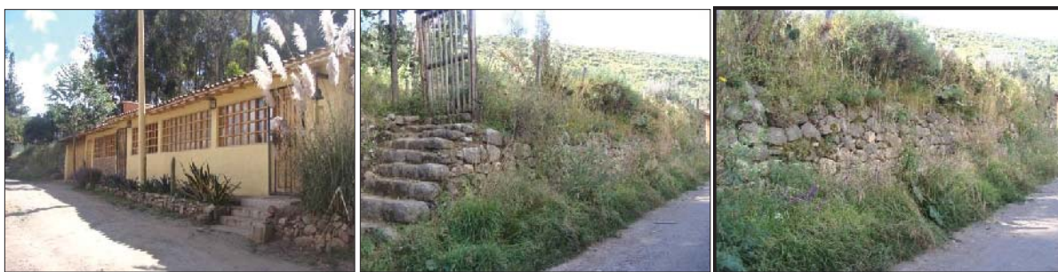
Fig. 359. Vista externa del predio con presencia de un muro de contención con material lítico reutilizado, la misma que presentaría una traza prehispánica original.
