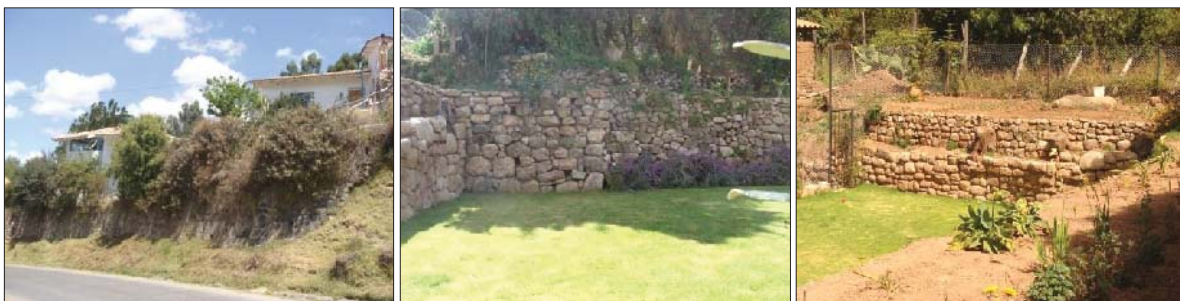
Fig. 352. Vista externa del inmueble donde se evidencia material lítico reutilizado. Al interior del inmueble se observa la existencia de un muro de contención Inka a base de litos caliza.
