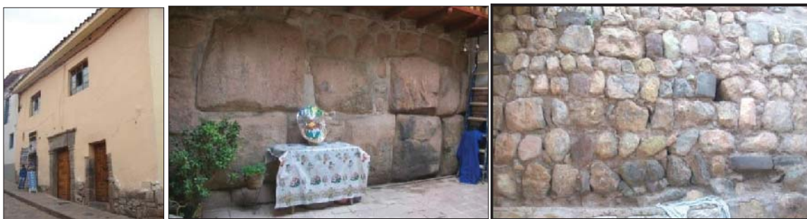
Fig. 342. Vista externa del inmueble. En el interior se evidencia un muro de contención a base de caliza que tiene un aparejo del tipo engastado, así mismo se tiene un muro con material reutilizado.
