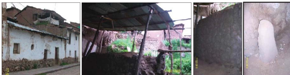
Fig. 269. Vista externa del predio, con evidencia de material reutilizado. En el interior se evidencia un muro de contención con material lítico reutilizado, un muro de contención de factura prehispánica reconstruido y un lito suelto trabajada como clavo lítico
