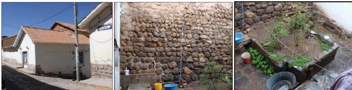
Fig. 223. Vista externa del predio con presencia de material lítico prehispánico reutilizado. En el interior se evidencia un muro de contención con material lítico prehispánico ubicado hacia el lado Norte en el interior del inmueble.
