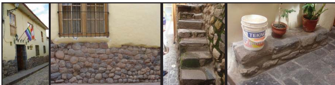
Fig. 231. Vista externa del predio con presencia de elementos líticos reutilizados. En el interior se evidencia algunas estructuras con elementos líticos reutilizados.
