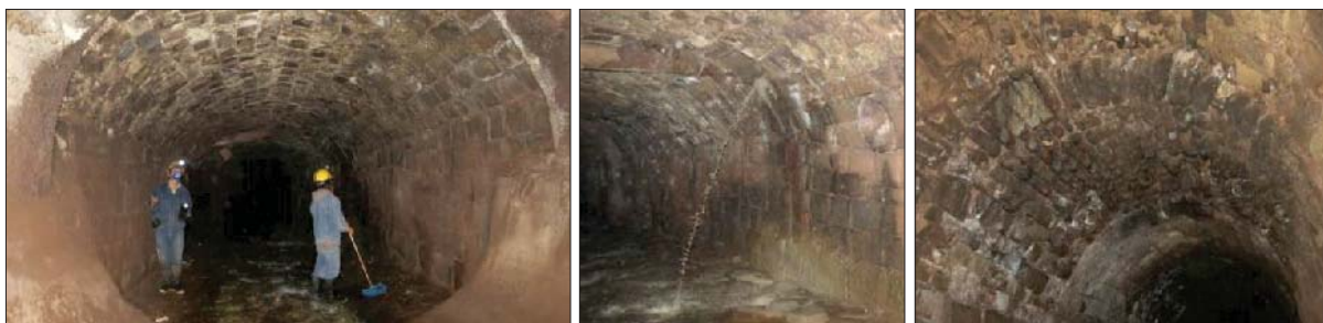
Fig. 394. Vista de la canalización del Río Saphi desde la intersección con la calle Tigre y Siete Cuartones hasta la intersección con la calle Espaderos y Portal de Panes, con material lítico prehispánico reutilizado.
