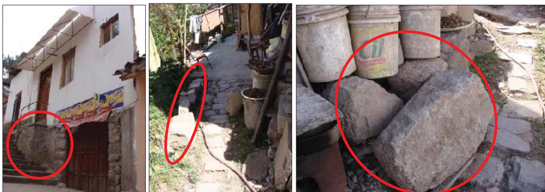
Fig. 76. Vista externa e interna del predio, donde los círculos rojos muestran el enchape con litos reutilizados y algunos elementos líticos aglomerados de material andesita y caliza de periodo prehispánico (Inka).
