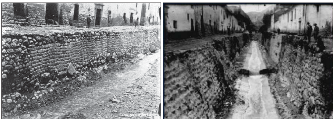
Fig. 31. Muestra restos de muro encausador Inka del río Saphi, sectores aledaños a la calle Conquista. Fuente. Revista Life (1950)
