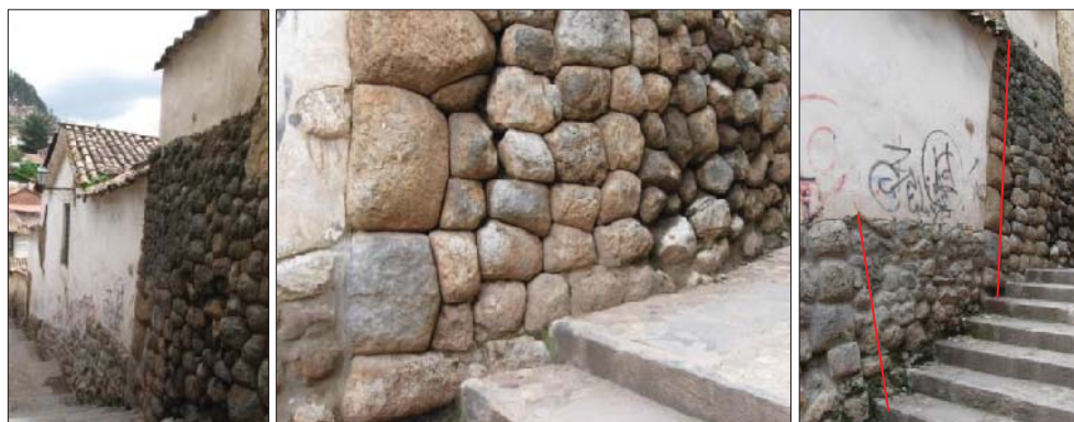
Fig. 125. Vista externa del predio con presencia de muro Inka a base de litos de material caliza en la calle ladrillos, así mismo se evidencia dos esquinas de muro que indican la existencia de una calle prehispánica cerrada.
