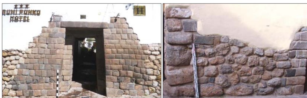
Fig. 410. Imagen donde se muestra un muro con litos reutilizados en su estructura y un vano y muro original que también es parte de una estructura edilicia calle Choquechaka.
