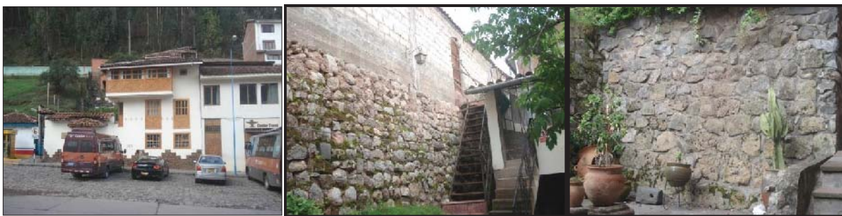
Fig. 364. Vista externa del predio. En el interior del inmueble se observa dos muros de contención con material lítico reutilizado.
