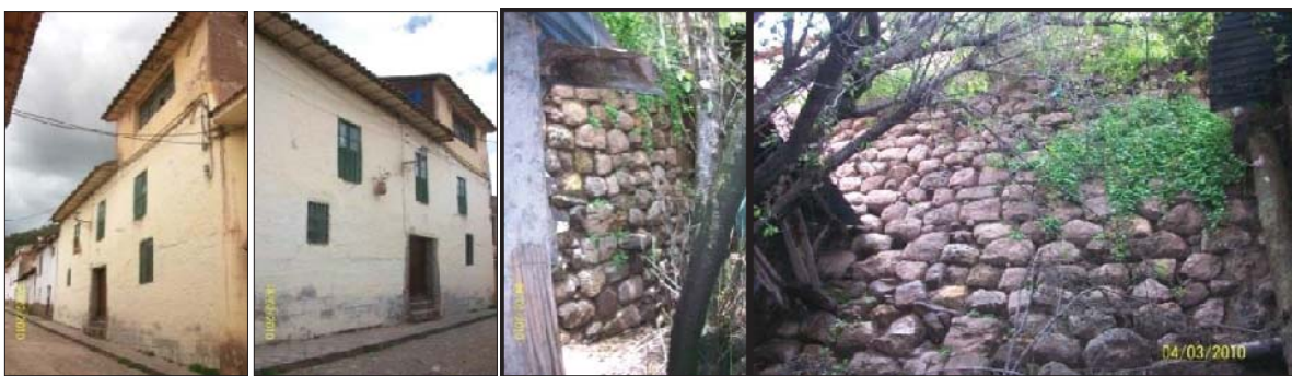
Fig. 268. Vista externa del predio, con evidencia de material reutilizado en la puerta de acceso al inmueble. En el interior se evidencia un muro de contención con material lítico reutilizado.
