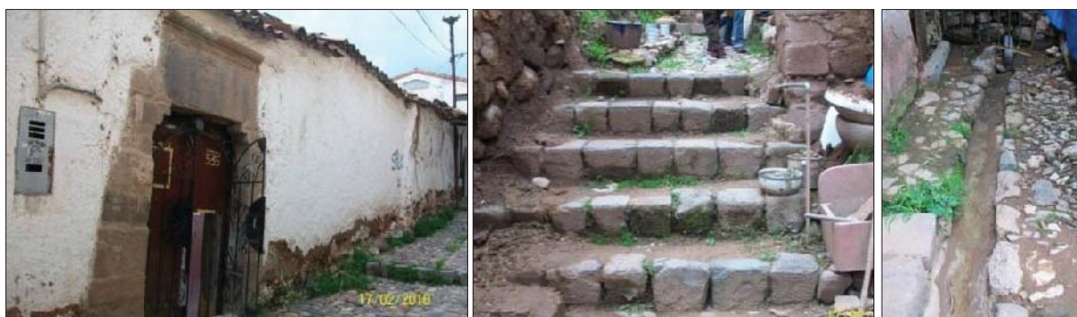
Fig. 257. Vista externa del predio. En el interior del inmueble se presencia una escalinata y una canal de desfogue de aguas pluviales con elementos líticos reutilizados.
