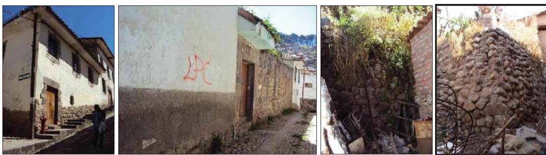
Fig. 172. Vista externa del predio, con presencia de material lítico reutilizado. En el interior del predio se evidencia un muro de contención Inka y un muro con material reutilizado.
