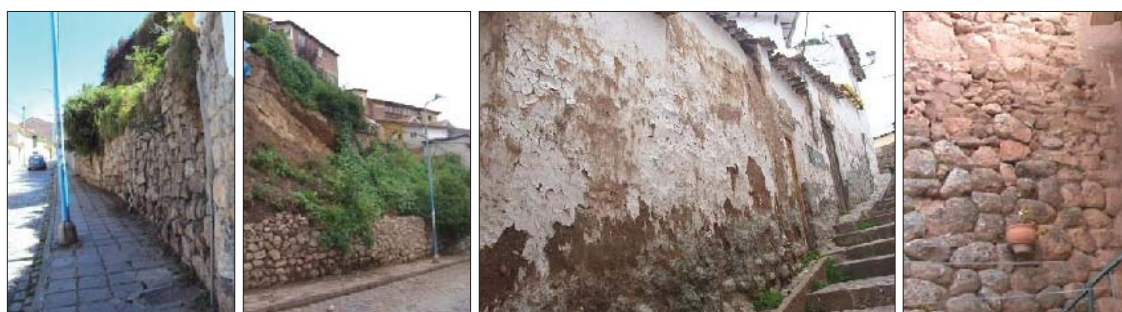
Fig. 289. Vista externa del predio de ambas fachadas se evidencia material lítica reutilizada. En la parte interna del predio se evidencia un muro de contención Inka edificada a base de material caliza.
