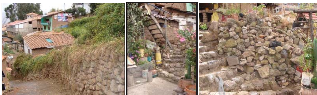
Fig. 155. Vista externa del predio, donde se evidencia un muro de contención con material lítico prehispánico reutilizado. En el interior se evidencia algunas estructuras con material reutilizado, así como un montículo de litos prehispánicos.
