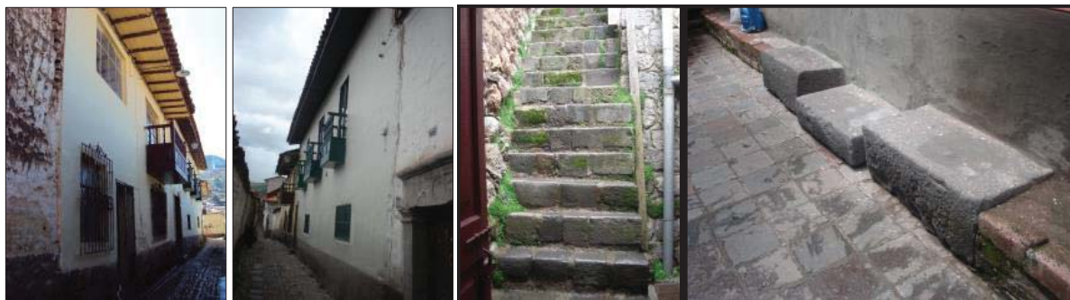
Fig. 174. Vista externa del predio. En el interior del predio se evidencia algunas estructuras con material reutilizado y elementos líticos sueltos.
