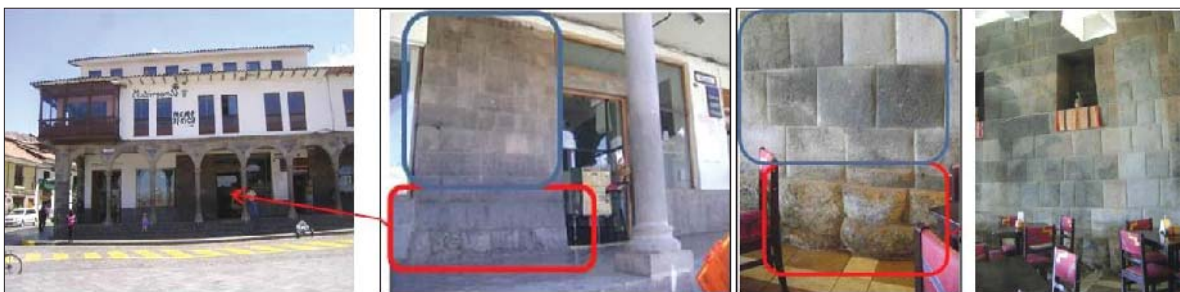
Fig. 313. Vista externa del inmueble con evidencia de muro estructural de factura Inka. En el interior observa otro muro Inka de aparejo sedimentaria a base de material andesita, así como nichos de forma trapezoidal.
