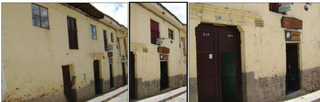
Fig. 232. Vista externa del predio con presencia de elementos líticos reutilizados.
