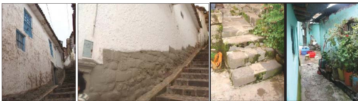
Fig. 290. Vista externa del predio donde en la fachada se evidencia material lítica reutilizada. En la parte interna del predio se evidencia una escalera con litos reutilizados, así como litos sueltos que sirven de base a macetas de plantas ornamentales.
