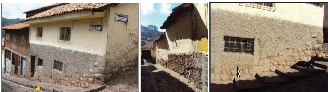
Fig. 205. Vista externa del predio, donde se evidencia reutilización de material lítico prehispánico en las fachadas del inmueble.
