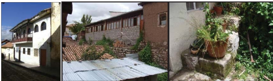
Fig. 192. Vista externa del predio. En el interior se evidencia un muro medianero con material reutilizado, así mismo se tiene litos sueltos en el patio del inmueble.
