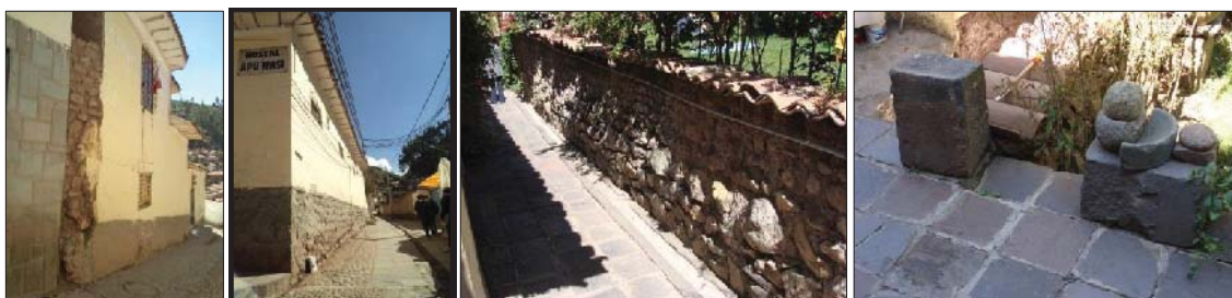
Fig. 161. Vista externa del predio con presencia de material lítico prehispánica reutilizado. Dentro del inmueble se tiene la presencia de estructuras con litos reutilizados y algunos litos sueltos.
