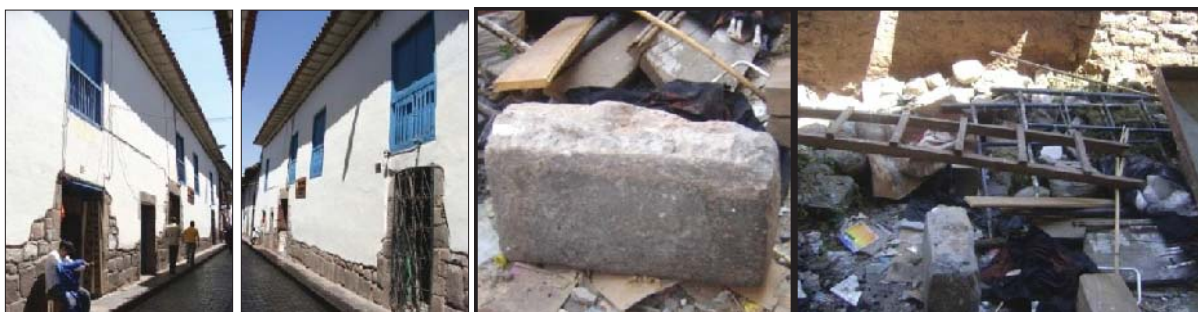
Fig. 306. Vista externa del predio donde se evidencia en el sobrecimiento reutilización de material lítico. En el interior se observa algunos litos sueltos del tipo andesita.
