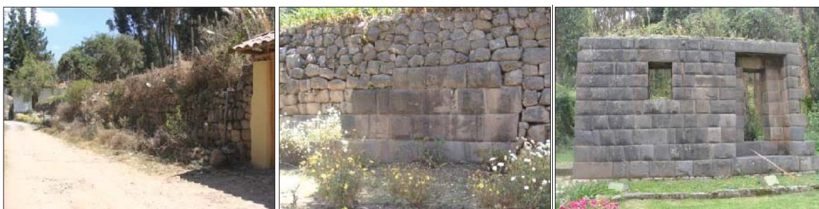
Fig. 358. Vista externa del predio con presencia de un muro de contención con material lítico reutilizado, así como un segmento de muro Inka a base de andesita, en la fachada lado Sur. En el interior se observa un muro edificado con material andesita que presenta un vano de acceso y una ventana.
