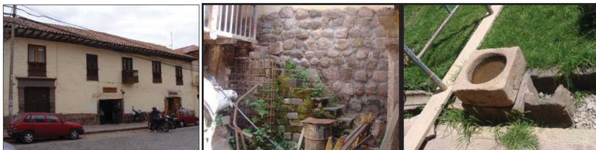
Fig. 240. Vista externa del predio, con presencia de material lítico prehispánico reutilizado. En el interior lado Este se tiene un muro de contención con material lítico prehispánico reutilizado, también se tiene litos tallados en andesita.
