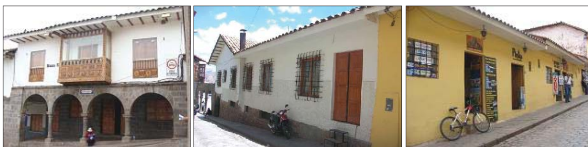
Fig. 333. Vista externa del inmueble sin presencia de material arquitectónica prehispánica.
