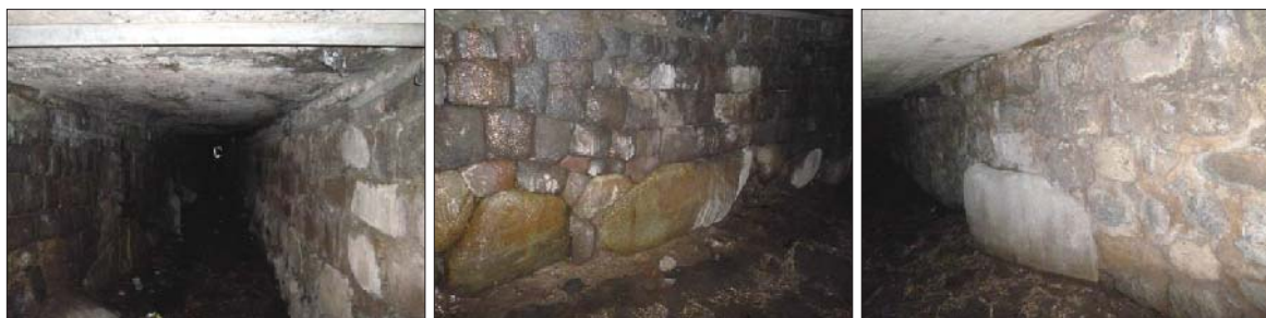
Fig. 399. Vista de la canalización del Río Tullumayo desde el límite lado Norte de la Calle Choquechaka hasta la intersección con la calle Ladrillos, donde se observa un muro encausador Inka, al lado Oeste del rio, asimismo se tiene el otro muro con material andesita y diorita verde reutilizado, la solera con litos contemporáneos.
