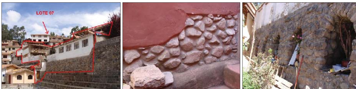
Fig. 88. Vista externa e interna del predio, donde se evidencia elementos líticos reutilizados en sobrecimientos, así mismo dentro del predio se observa la continuidad del canal colonial con material reutilizado.
