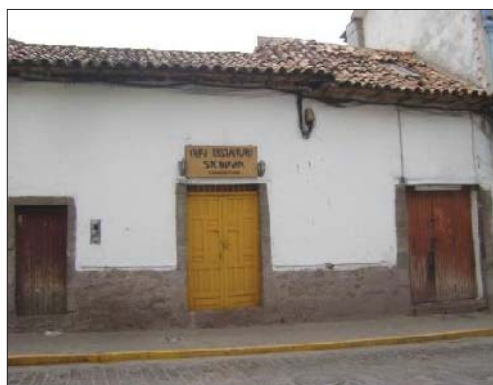
Fig. 322. Vista externa del inmueble donde se evidencia material lítico reutilizado
