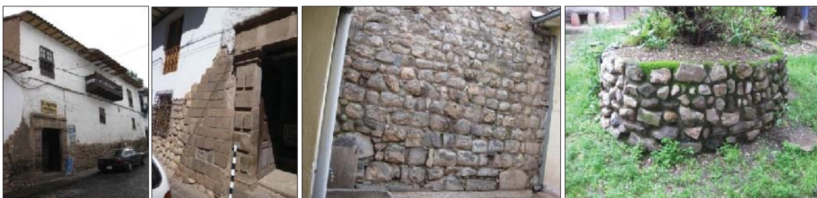
Fig. 117. Vista externa del predio con presencia de muro de contención Inka, y restos de una jamba de un vano de acceso, así mismo en el interior se muestra muro de contención y una forma estructural con material lítico prehispánico.
