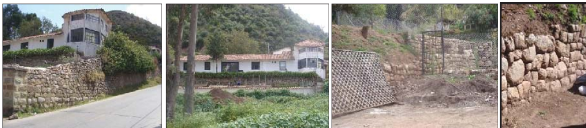
Fig. 353. Vista externa del inmueble donde se evidencia material lítico reutilizado. Al interior del inmueble se observa la existencia de un muro de contención Inka a base de litos caliza.
