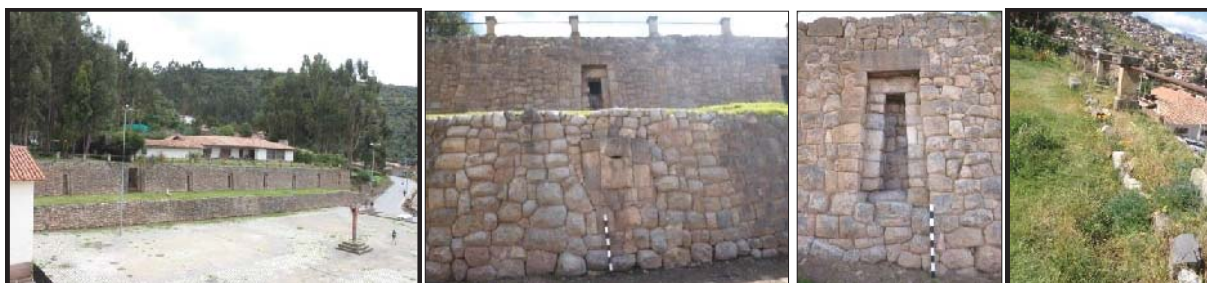
Fig. 355. Vista externa del inmueble donde se evidencia el muro de contención Inka con nichos de doble jamba. En el interior se observa de algunos elementos líticos sueltos.
