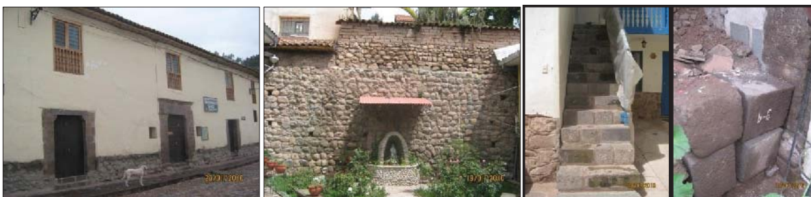
Fig. 197. Vista externa del predio, donde se observa reutilización de material lítico en el sobrecimiento del inmueble. En el interior se evidencia un muro de contención y escalinatas con material reutilizado, así como material lítico suelto.
