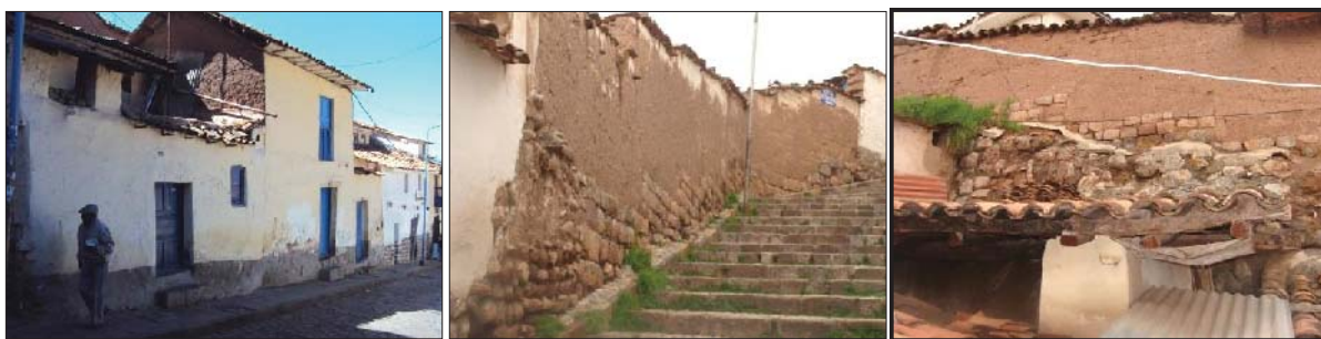
Fig. 292. Vista externa del predio donde en ambas fachadas se evidencia material lítico reutilizado. En la parte interna del predio se evidencia un muro de contención con material lítico prehispánico reutilizado.
