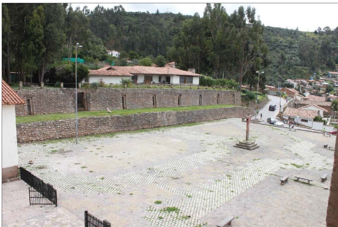
Fig. 9. Vista panorámica de muros de contención de filiación Inka con nichos orientados en sentido Sur. Fuente: Propia
