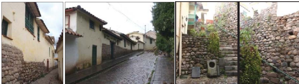
Fig. 278. Vista externa del predio, con evidencia de material lítico reutilizado en las fachadas del inmueble a manera de muro de contención. En el interior de observa estructuras contemporáneas como escalinatas y muros de contención con material lítico reutilizado.
