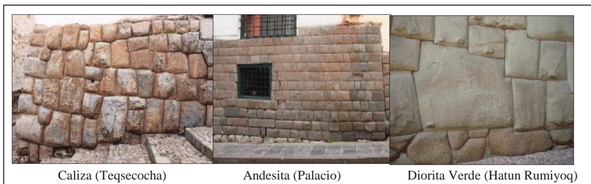
Fig. 7. Tipos de material constructivo utilizado para la construcción Inka dentro del barrio de Qolqampata Fuente: Propio.
