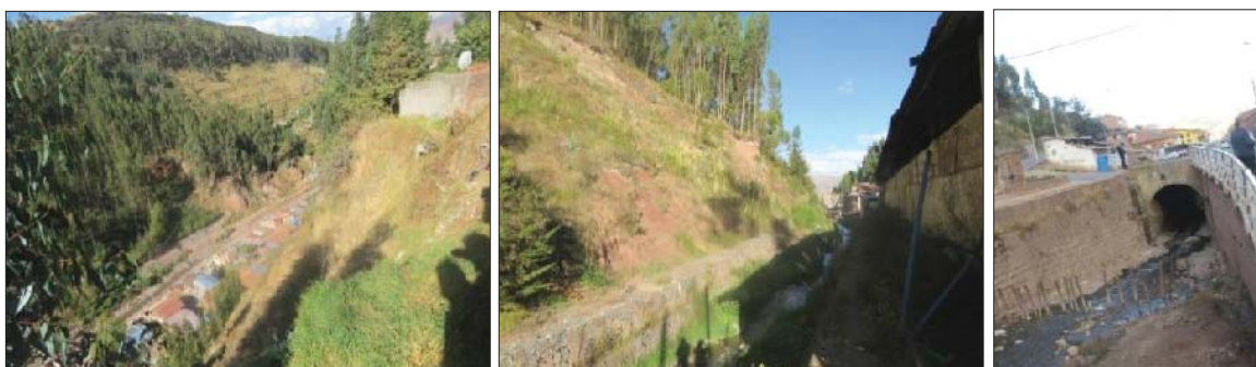
Fig. 390. Vista de la canalización contemporánea del Río Saphi en los primeros 70m de longitud desde el campamento Municipal del Cusco hasta el inicio de la calle Saphi, sin evidencia arquitectónica prehispánica.
