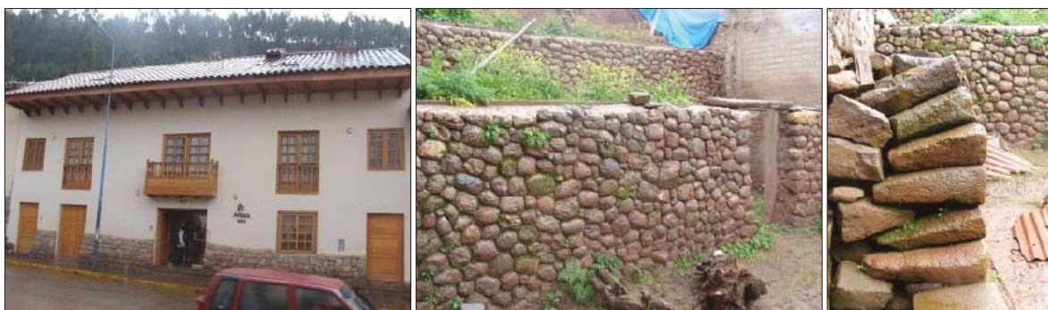
Fig. 386. Vista externa del inmueble con evidencia de material reutilizado. En el interior se evidencia dos muro de contención y un montículo de elementos líticos prehispánicos reutilizados.
