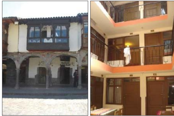
Fig. 309. Vista externa e interna del inmueble sin presencia de material prehispánico reutilizado.
