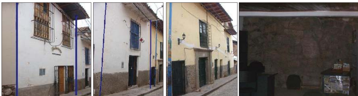
Fig. 339. Vista externa del inmueble. En el interior se evidencia un muro de contención de factura Inka con material lítico del tipo caliza.
