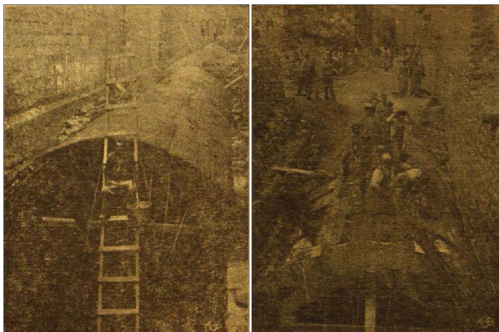
Fig. 29. Obra canalización del río Saphi, en la sección Calle Plateros y Santa Teresa. Fuente: Diario El Comercio del Cusco (1934)
