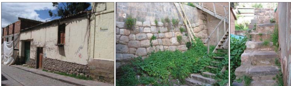
Fig. 98. Vista externa del predio donde se evidencia material lítico prehispánico reutilizado, así mismo dentro del predio se evidencia un muro de contención Inka, así como la presencia de litos reutilizados.
