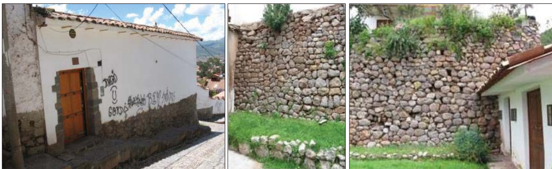
Fig. 107. Vista externa del predio donde se evidencia material lítico prehispánico reutilizado, así mismo al interior de esta se evidencia un muro de contención Inka de aparejo celular.
