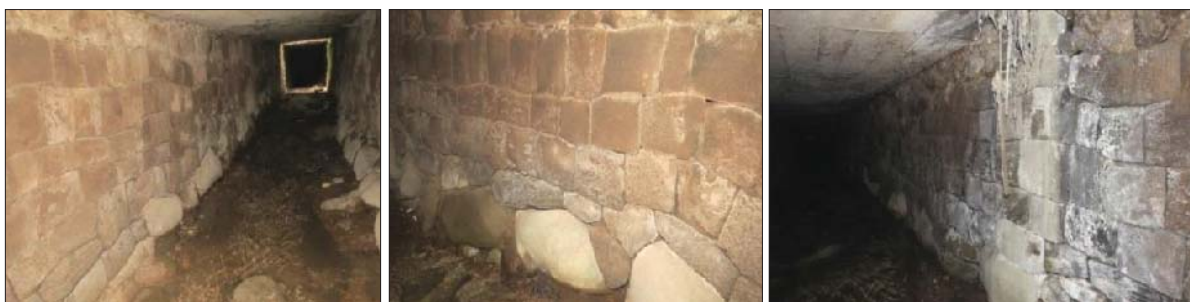
Fig. 400. Vista de la canalización del Río Tullumayo desde la altura con la calle Ladrillos hasta la intersección con la calle Siete Culebras, donde se observa un muro encausador Inka, al lado Oeste del río, asimismo se tiene el otro muro con material andesita y diorita verde reutilizado, la solera con litos contemporáneos.
