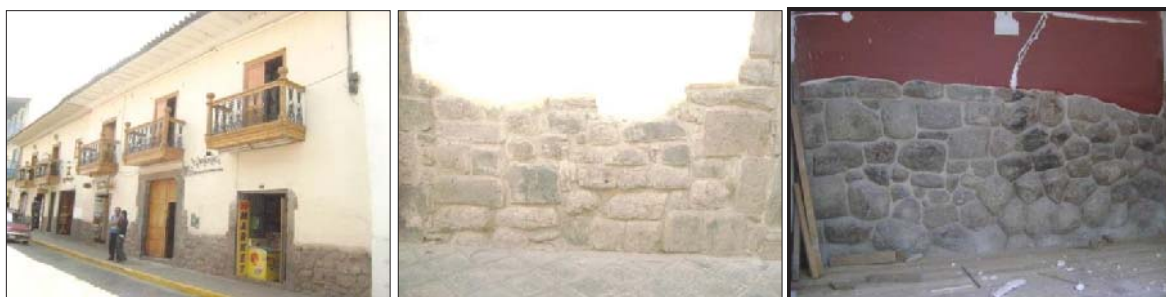
Fig. 319. Vista externa del inmueble donde se evidencia material lítico reutilizado. En el interior se evidencia material arquitectónico prehispánico reutilizado.
