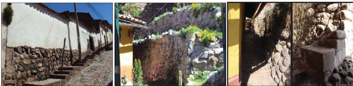
Fig. 171. Vista externa del predio, con presencia de material lítico reutilizado. En el interior del predio se evidencia algunas estructuras con material utilizado.
