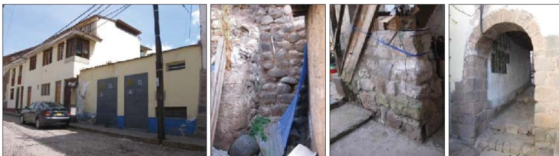
Fig. 208. Vista externa del predio. En el interior del inmueble se evidencia un conjunto de elementos estructurales con material lítico reutilizado.
