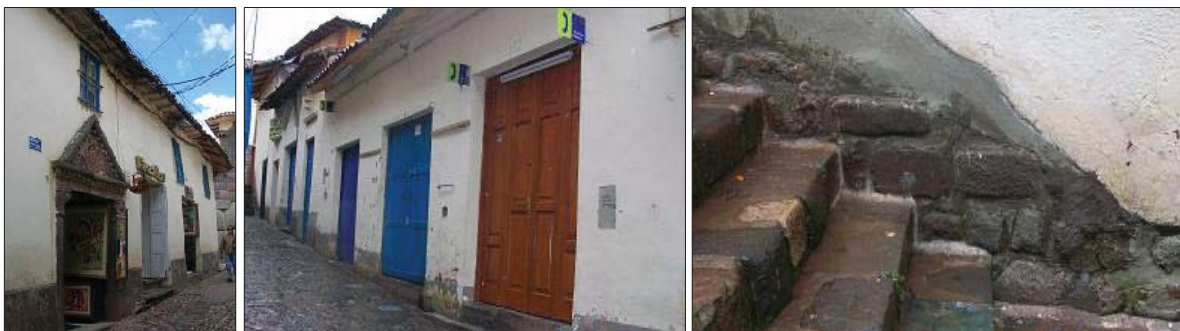
Fig. 152. Vista externa del predio, donde se evidencia algunos litos reutilizados. En el interior se evidencia algunas estructuras con material reutilizado.
