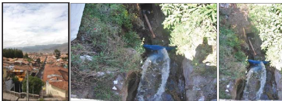
Fig. 398. Vista de la canalización del Río Tullumayo desde la intersección con la calle Siete Borreguitos hasta el inicio de la calle Choquechaka, se observa una solera adecuada en afloramiento rocoso y muros encausadore.
