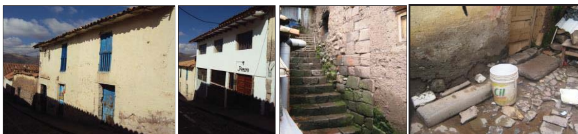
Fig. 206. Vista externa del predio, donde se evidencia reutilización de material lítico prehispánico en la fachada del inmueble. Asimismo en el interior del inmueble se evidencia un lito a manera de dintel trabajada en andesita.
