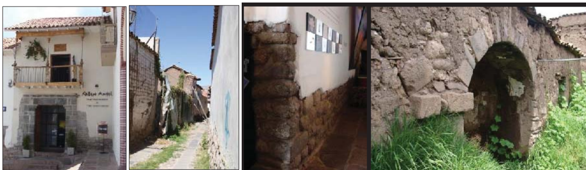
Fig. 221. Vista externa del predio con presencia de material lítico prehispánico reutilizado ubicado en el sobrecimiento de la fachada. En el interior del inmueble se muestra parte de los muros con material reutilizado, al igual que un arco de medio punto de periodo Colonial.
