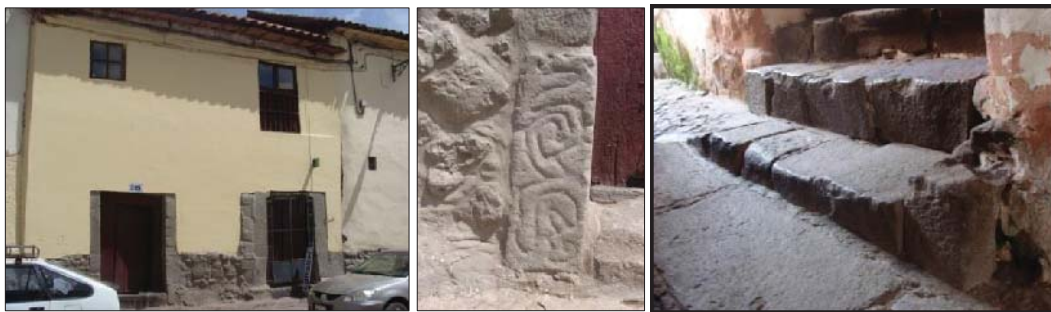
Fig. 198. Vista externa del predio, donde se observa reutilización de material lítico, esta se halla cubierta con enlucido de cemento. En el interior se evidencia una escalinata con material reutilizado.
