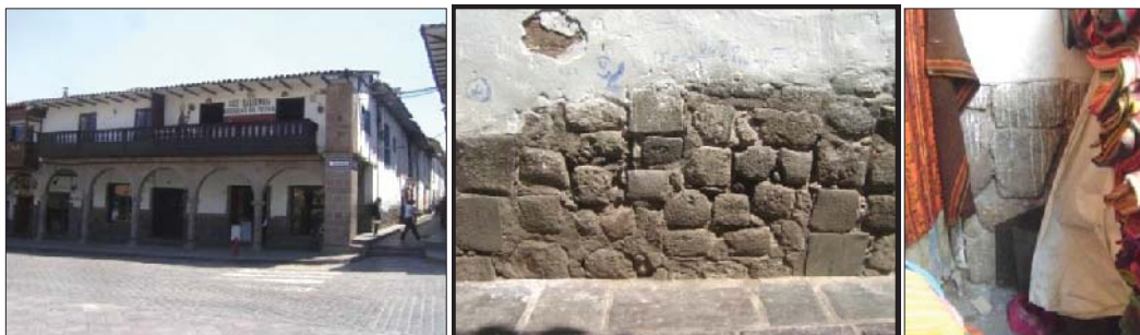
Fig. 307. Vista externa del predio donde se evidencia en el sobrecimiento reutilización de material lítico. En el interior se observa parte de un muro restos de material reutilizado.
