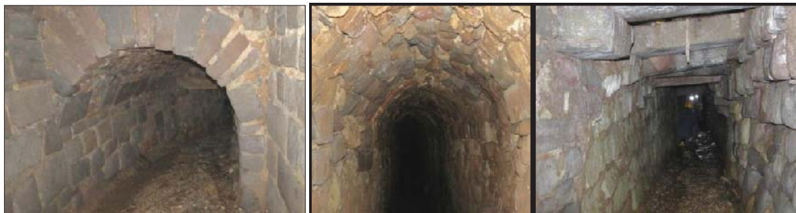
Fig. 402. Vista de la canalización del Río Tullumayo desde la altura con la calle Hatun Rumiyoq hasta la intersección con la calle Ruinas, donde se observa el canal con inclusión de bóveda y muros laterales con material lítico prehispánico reutilizado.
