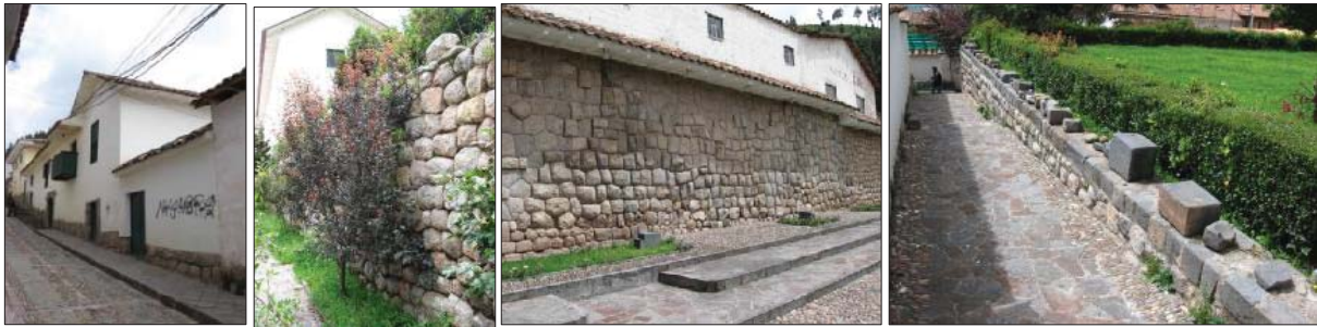
Fig. 103. Vista externa del predio donde se evidencia a nivel de sobrecimiento material lítico reutilizado, así mismo dentro del predio se evidencia dos muros de contención Inka, así mismo dentro del predio se evidencia bloques líticos sueltos
