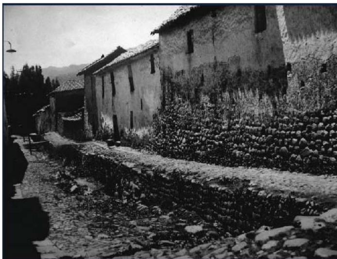
Fig. 35. Calle Choquechaka, donde se nota el muro encausador de periodo Inka Fuente: Ibero-Americanisches Institut (1960)
