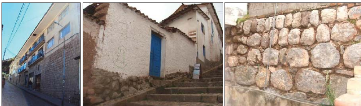
Fig. 291. Vista externa del predio donde en ambas fachadas se evidencia material lítica reutilizada. En la parte interna del predio se evidencia un muro de contención con material lítico prehispánico reutilizado.
