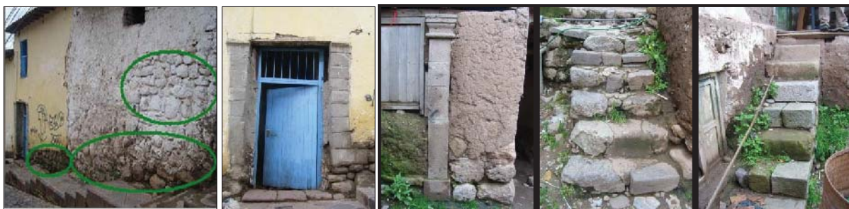
Fig. 169. Vista externa del predio, con material lítico reutilizado. En el interior del predio se evidencia algunas estructuras con material utilizado.
