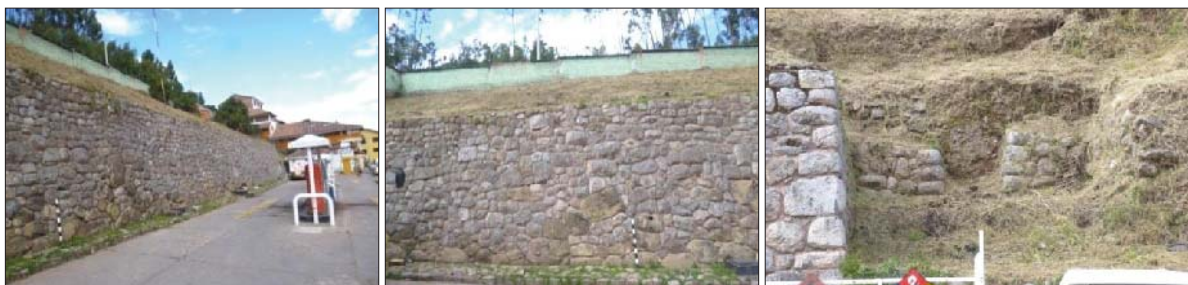
Fig. 363. Vista externa del predio que es el área del grifo en esta se tiene un muro de contención Inka de aparejo celular, edificada con material caliza.
