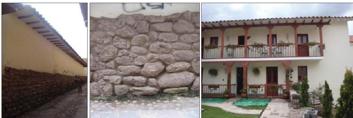
Fig. 123. Vista externa del predio con presencia material lítico prehispánico reutilizado. Así mismo en el interior del inmueble se evidencian algunas formas estructurales con material lítico reutilizado.
