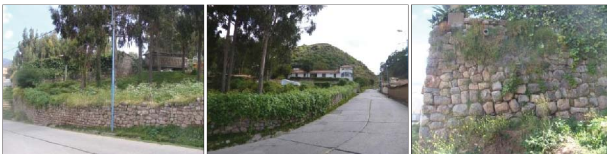
Fig. 354. Vista externa del inmueble donde se evidencia material lítico reutilizado. Al interior del inmueble se observa la existencia de un muro de contención Inka a base de litos caliza.
