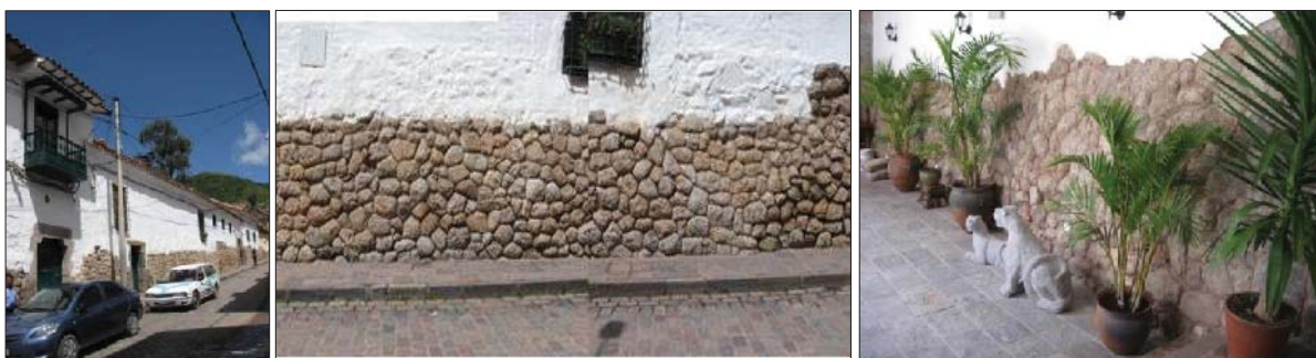
Fig. 116. Vista externa del predio con presencia de muro de contención Inka, así mismo en el interior se muestra muro de contención con material lítico prehispánico reutilizado.
