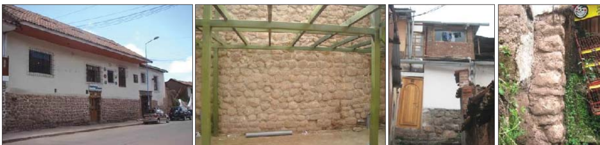
Fig. 385. Vista externa del inmueble con evidencia de material reutilizado. En el interior se evidencia un muro y algunas estructuras con litos reutilizados.
