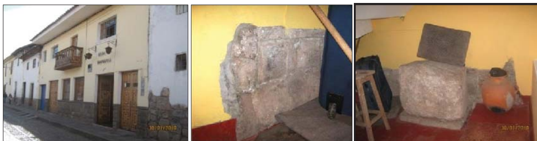
Fig. 195. Vista externa del predio, donde se observa el muro portante que forma parte de la fachada del inmueble con material reutilizado. En el interior se evidencia un segmento pequeño de muro con material reutilizado andesita, así como lítico prehispánico suelto.
