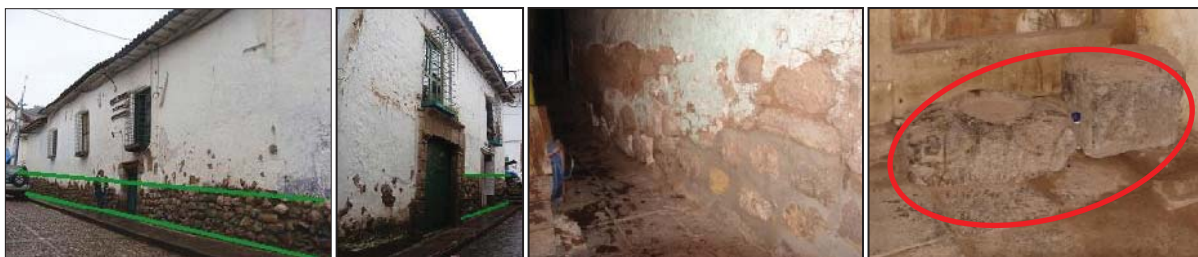
Fig. 301. Vista externa del predio donde en ambas fachadas del inmueble se evidencia material lítico reutilizado. En el interior se evidencia algunos litos sueltos del tipo andesita.
