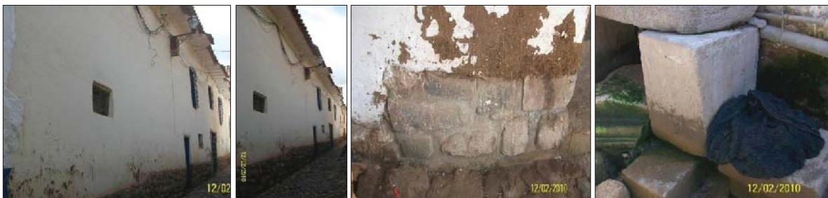
Fig. 260. Vista externa del predio con presencia de sobrecimiento con material lítico reutilizado. En el interior del inmueble se evidencia parte de un muro con material reutilizado y elementos líticos sueltos en el patio del predio.
