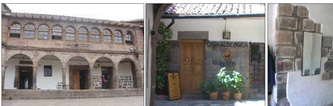
Fig. 347. Vista externa del inmueble con presencia de material lítico reutilizado. De igual forma en el interior del inmueble se tiene material lítico reutilizado.
