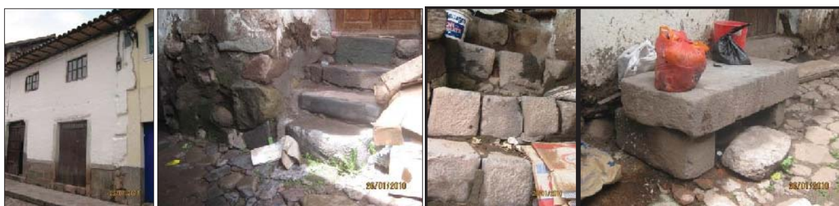
Fig. 196. Vista externa del predio, donde se observa en las puertas de ingreso reutilización de material lítico en los umbrales de estos. En el interior se evidencia escalinatas con material reutilizado, asimismo material lítico suelto trabajado a manera de dintel.
