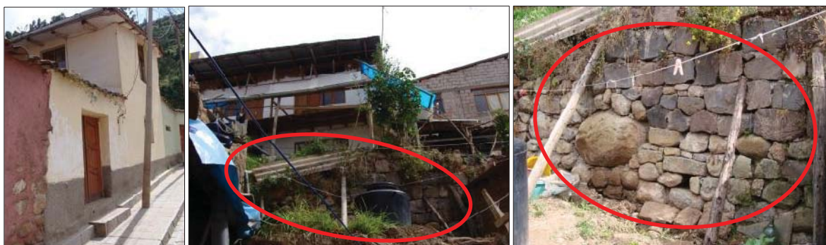
Fig. 72. Vista externa e interna del predio, donde los círculos rojos muestran los muros de contención con material lítico Prehispánico (Inka) reutilizado.
