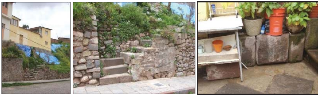
Fig. 286. Vista externa del predio, donde se evidencia un muro de contención contemporáneo con material lítico reutilizado. En el interior se tiene algunos litos sueltos.
