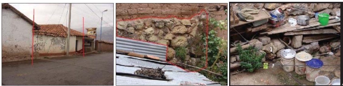
Fig. 165. Vista externa del predio, sin presencia de material arquitectónico prehispánica. En el interior del predio se evidencia un muro de con material reutilizado y un montículo de litos prehispánicas.
