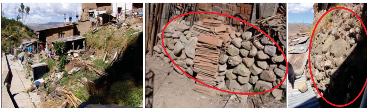
Fig. 67. Vista lateral externa e interna del predio, donde se observa la presencia de muros de contención con litos reutilizados.
