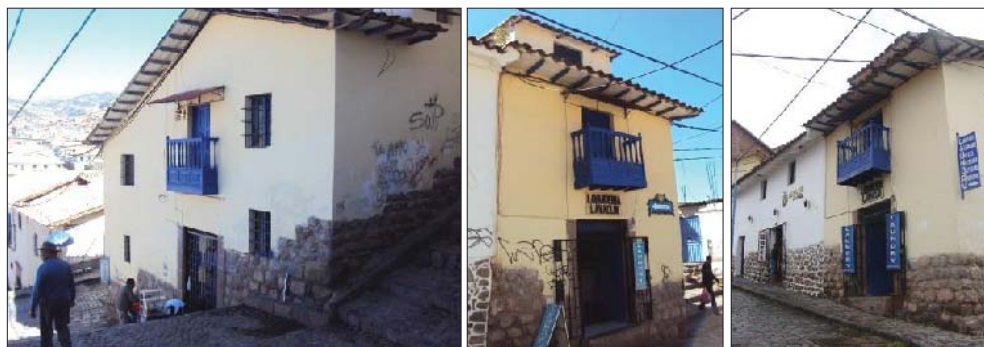
Fig. 294. Vista externa del predio donde en las fachadas se evidencia material lítico reutilizado.
