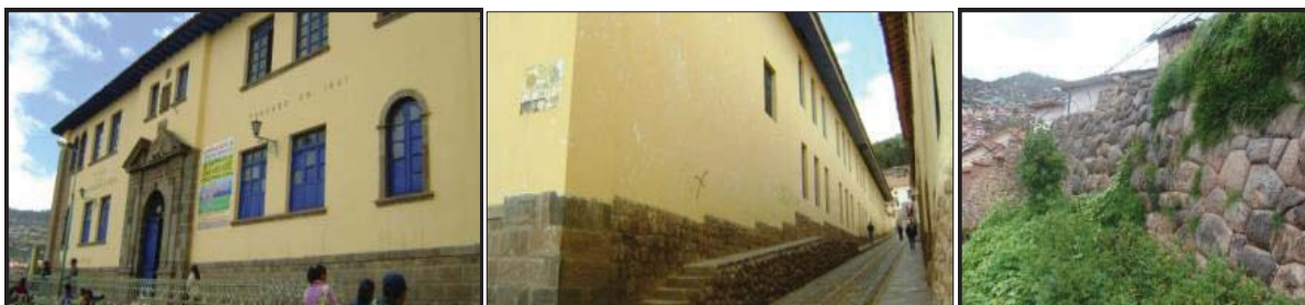
Fig. 237. Vista externa del predio, con presencia de material lítico prehispánico reutilizado. En el interior lado norte se tiene un muro de contención prehispánico original edificado a base de litos del tipo caliza.
