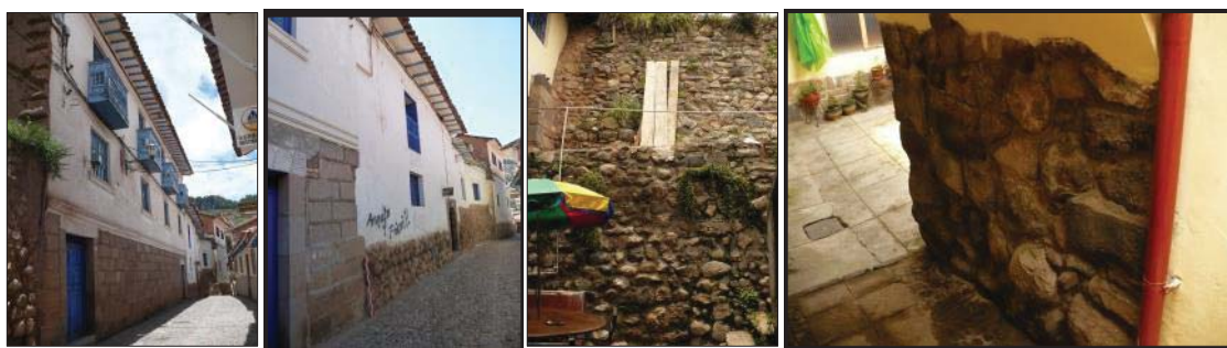
Fig. 185. Vista externa del predio con presencia de material lítico reutilizado. En el interior se evidencia un muro de contención con material reutilizado.
