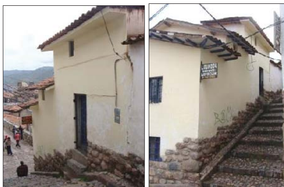
Fig. 293. Vista externa del predio donde en ambas fachadas se evidencia material lítico reutilizado.
