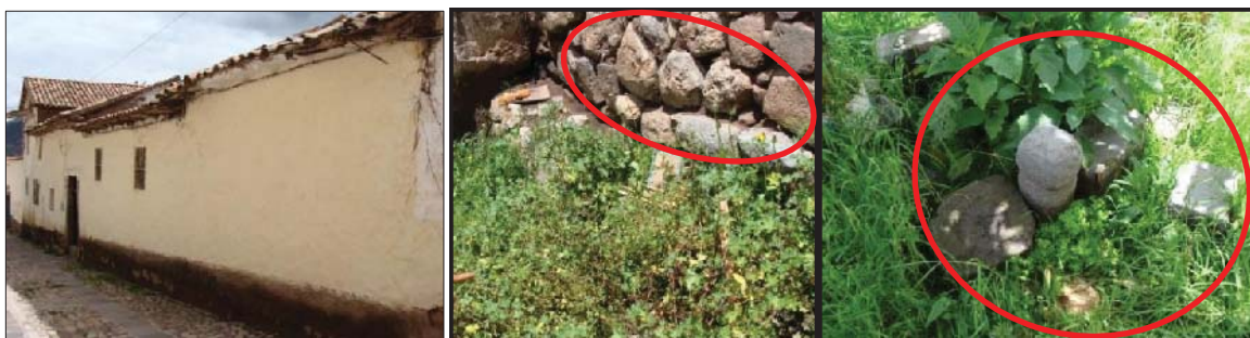
Fig. 227. Vista externa del predio con presencia de material lítico prehispánico reutilizado. En el interior se evidencia un muro de contención con material lítico prehispánica, también se tiene elementos líticos sueltos.
