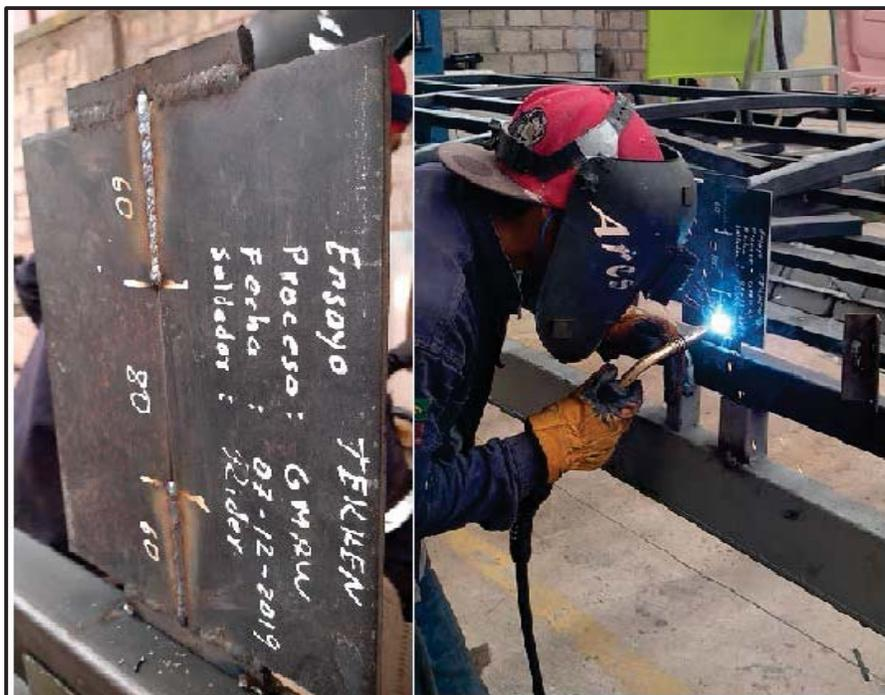
Figura 50. Probeta para ensayo TEKKEEN, proceso GMAW. Fuente propia
