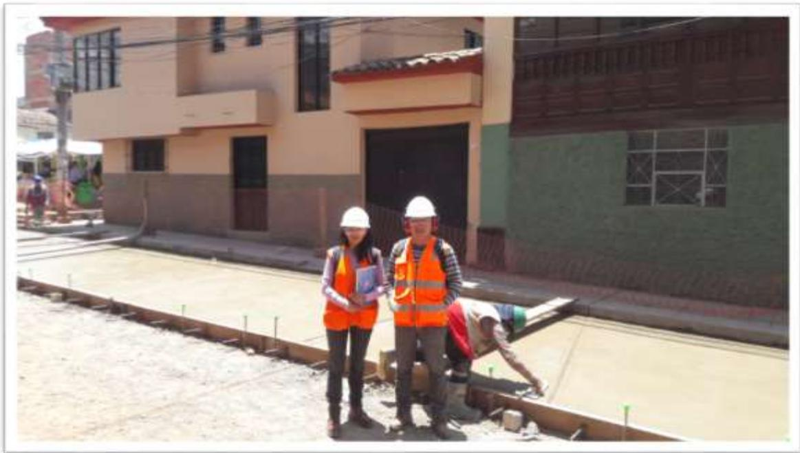
**OBRA 2 - VACIADO DE CONCRETO EN LOSA DE RODADURA - 19/10/2017**
