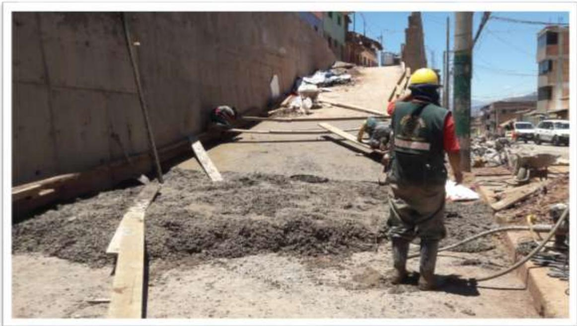
**OBRA 3 - VACIADO DE CONCRETO EN LOSA DE RODADURA - 16/09/2017**
