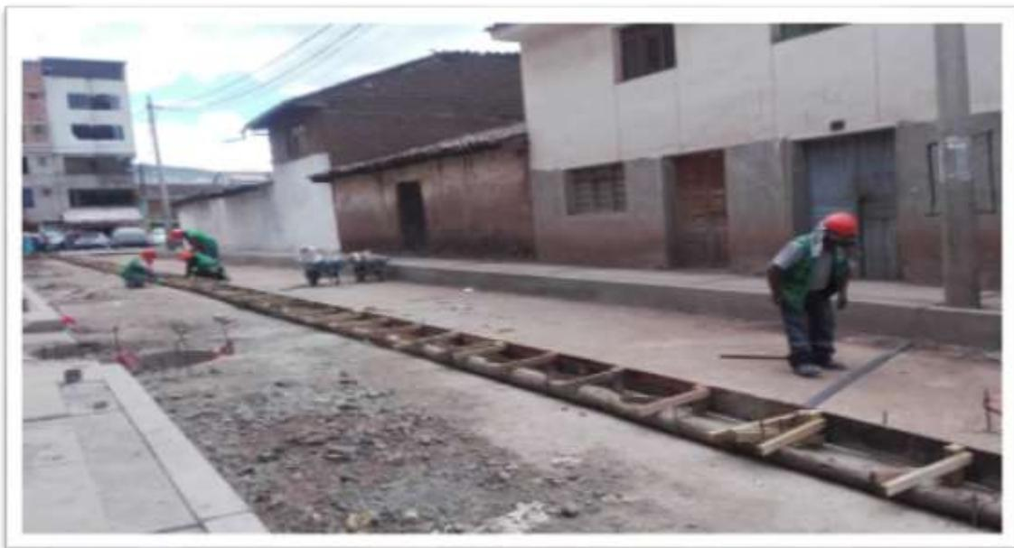
**OBRA 1 - ENCOFRADO DE LOSA DE RODADURA - 16/10/2017**
