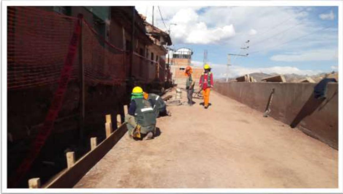
**OBRA 3 - ENCOFRADO DE LOSAS DE RODADURA - 06/09/2017**
