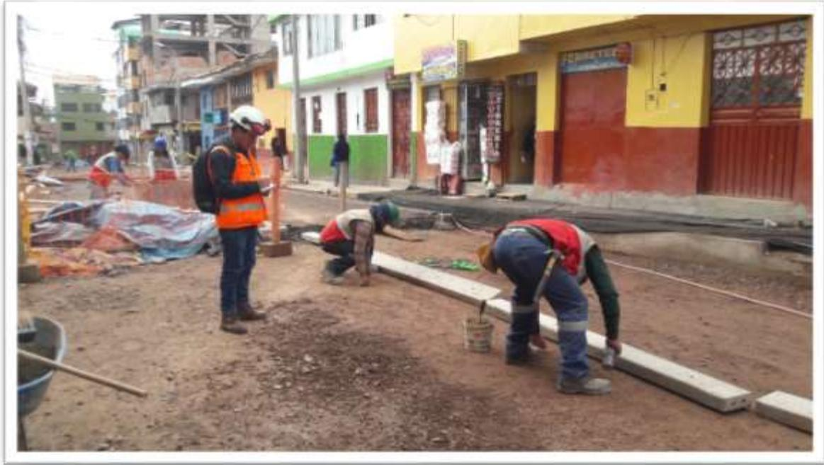
**OBRA 2 - ENCOFRADO DE LOSA DE RODADURA - 17/10/2017**
