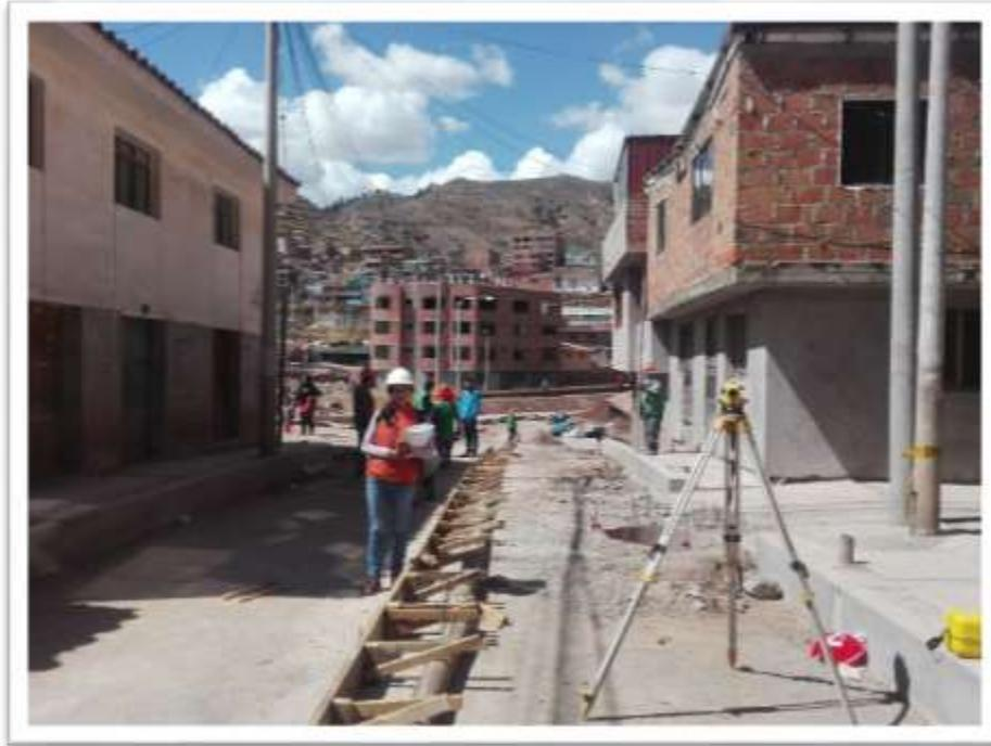
**OBRA 1 – ENCOFRADO DE LOSA DE RODADURA - 11/10/2017**
