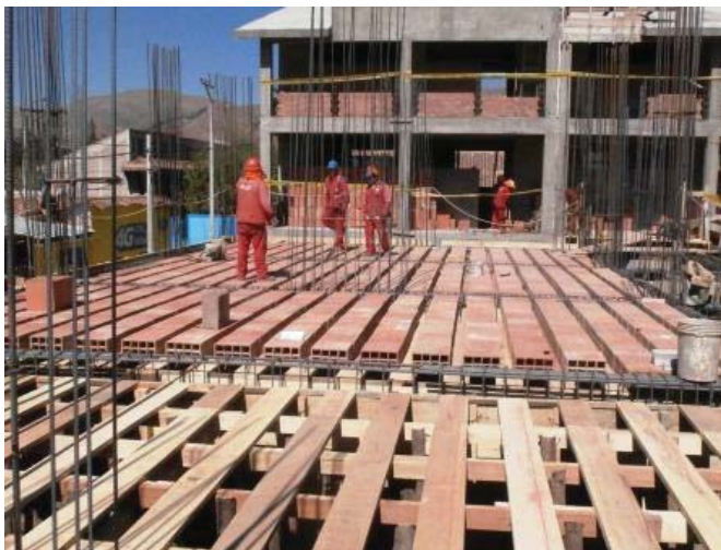
Figura N° 52: Fotografía del Encofrado de Losa.
