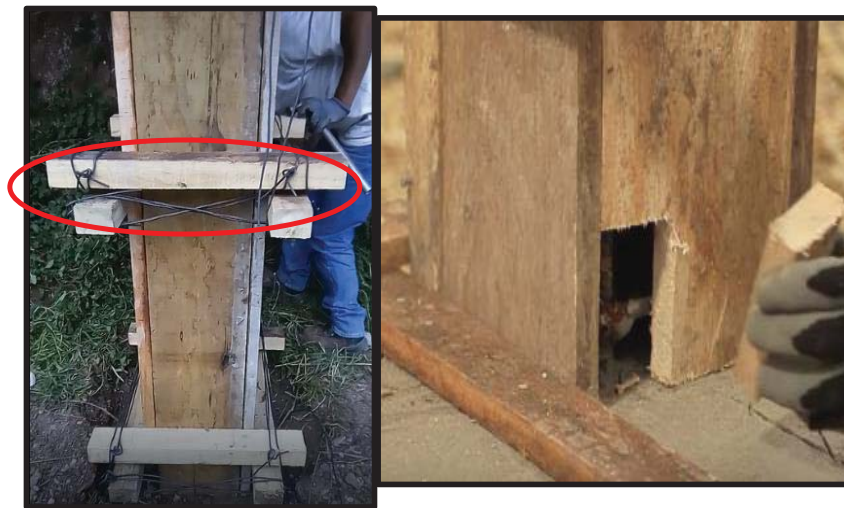
Figura N° 37: Tensado de barrotes.
