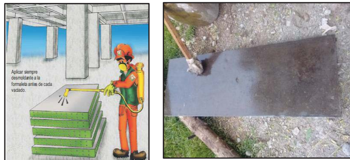
Figura N° 41: Paneles para el encofrado.
