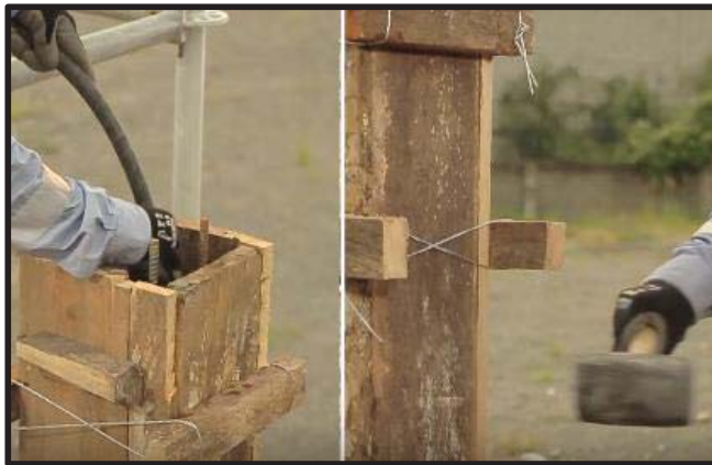
Figura N° 39: Compactado del concreto.
