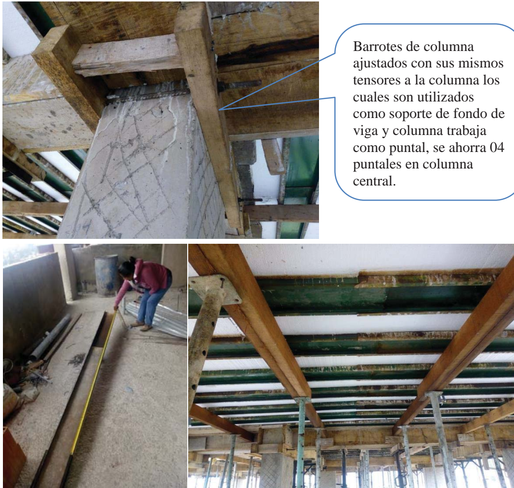
Figura N° 57: Fotografías del encofrado Mixto - Viguetas.
