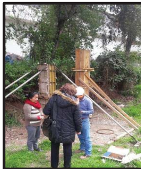
Figura N° 46: Verificando el procedimiento constructivo.
