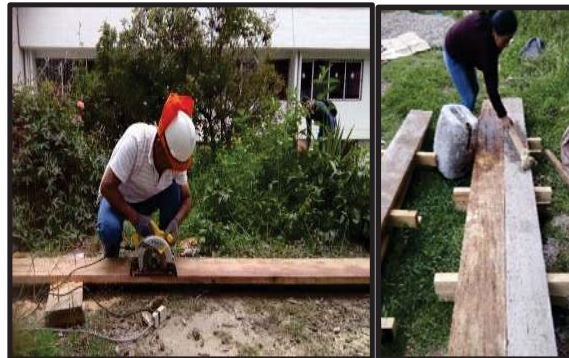
Figura N° 32: Habilidad de formas para el encofrado.
