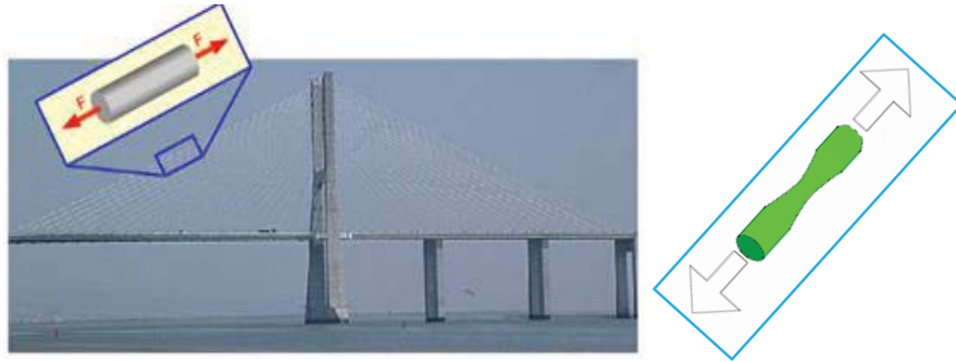
Figura N° 30: Demostración de tracción, en un puente de tirantes.
