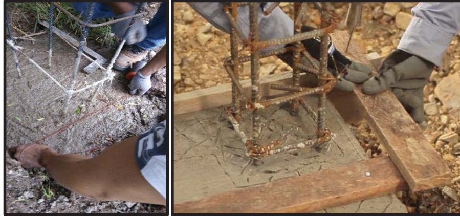
Figura N° 34: Replanteo para el encofrado.
