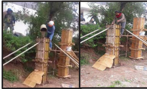
Figura N° 45: Vaciado del Concreto.
