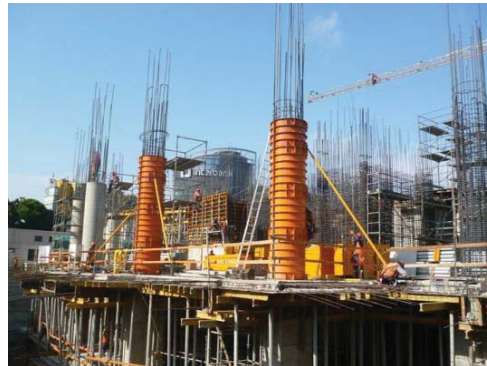
Figura N° 18: Encofrado de columnas.
