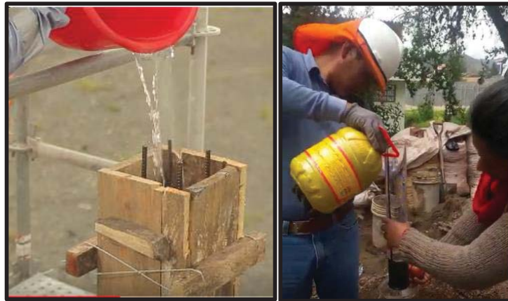
Figura N° 38: Limpieza y uso de aditivo.
