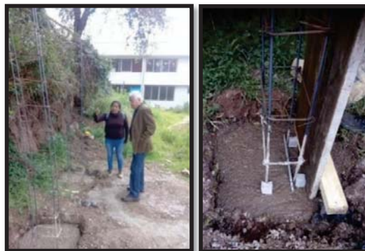
Figura N° 33: Solado y Recubrimiento.
