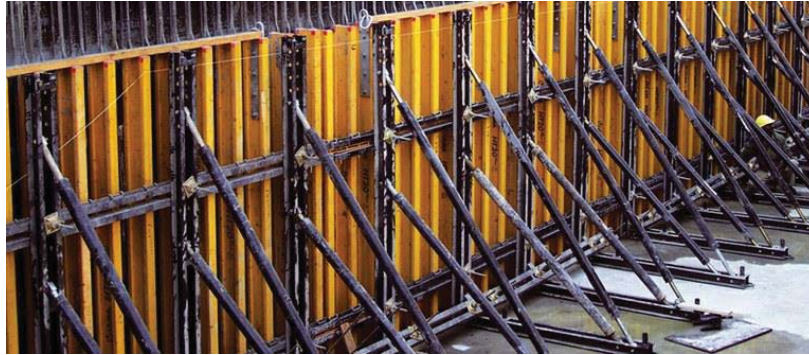
Figura N° 17: Encofrado de placas y/o muros.
