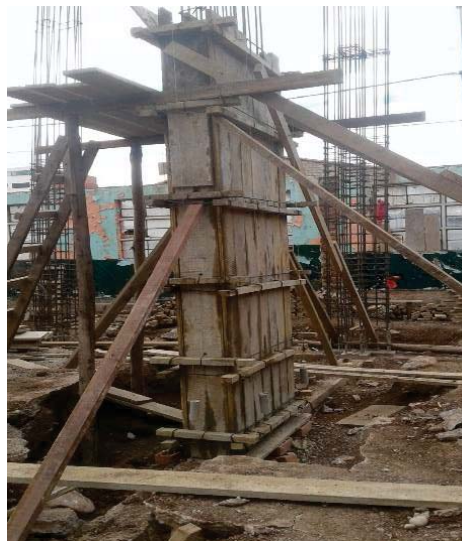
Figura N° 53: Fotografía del encofrado de columna.
