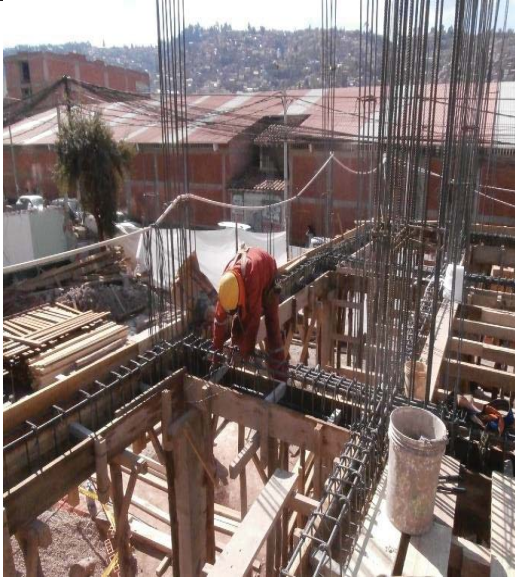
Encofrado de vigas
