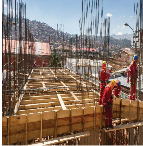
Encofrado de vigas, siempre manteniendo su nivel
