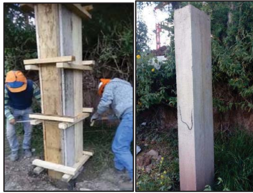
Figura N° 40: Desencofrado.
