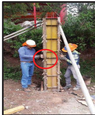
Figura N° 44: Ajuste de los barrotes.
