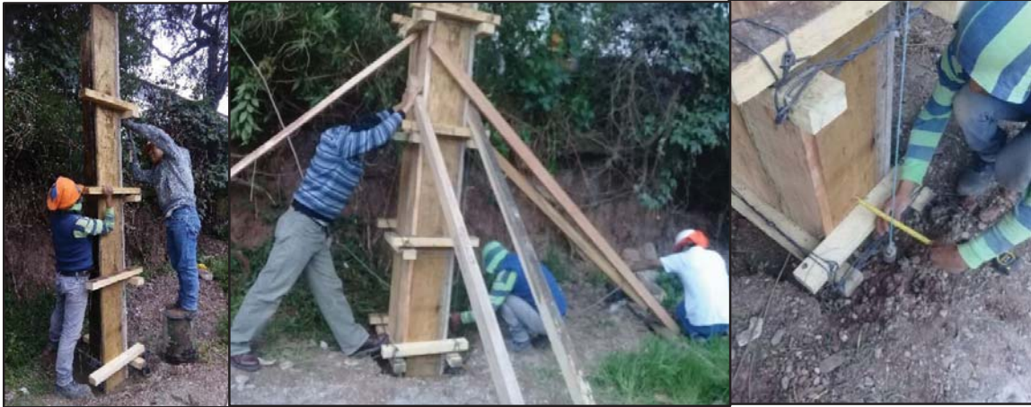
Figura N° 36: Encofrado de la columna.
