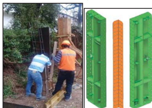
Figura N° 42: Encofrado de la columna.
