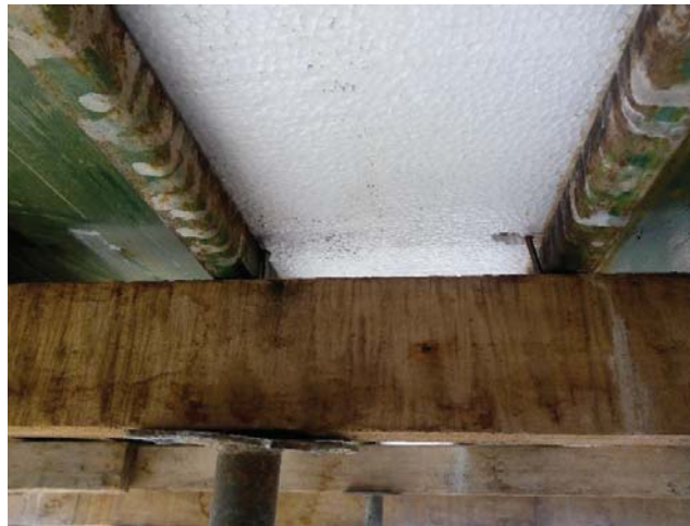
Figura N° 59: Asegurado de tecnopor en Solera.
