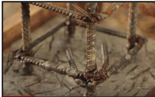
Figura N° 35: Corrugación para la adherencia del concreto.
