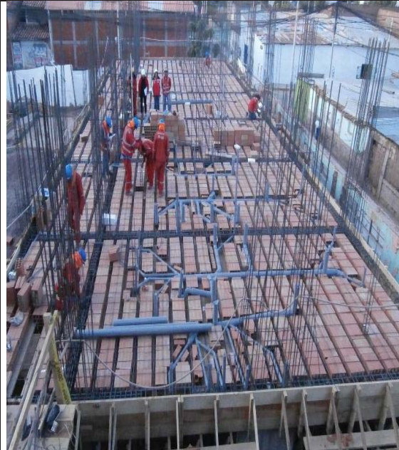
Encofrado de losa, colocando los ladrillos
