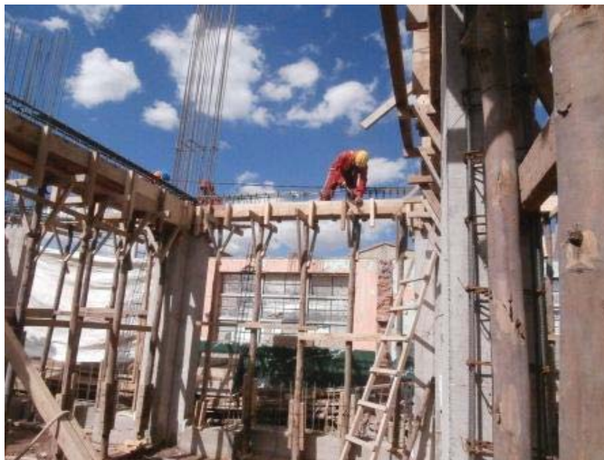
Figura N° 51: Fotografía del Encofrado de Vigas.
