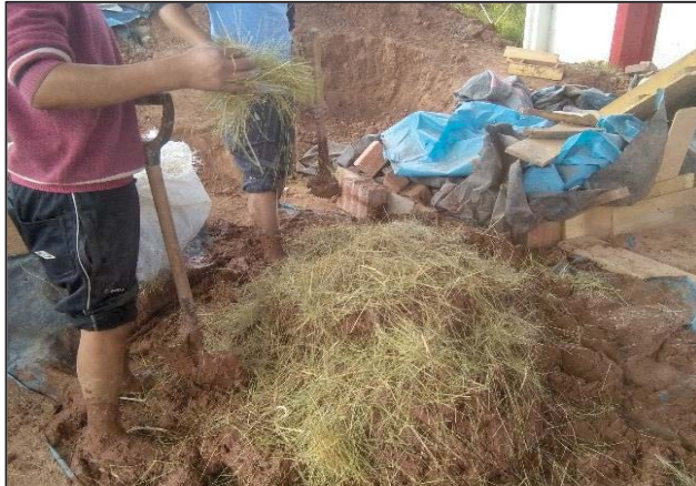
Mezcla Tipo 1 (Barro + 0.35% de paja + 0.00% de fibra de maguey)
