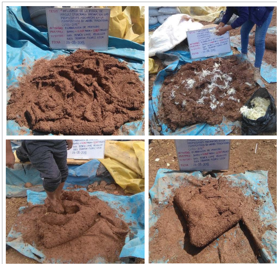
Figura 28. Preparación de mortero de barro para unidades de adobe.
