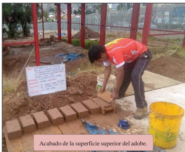
Colocación de una porción de barro dentro de la adobera.
