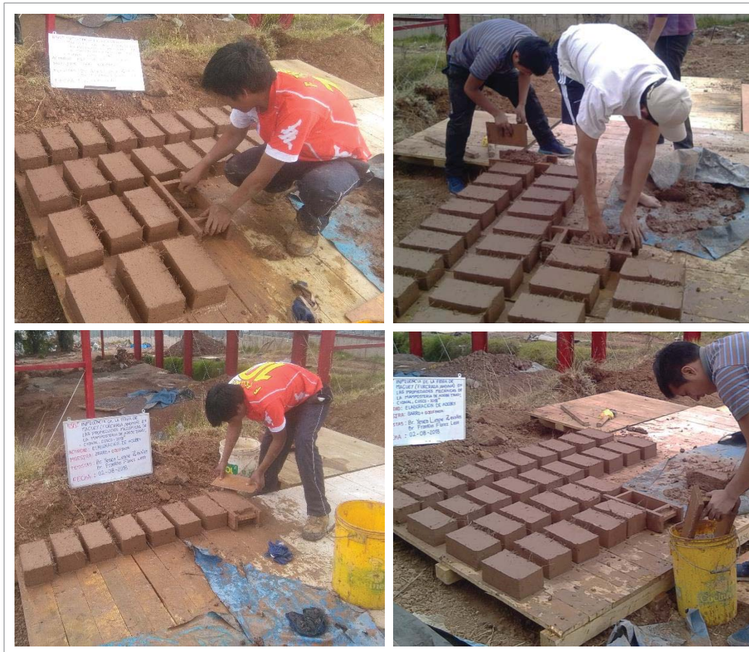
Figura 25. Proceso de elaboración de adobes.
