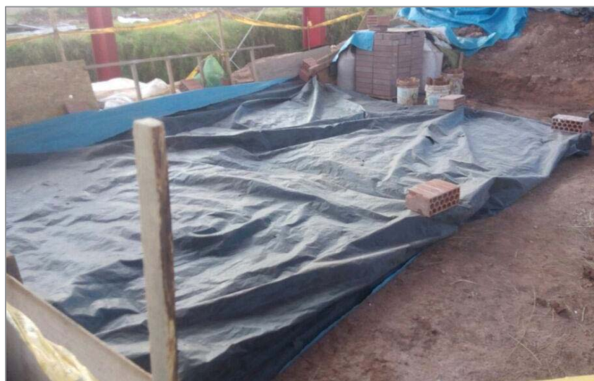
Figura 27. Protección de los adobes contra el secado brusco para evitar fisuramiento.
