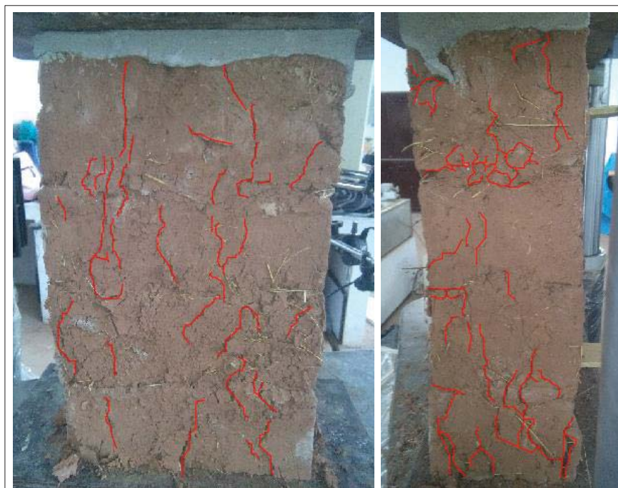
Figura 47. Tipo de falla en pila TIPO 2 muestra (M-02).
