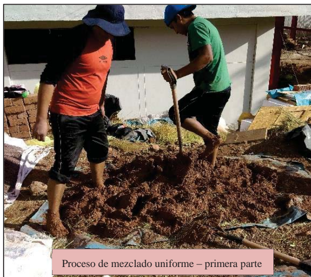
Dispersión de la paja en la mezcla de barro – primera parte.
