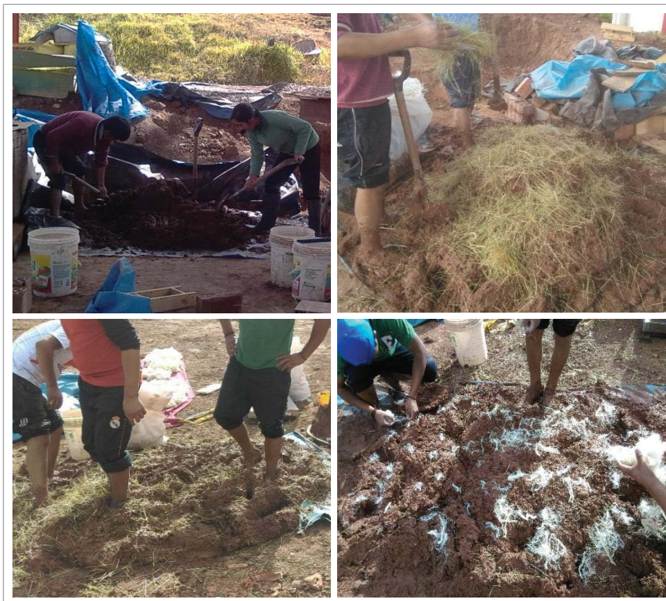
Figura 24. Proceso de preparación del barro para elaboración de adobes.
