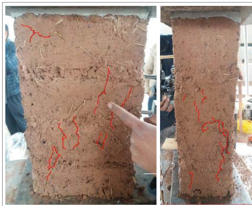
Figura 50. Tipo de falla en pila TIPO 5 muestra (M-02).
