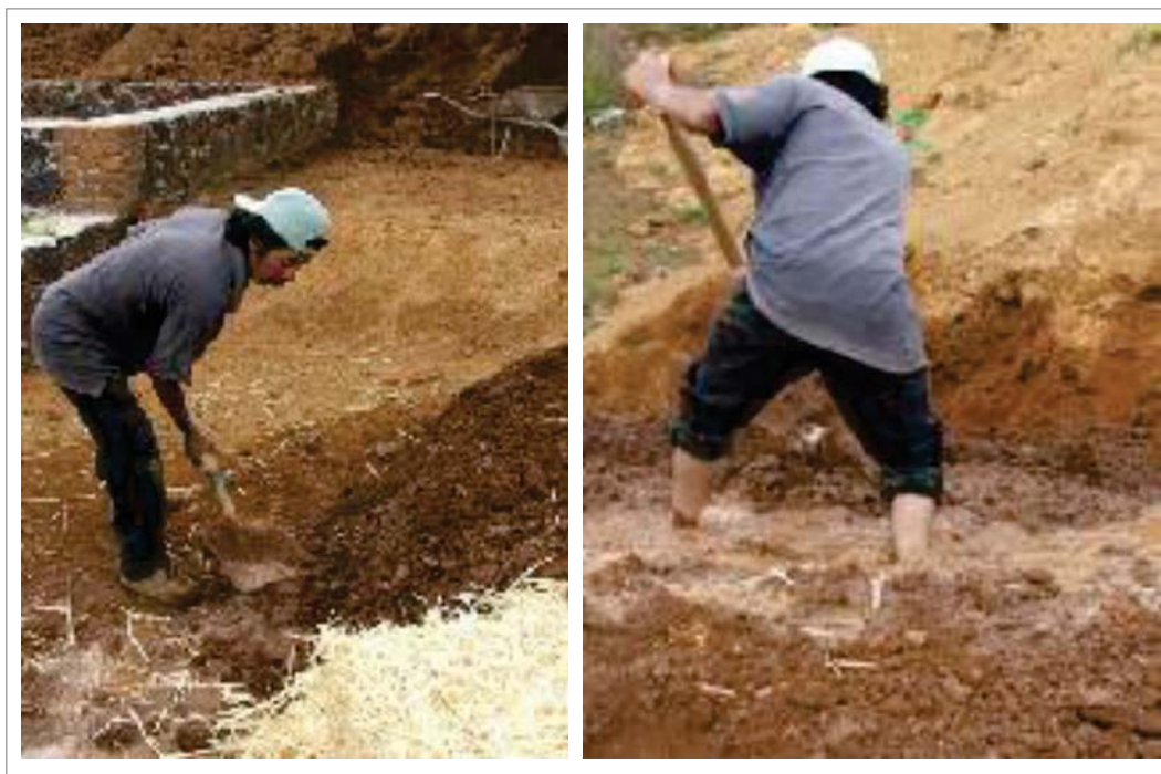
Figura 2. Preparación y mezclado del barro.
