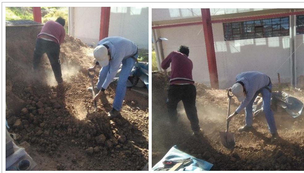
Figura 12. Extracción del suelo seleccionado para la elaboración de adobes.
