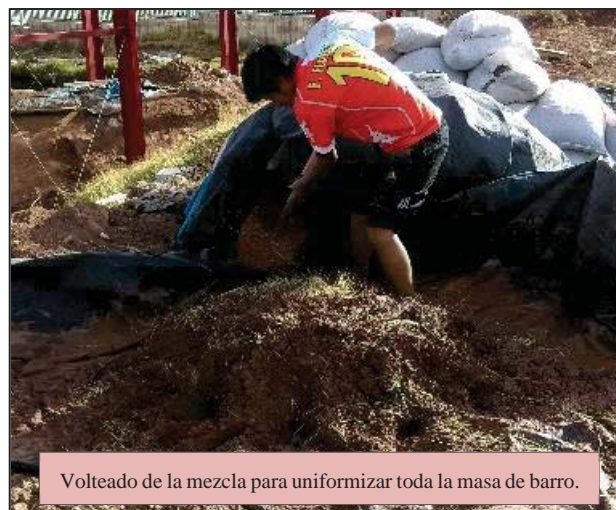
Pisado de la mezcla de tierra, agua, paja y fibra de maguey.
