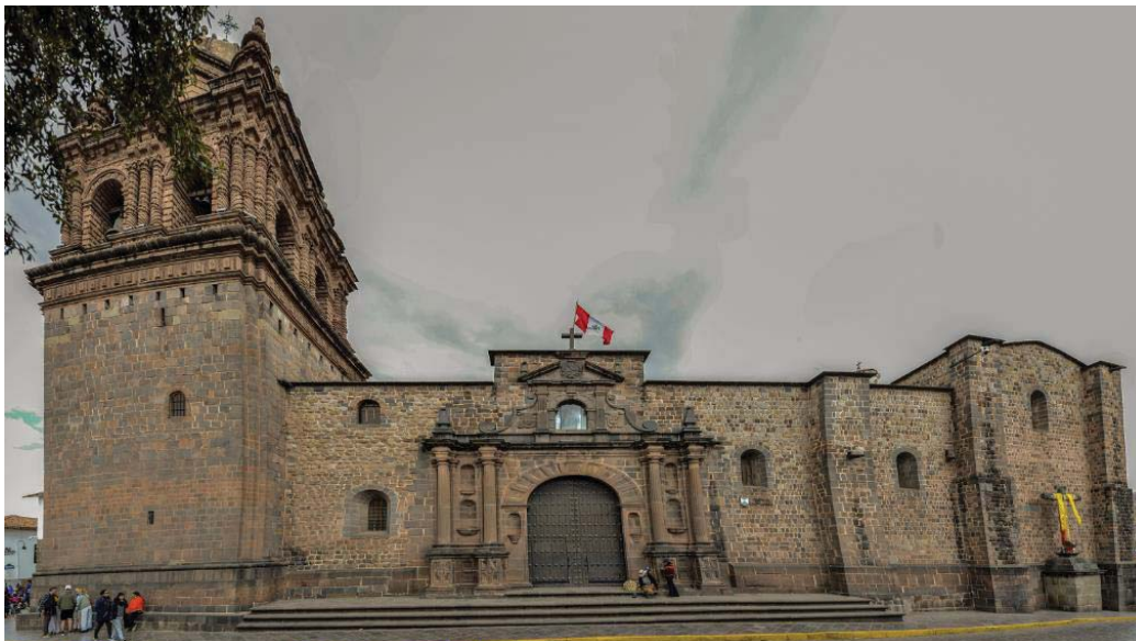
Fotografía N° 38. Fachada Retablo del Templo de Santo Domingo (Fuente propia, distorsión esférica).
