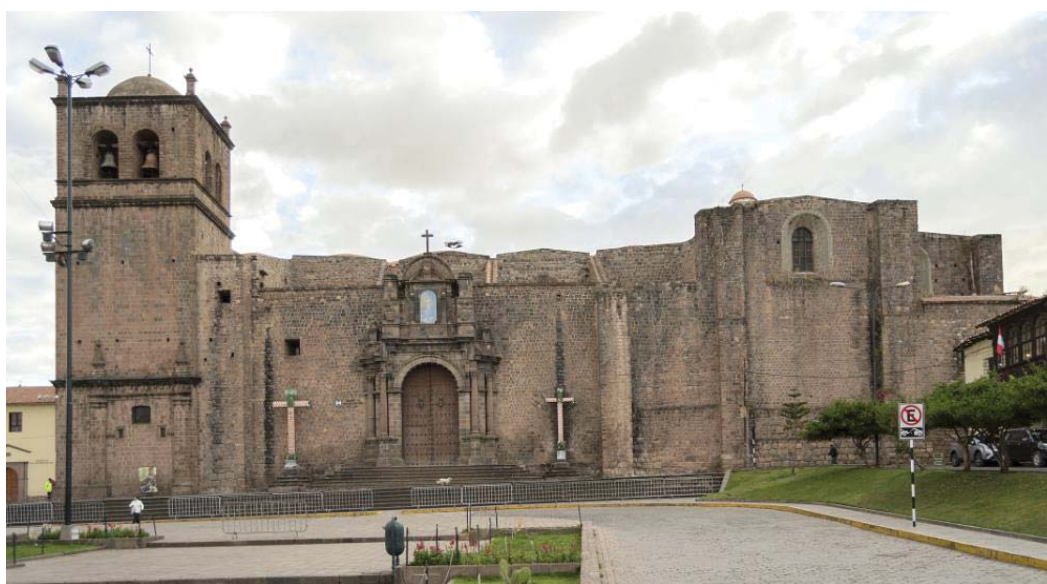
Fotografía N° 35. Fachada Retablo de San Francisco (Fuente propia).
