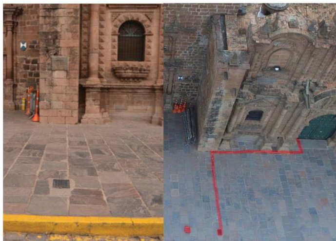
Imagen N° 19. Tubería de agua potable (Fuente propia).
