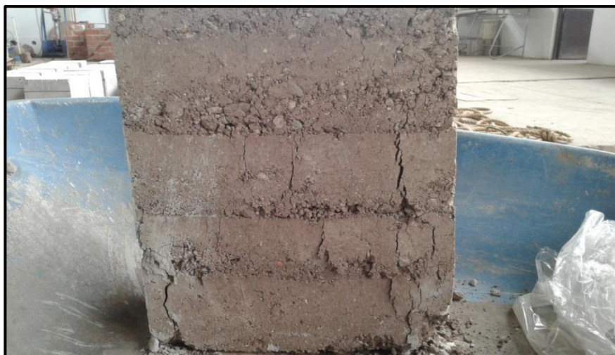
Falla en pila con agrietamientos verticales y desprendimiento de partículas.
