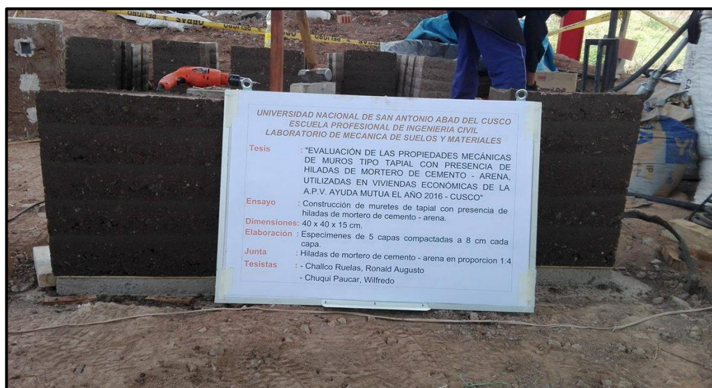
Culminación de la construcción de pilas y muretes de tapial reforzados con hiladas de mortero de cemento - arena.
