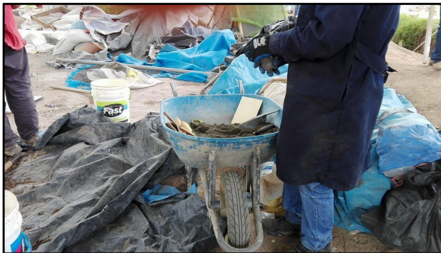
Mortero de refuerzo
