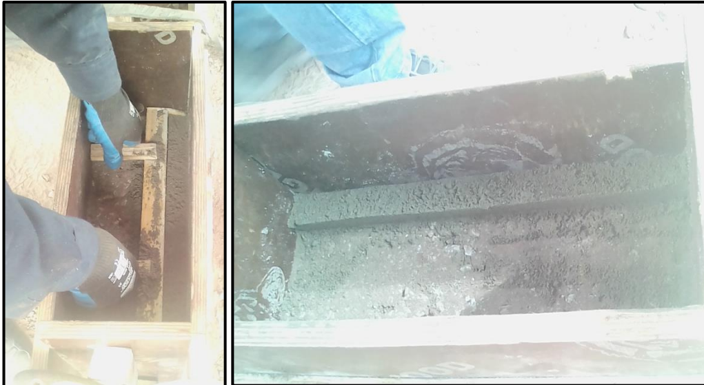
Colocado de las hiladas de mortero de cemento - arena como refuerzo para el tapial.
