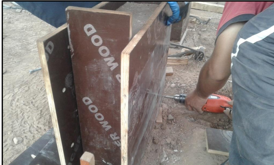
Desenformado de muro tapial.
