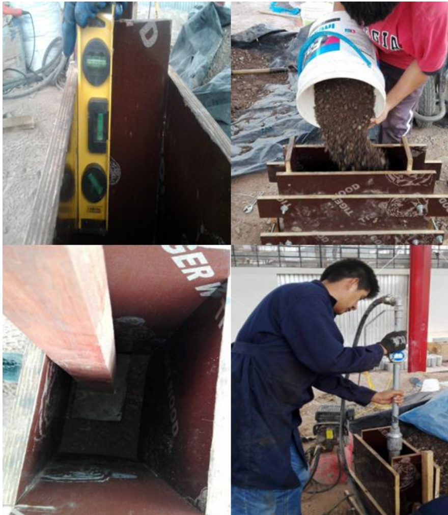
Figura 26. Acciones para verificar la verticalidad del molde, esparcir y compactar la mezcla de tierra - agregado.
