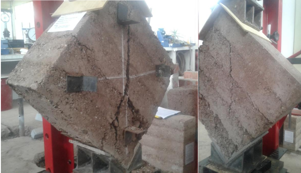
Figura 48. Falla mixta en el murete cuadrado típico (MT-1)
