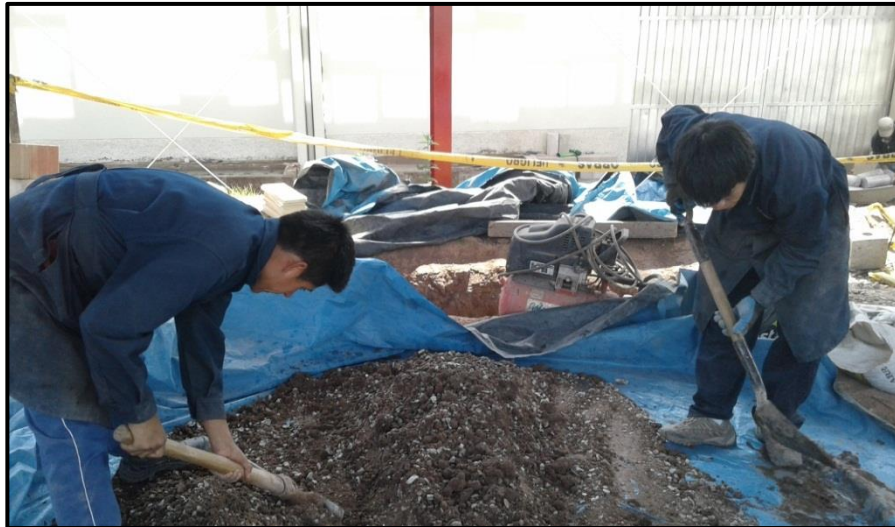
Mezclado de material para tapial.
