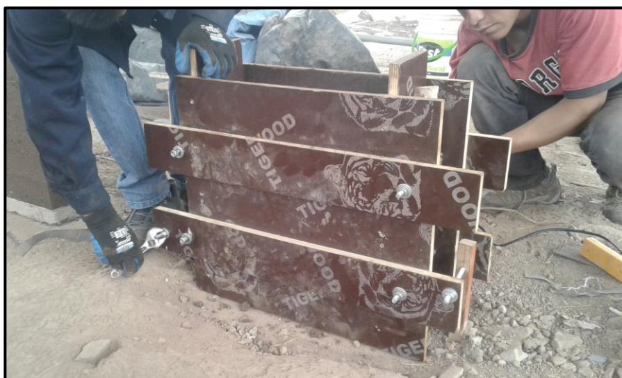
Colocado de encofrado sobre superficie para compactado.
