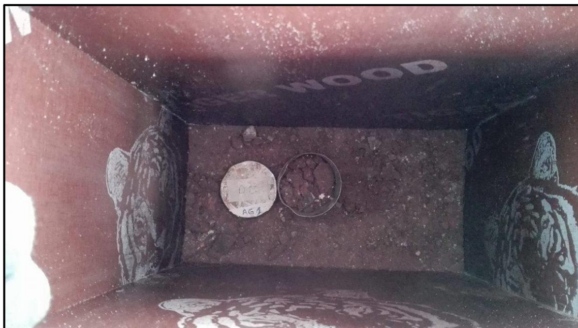
Control de humedad durante la compactación de la tierra.
