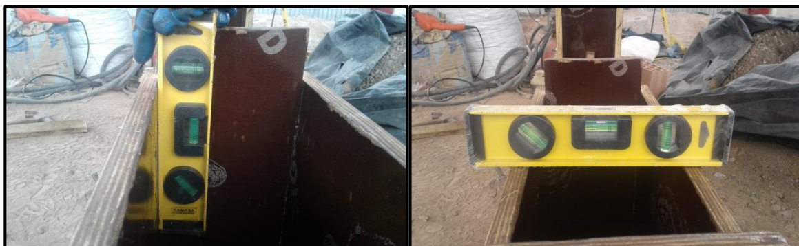
Control vertical y horizontal de los encofrados.
