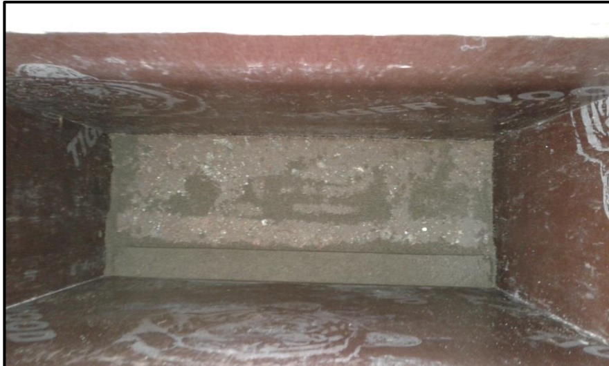
Vista de mortero de cemento-arena en el proceso de elaboracion de muro reforzado.
