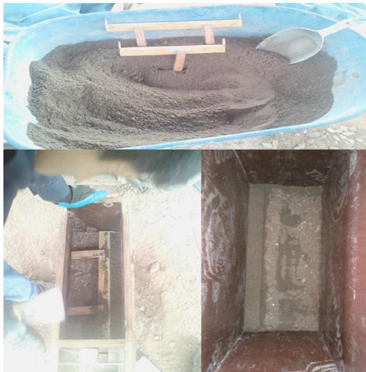
Figura 28. Preparación del mortero y construcción de hiladas en las juntas del tapial. Fuente: Elaboración propia.
