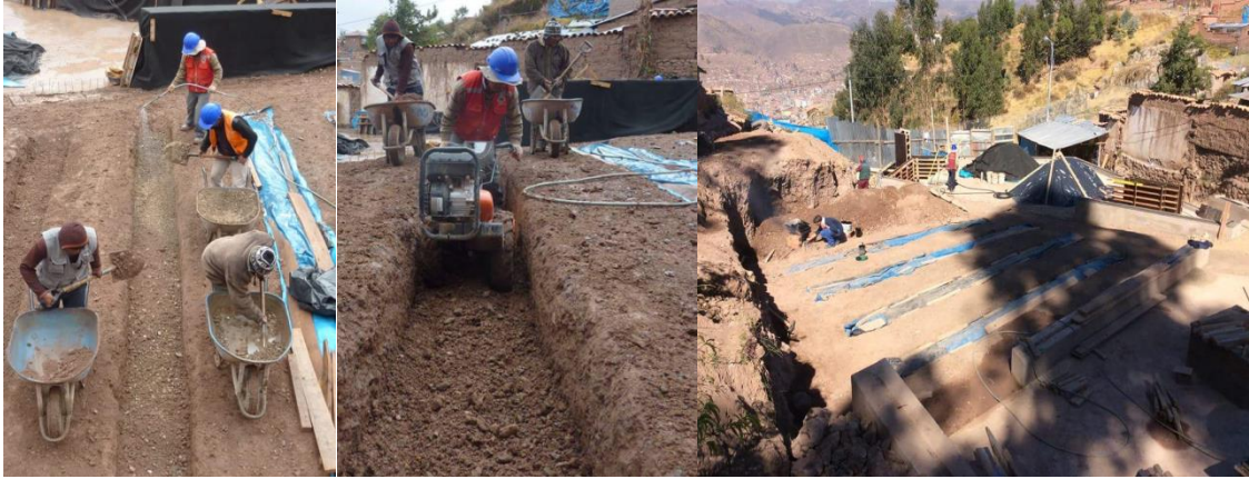
Actividades para mezclar la tierra con los agregados.
