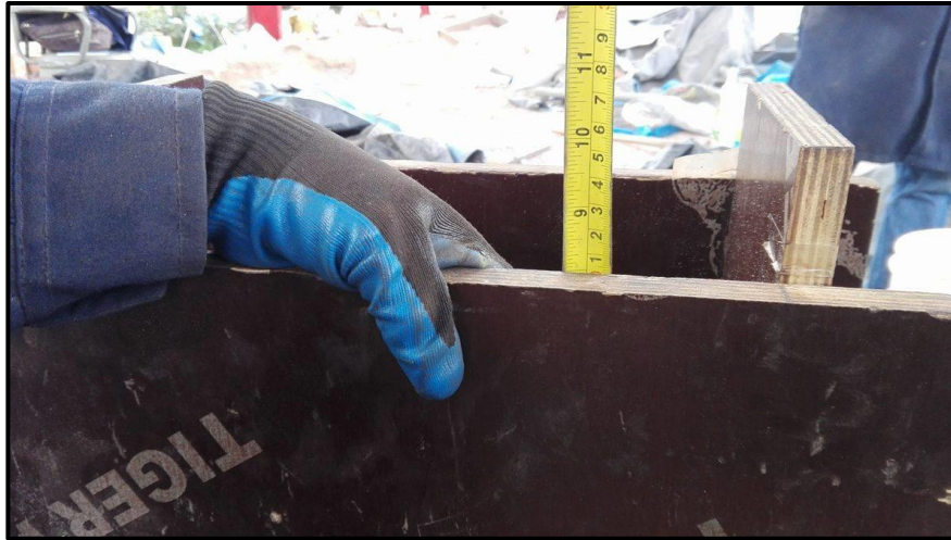
Control de compactado mediante alturas de compactación.
