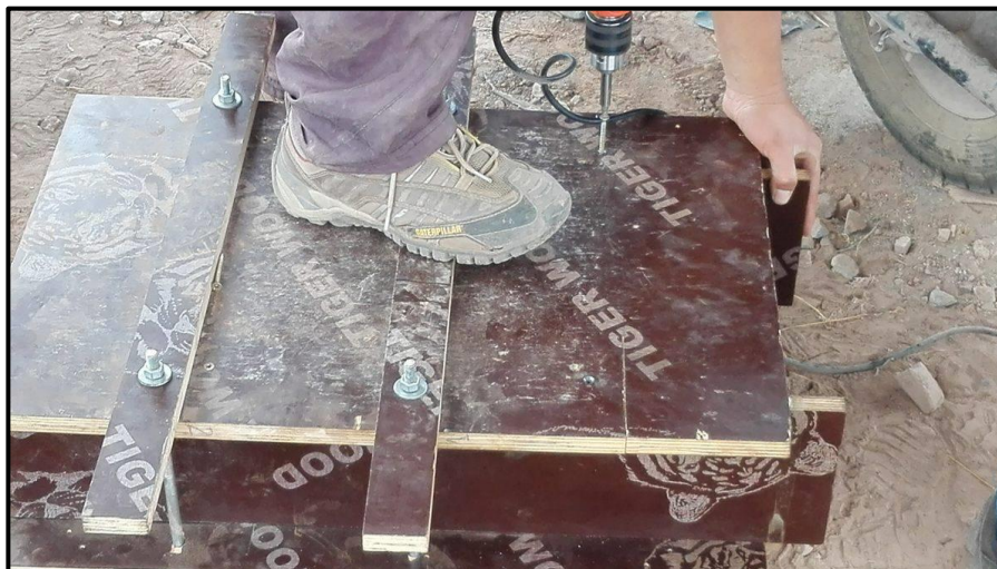
Armado de encofrado.
