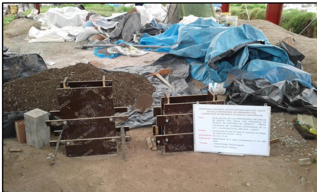
Encofrado de pilas y muretes.
