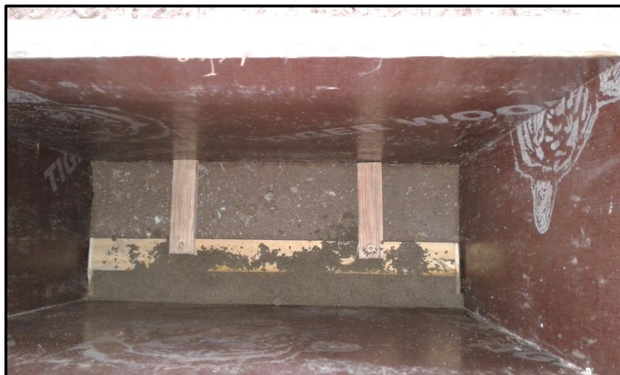
Colocacion del mortero para refuerzo en encofrado con pendiente 2H:1V
