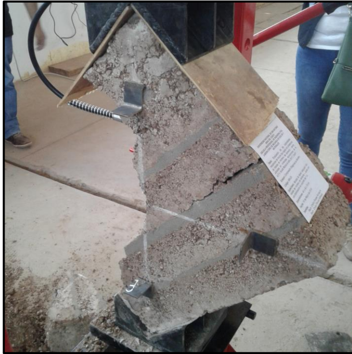
Falla completa del muro reforzado.
