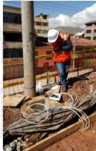
Figura 4 los sensores de temperatura ingresan por debajo del encofrado lateral de pavimento
