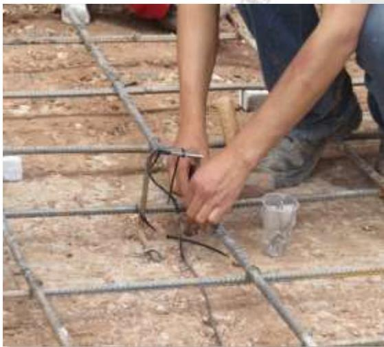
Figura 3 Colocación de Sensores de temperatura por medio de grapas en la progresiva km 1+145
