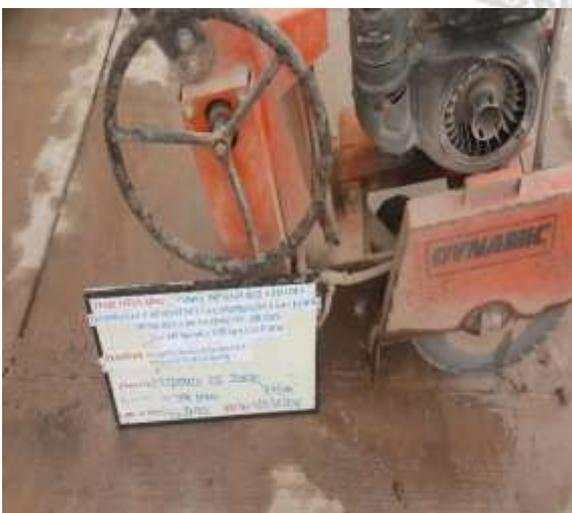
Figura 11 Aserrado de juntas de concreto en la pavimentación
