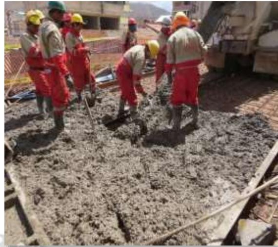
Figura 2 pavimentación con concreto premezclado Av.tupac amaru tramo III
