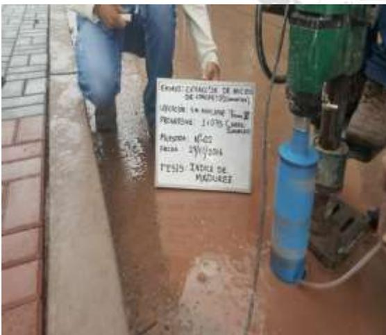
Figura 17 Extracción de núcleos de diamantina de la pavimentación
