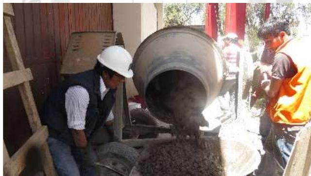
**Figura 6.3** Elaboración del concreto
