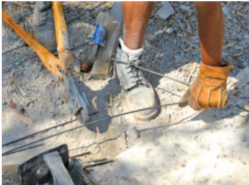
Figura 10. Corte del alambre a la longitud deseada. (De-Acero, 2010)
