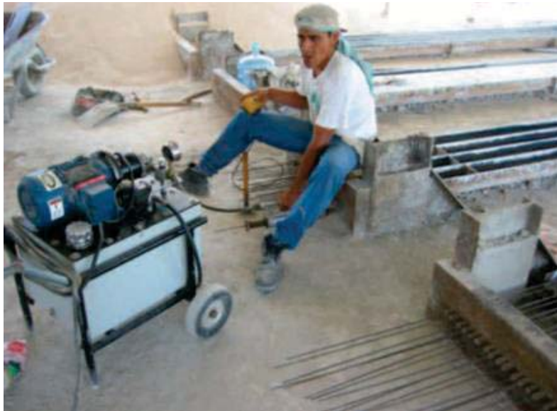
Figura 14. Tensado del alambre, por medio de un equipo hidráulico. (De-Acero, 2010)
