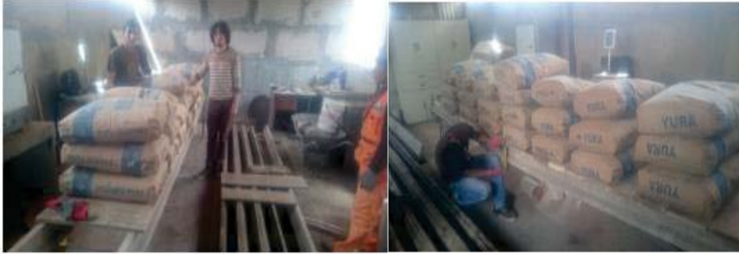
Figura 85. Carga de bolsas superando la resistencia de diseño.
