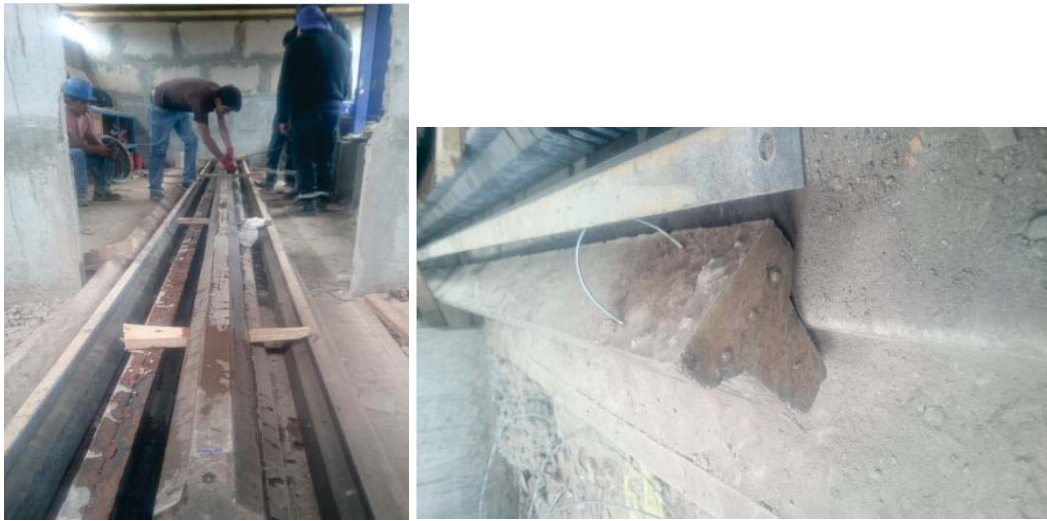
Figura 71. Destensado y desencofrado.
