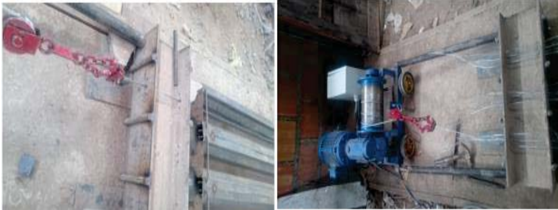
Figura 69. Tensado del acero.
