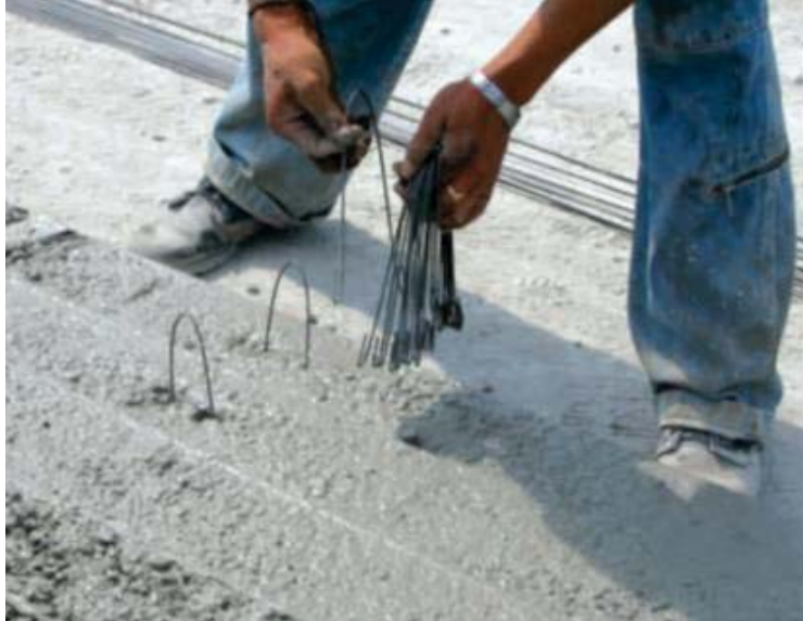
Figura 19. Colocación de los ganchos de alambre. (De-Acero, 2010)
