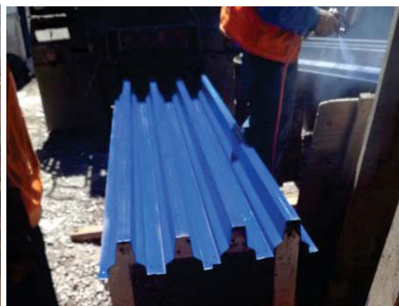
Figura 39. Doblado del molde
