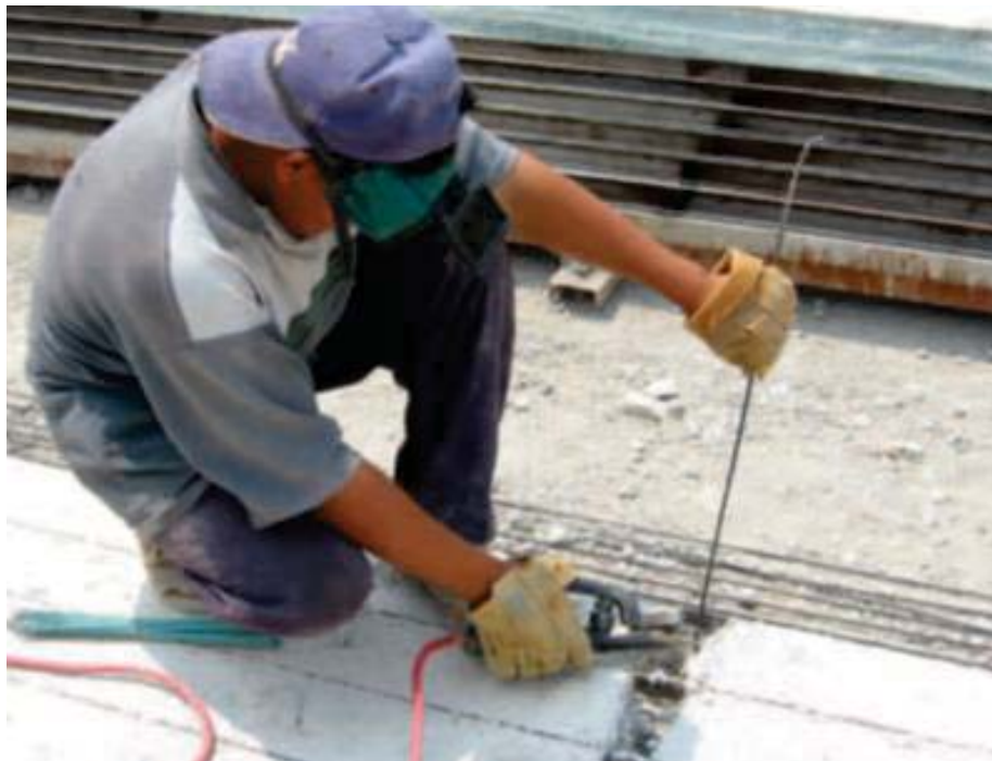
Figura 20. Destensado del alambre pre esforzado. (De-Acero, 2010)
