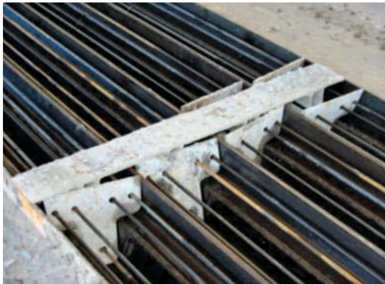
Figura 12. Colocación de separadores. (De-Acero, 2010)
