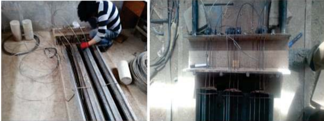
Figura 68. Colocación del acero.
