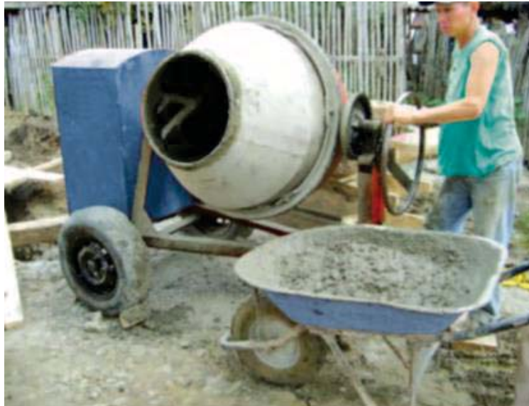
Figura 15. Fabricación del concreto para las viguetas pre esforzadas. (De-Acero, 2010)
