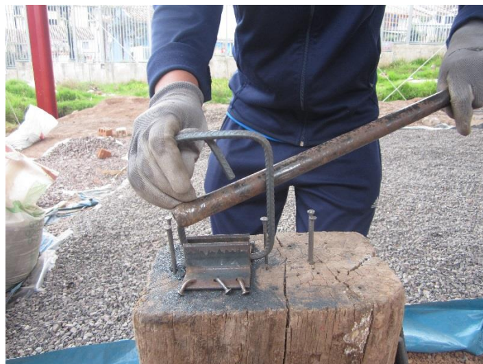
Figura 69. Habilitado de los estribos.
