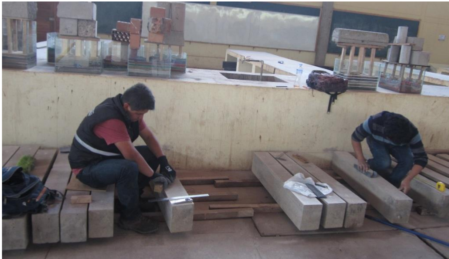
Figura 76. Lijado de la superficie de apoyo.
