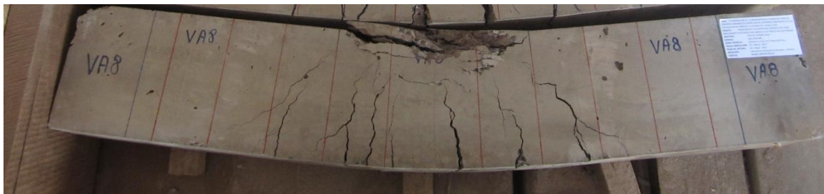
Figura 105. Aspecto de viga V-A8 concluido el ensayo
