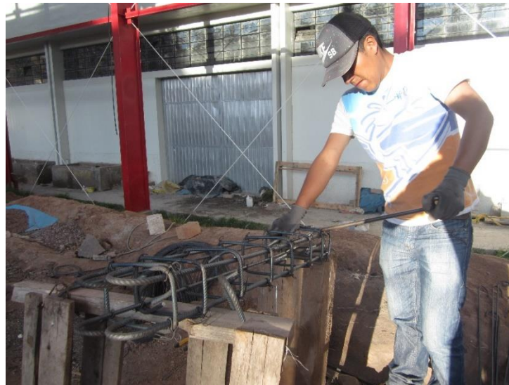
Figura 70. Armado de vigas acorde a lo estipulado en el diseño - laboratorio de Materiales y Mecánica de Suelos de la Escuela Profesional de Ingeniería Civil
