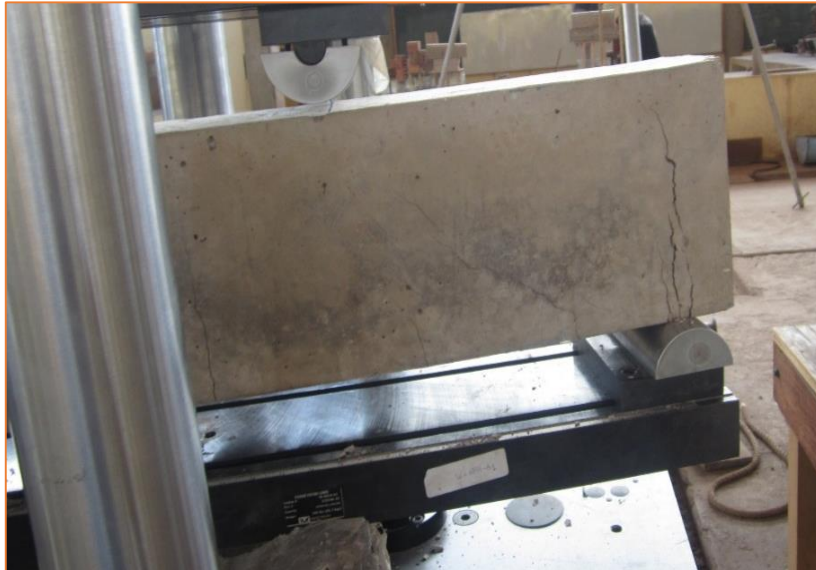
Figura 54. Fisura debido a la concentración de esfuerzos en el apoyo de la viga V-B
