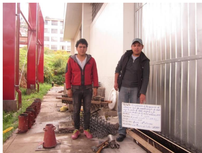
Figura 71. Colocado de armadura de acero en los encofrados
