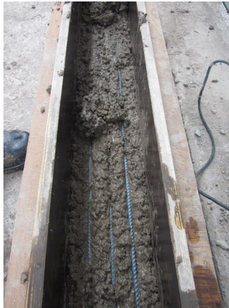
Figura 73 Vaciado de vigas
