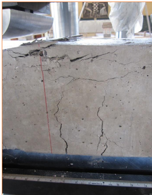
Figura 61. Aspecto final de la viga V-D en la falla.
