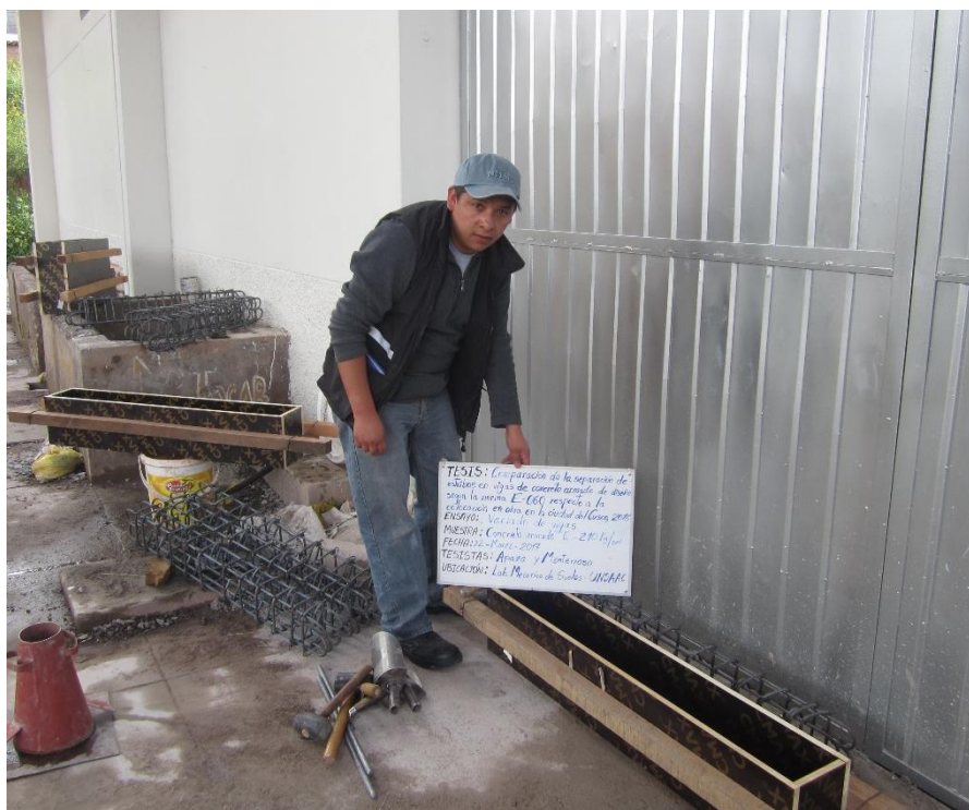
Figura 62. Encofrados habilitados de Triplay fenólico
