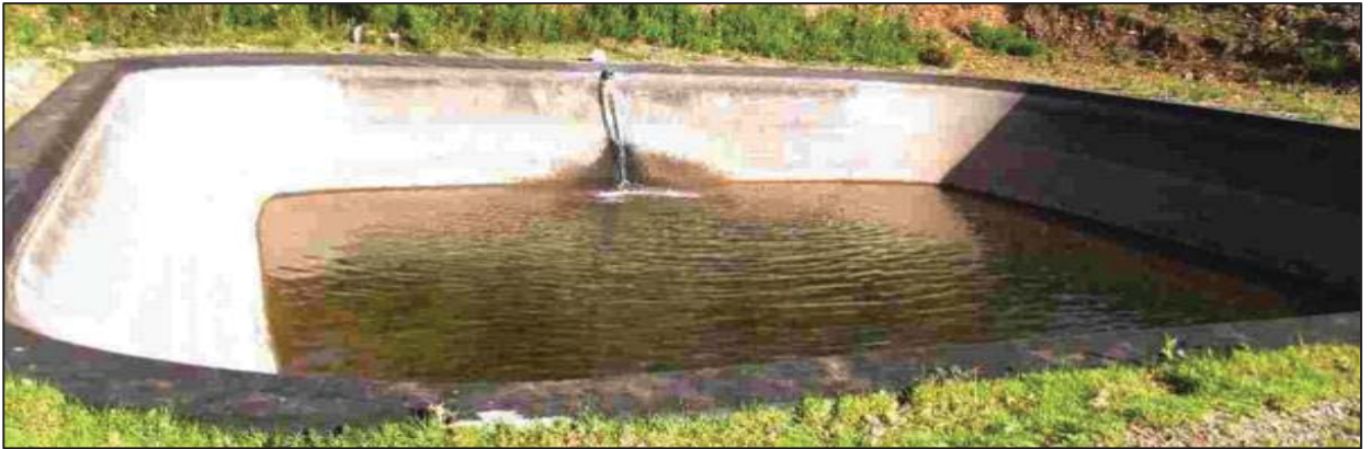
FOTO N° 0 3: RESERVORIO DE RIEGO C.C. QORICANCHA.
