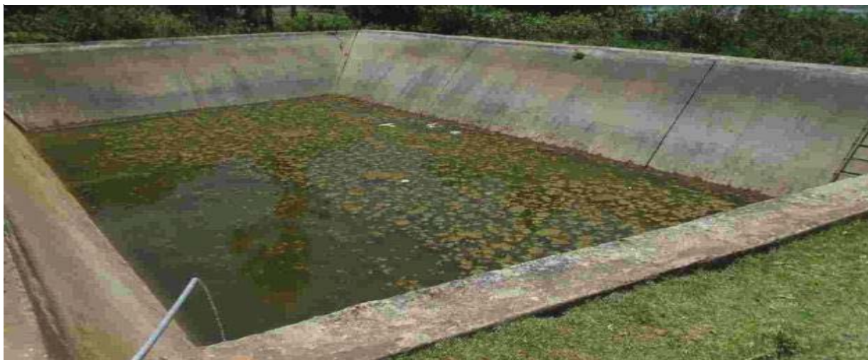
FOTO N° 05: INFRAESTRUCTURA DE RIEGO SECTOR PUKAMARCA
