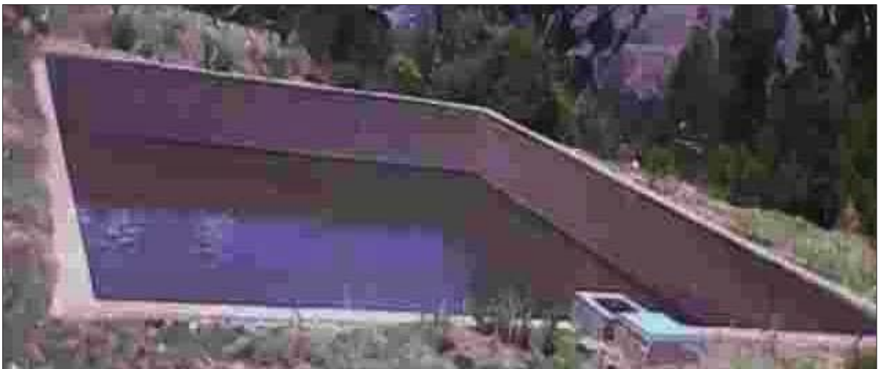
FOTO N° 0 4: RESERVORIO DE RIEGO C.C. TAUCCA.
